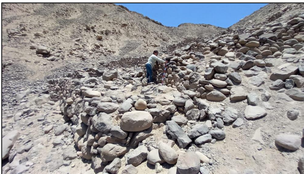
Fotos N° 22 vista de detalle del muro que presenta una construcción de terrazas con piedra angulosas empleando una técnica de pircado - Sector A.
