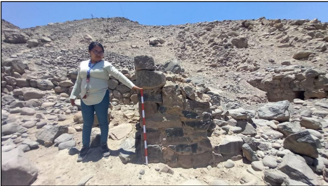
Foto N° 19 – vista en detalle de un muro arquitectónico del sector A.
