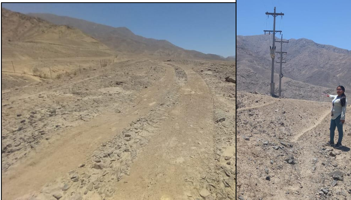
Foto N° 05 – vista panorámica de las afectaciones que presenta en el sector A.
