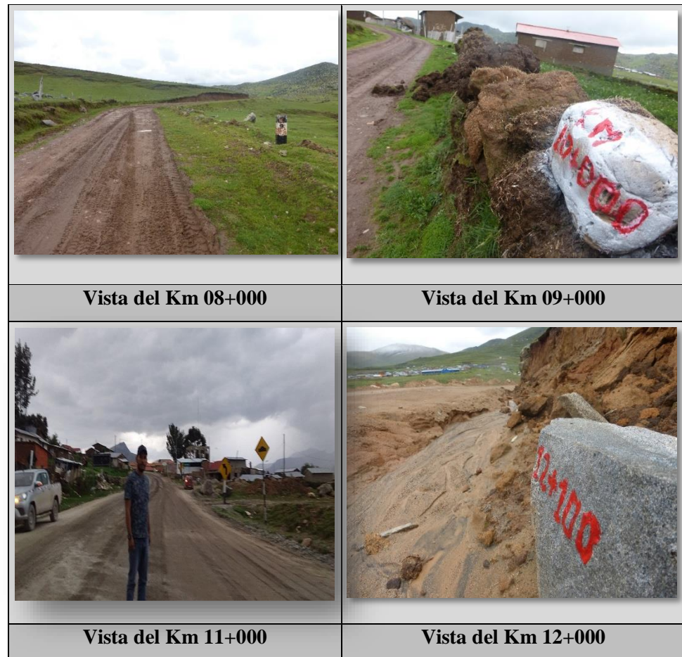
Figura N° 5.3: Vistas del tramo Km 08+000 al Km 12+000
