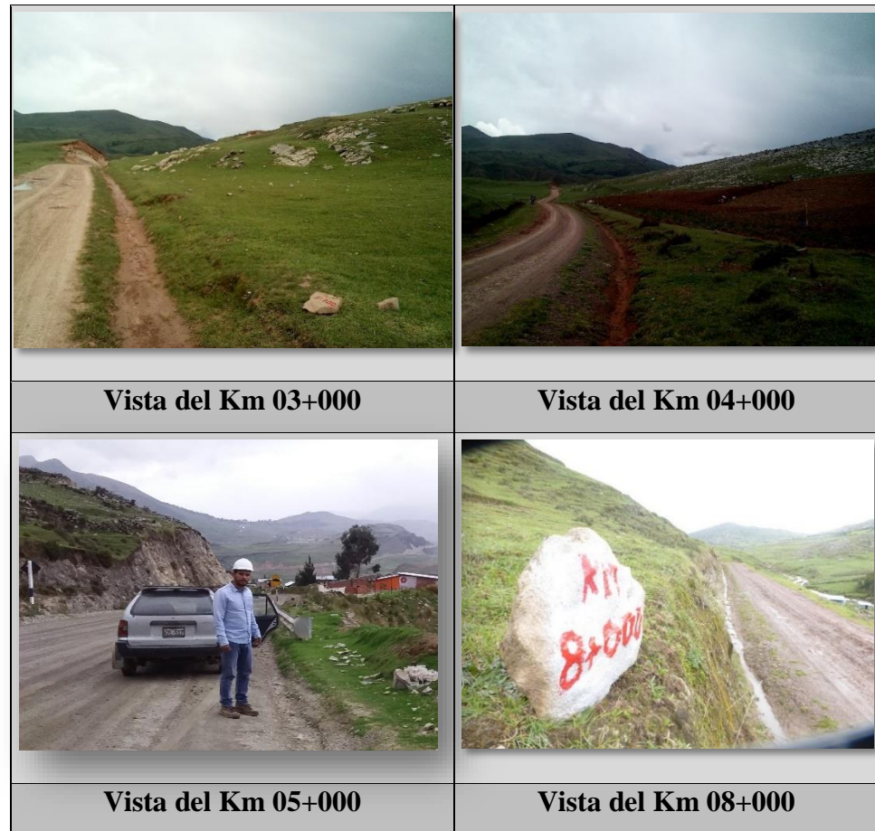
Figura N° 5.2: Vistas del tramo Km 03+000 al Km 08+000
