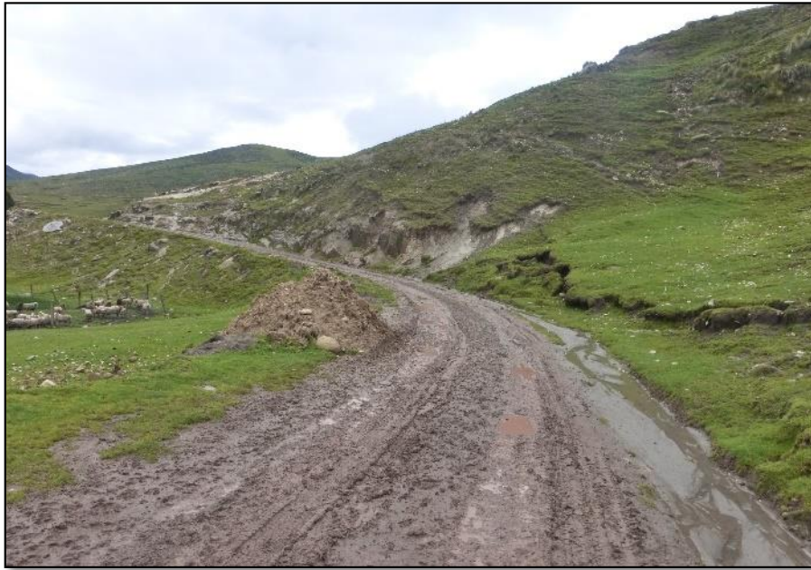
Foto 05: Vista del estado actual del camino vecinal
