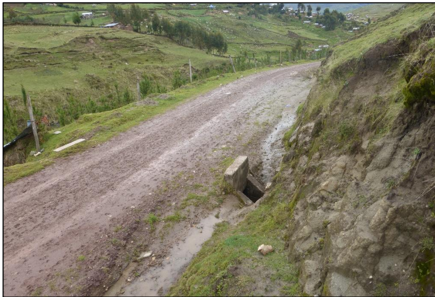
Foto 04: Vista del estado actual de las alcantarillas artesanales
