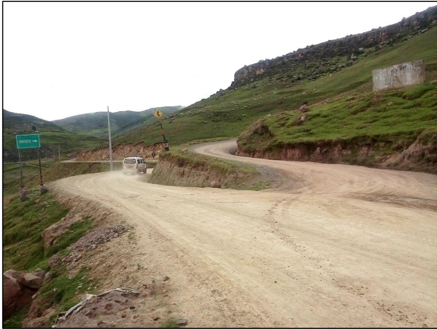
Foto 01: Inicio del tramo ramal Choqueca
