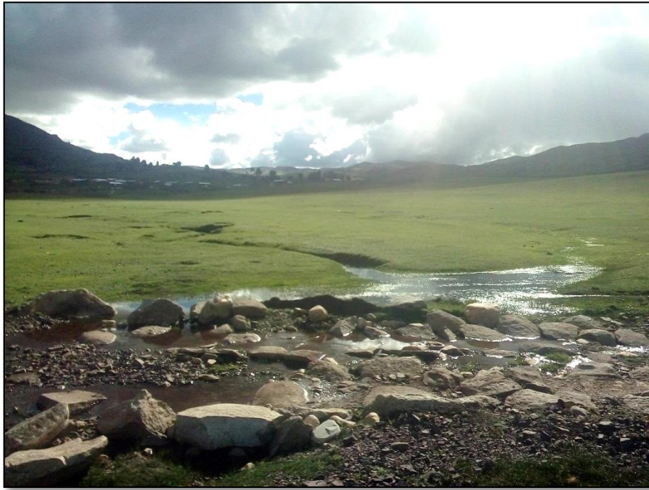
Foto 09: Vista del estado actual del camino vecinal KM -17+000
