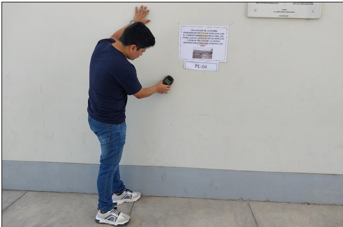
Verificación de elementos de concreto armado PL- del pabellón de la facultad de Derecho y Ciencia Política de la ciudad universitaria, San Luis Gonzaga.
