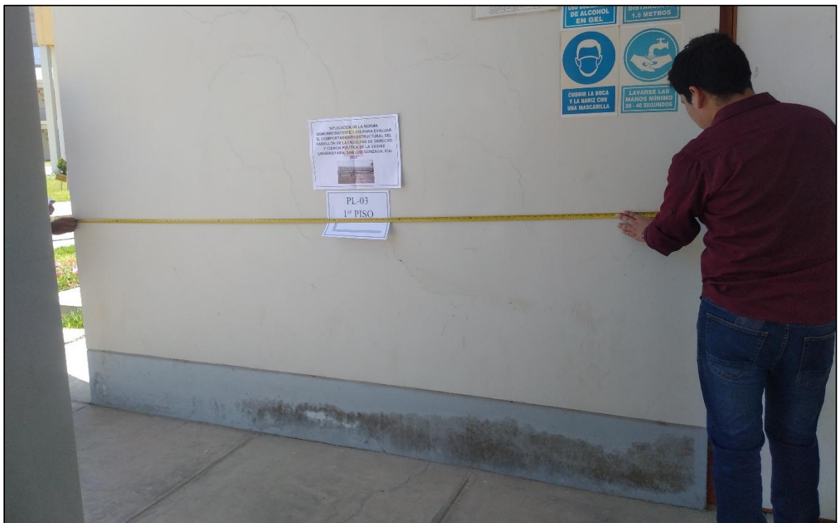
Verificación de medidas de la placa PL-03(1er piso) del pabellón de la facultad de Derecho y Ciencia Política de la ciudad universitaria, San Luis Gonzaga.
