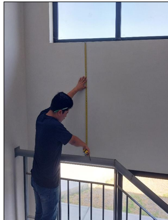
Verificación de peraltes de las vigas (3er piso) del pabellón de la facultad de Derecho y Ciencia Política.
