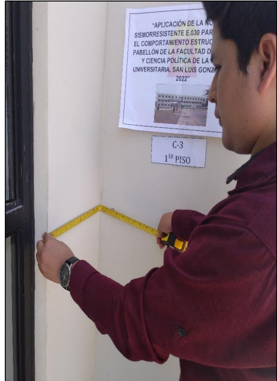
Verificación de medidas de la columna C-3 tipo "L" (1er piso) del pabellón de la facultad de Derecho y Ciencia Política de la ciudad universitaria, San Luis Gonzaga.
