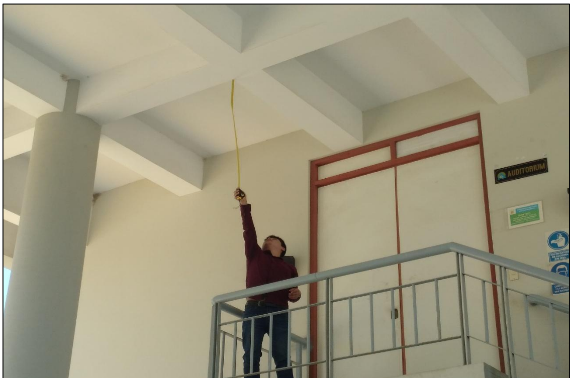
Verificación de peraltes de las vigas (2do piso) del pabellón de la facultad de Derecho y Ciencia Política de la ciudad universitaria, San Luis Gonzaga. Fuente: Propia
