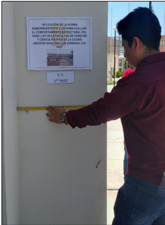
Verificación de medidas de la columna C-3 tipo "L" (1er piso) del pabellón de la facultad de Derecho y Ciencia Política de la ciudad universitaria, San Luis Gonzaga.
