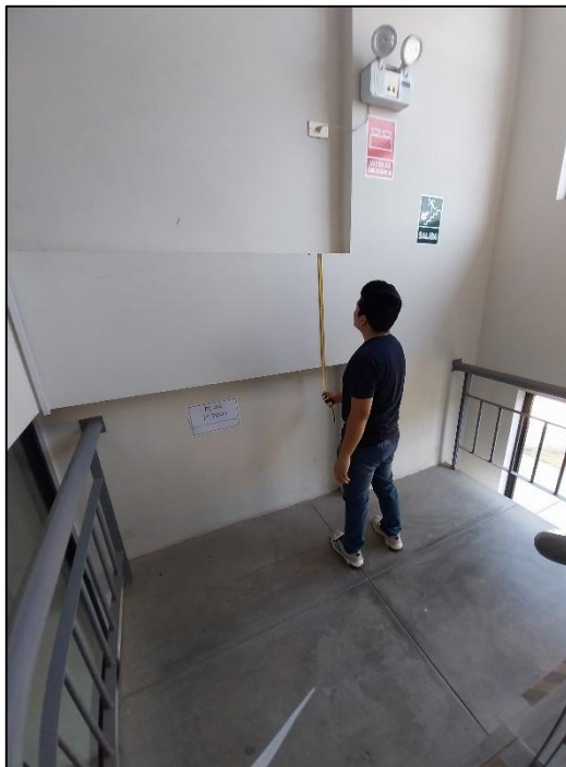
Verificación de peraltes de las vigas (3er piso) del pabellón de la facultad de Derecho y Ciencia Política.
