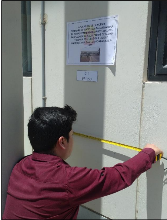
Verificación de medidas de la columna C-1 tipo rectangular (1er piso) del pabellón de la facultad de Derecho y Ciencia Política de la ciudad universitaria, San Luis Gonzaga. Fuente: Propia
