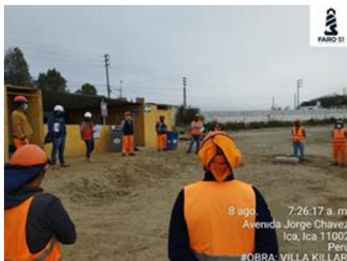
Figura 12. Inducción de seguridad y salud en el trabajo
