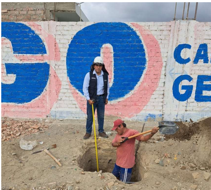
Fig. 5 Proceso de excavación de calicatas en la zona del proyecto
