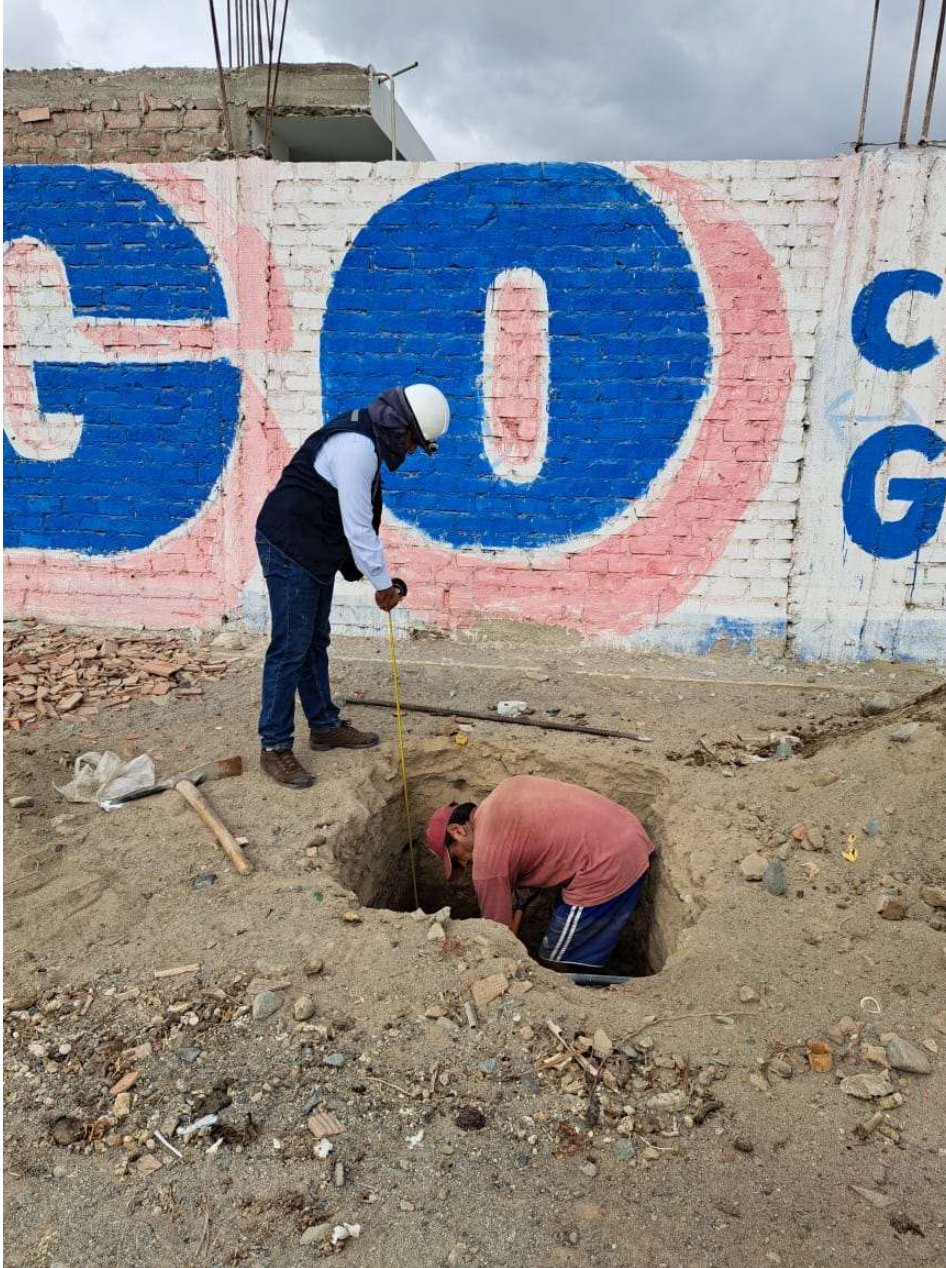
Foto 1. Excavación de calicatas en la zona del proyecto
