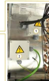
1- Caja de bornes para desescarche eléctrico 2- Caja de bornes para ventiladores
