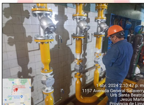
Figura 06: Trabajador revisando los acabados de pintura para evitar la pronta corrosión en la tubería de acero al carbono tipo cédula SCH40 de 4”.
