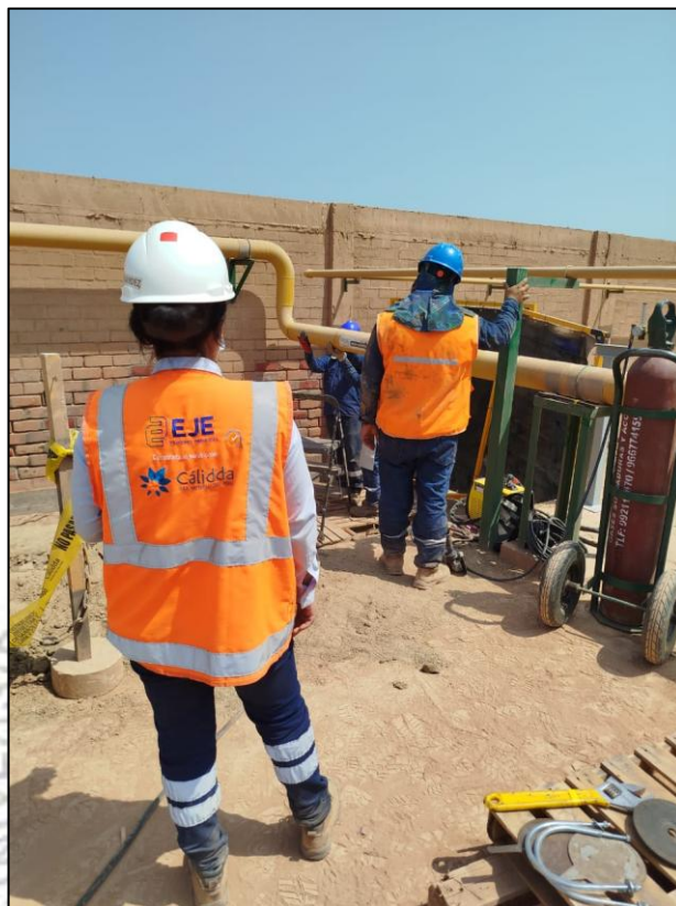
Figura 06: Trabajador revisando los acabados de pintura para evitar la pronta corrosión en la tubería de acero al carbono tipo cédula SCH40 de 4”.
