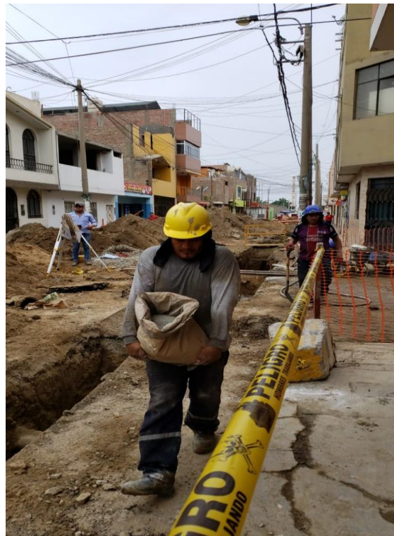
Se colocó cinta señalizadora de peligro
