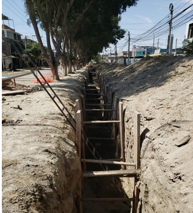
Se realizó apuntalamiento en las paredes de las zanjas
