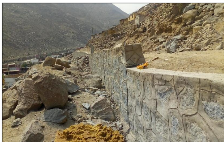
Fig. 74 Muros de contención de piedra - Distrito de Ricardo Palma en Lima
