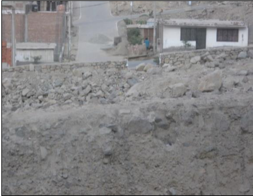
Fig. 8 Vista de la margen derecha de la quebrada se observan las viviendas.
