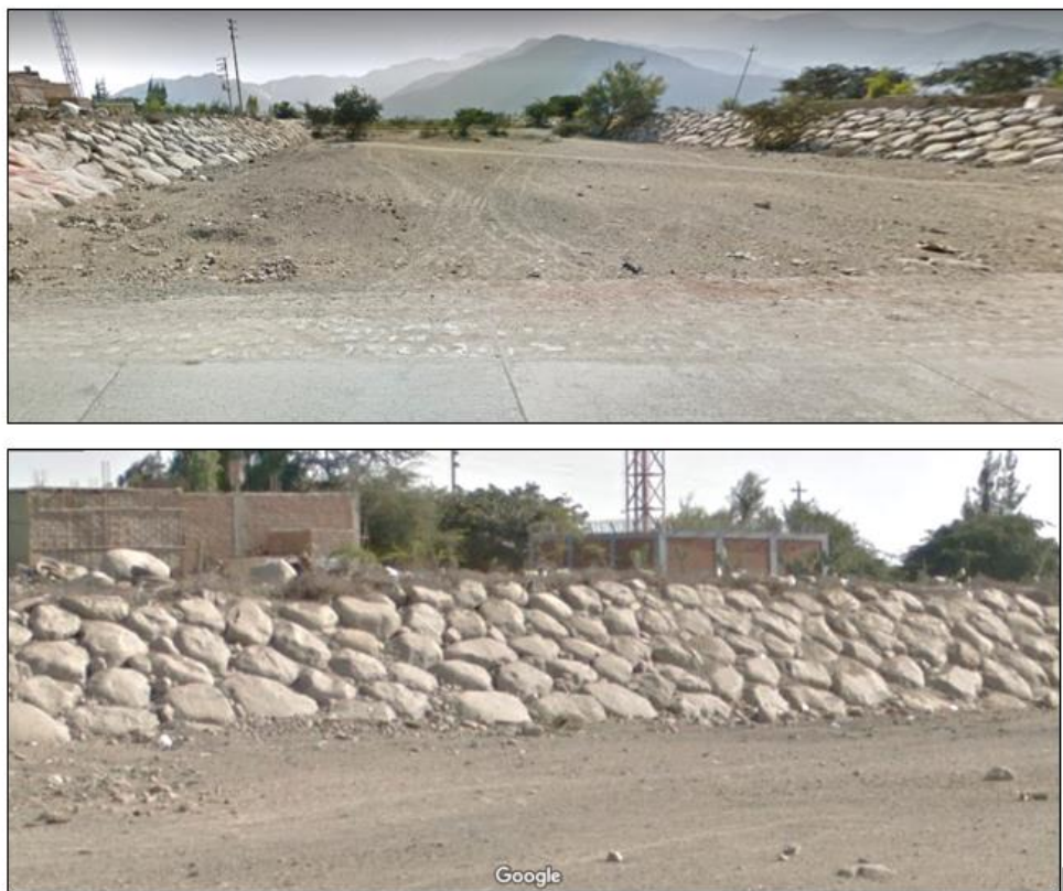
Fig. 75 Enrocados en la quebrada - Distrito de Los Molinos en Ica.
