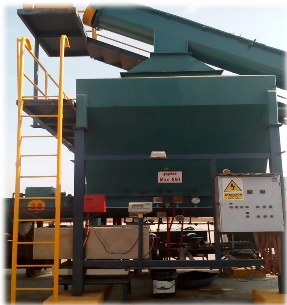
Figura 14: Adición del antioxidante Fuente: CFG Investment
