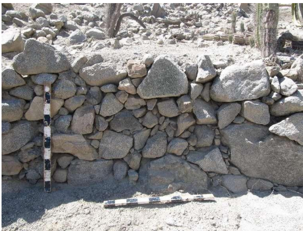
Figura 36: Vista de detalle de la mampostería ordinaria emplazado en el sector 1' A' (Sandro Huamani Salazar).
