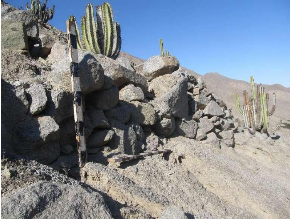
Figura 19: Vista de detalle de la terrazas o muro de contención emplazados en el sector 1" A" (Sandro Huamani Salazar).
