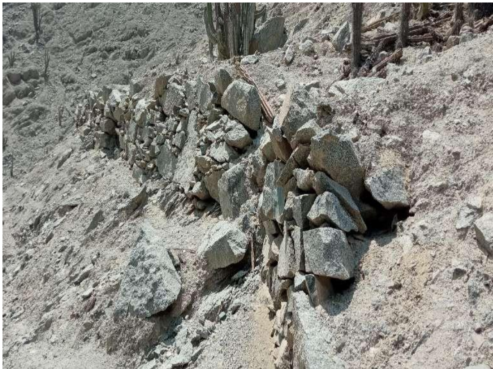
Figura 23: Vista del muro de contención, orientación de la foto de oeste - este emplazado en el sector 1" A" (Sandro Huamani Salazar).
