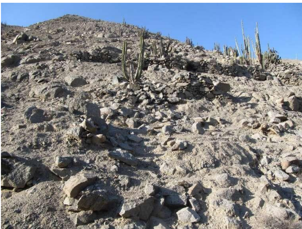
Figura 18: Vista del sector 1' A' donde se emplazan las terrazas o muro de contención (Sandro Huamani Salazar).
