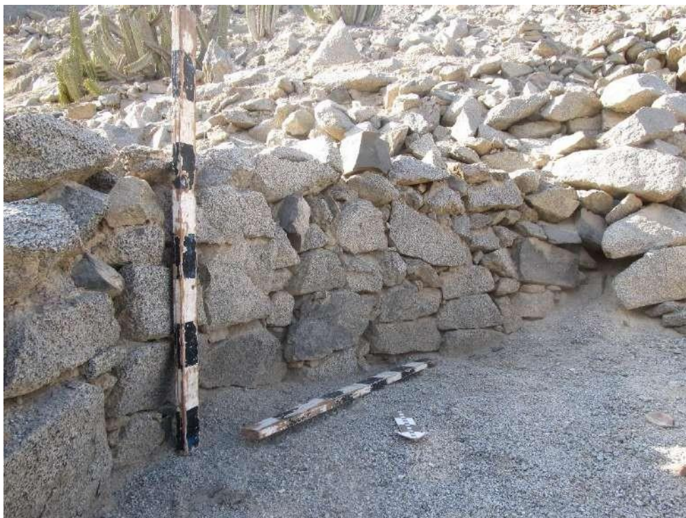
Figura 35: Vista de detalle de la mampostería ordinaria emplazado en el sector 1' A' (Sandro Huamani Salazar).
