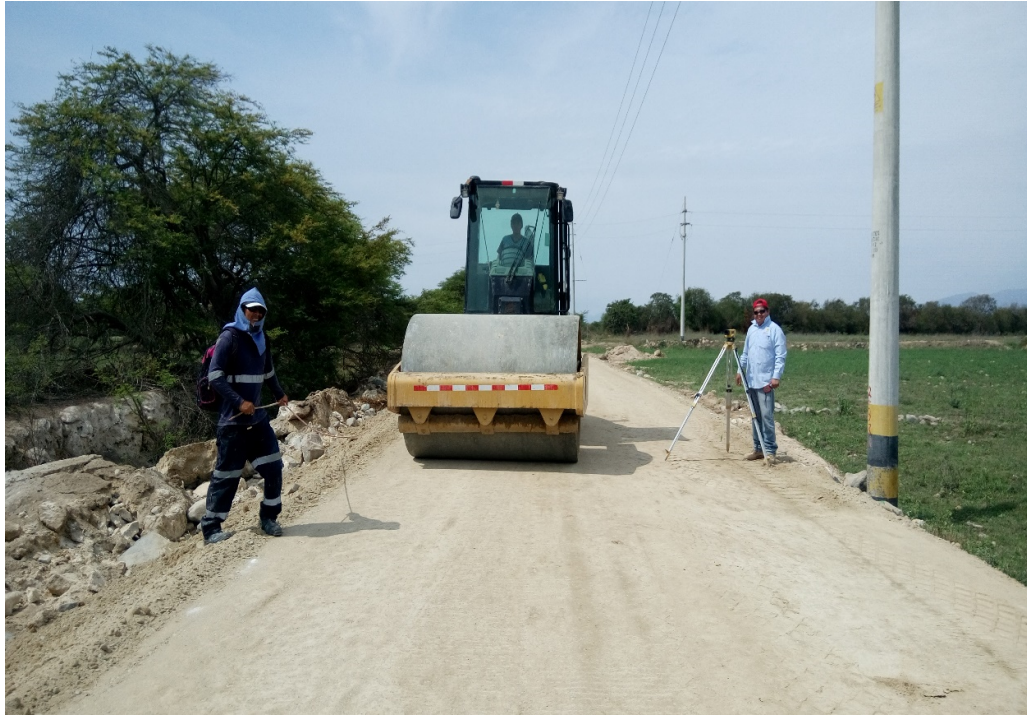
Trazo y replanteo en pontones
