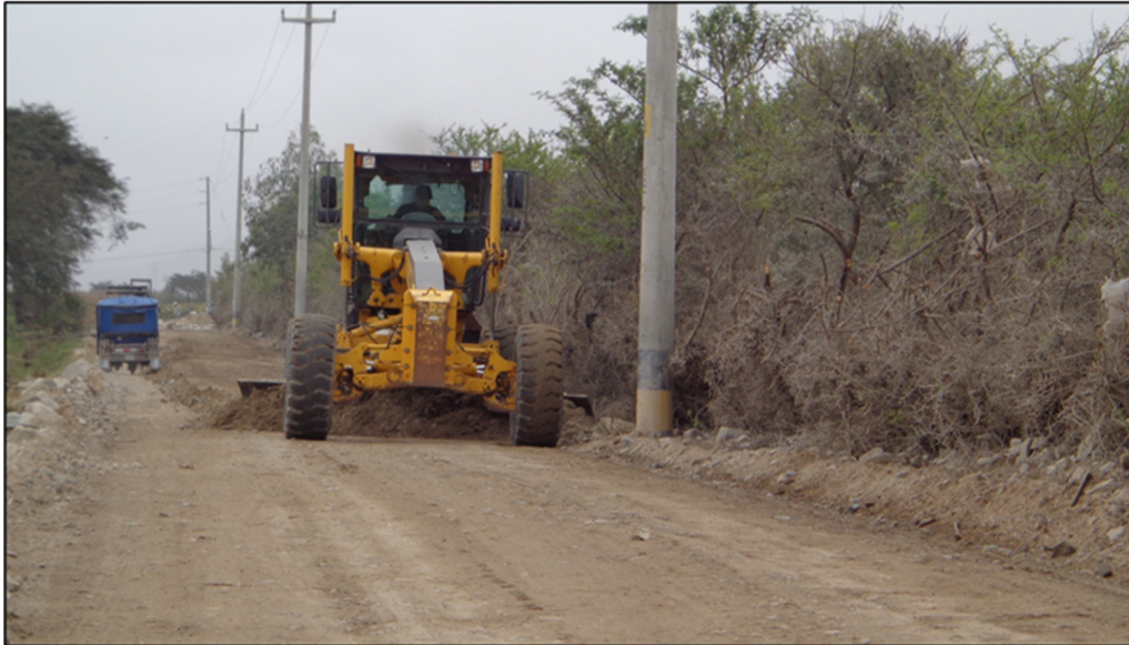
Compactación de base granular
