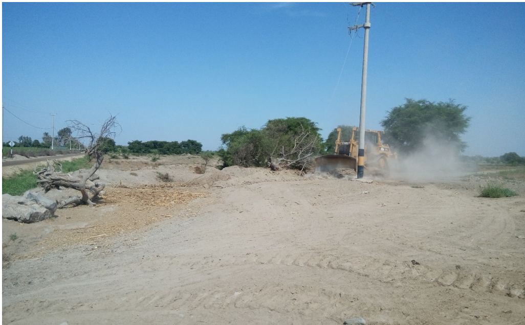
Inicio de trabajos de corte a nivel de sub rasante
