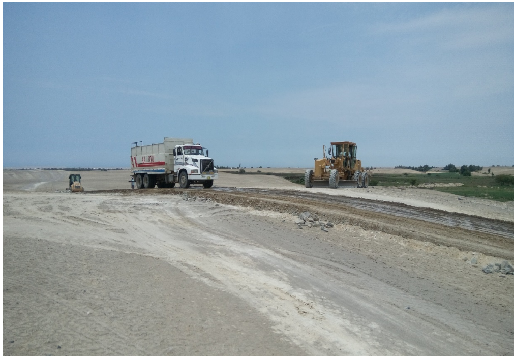
Riego y compactacion de Base granular
