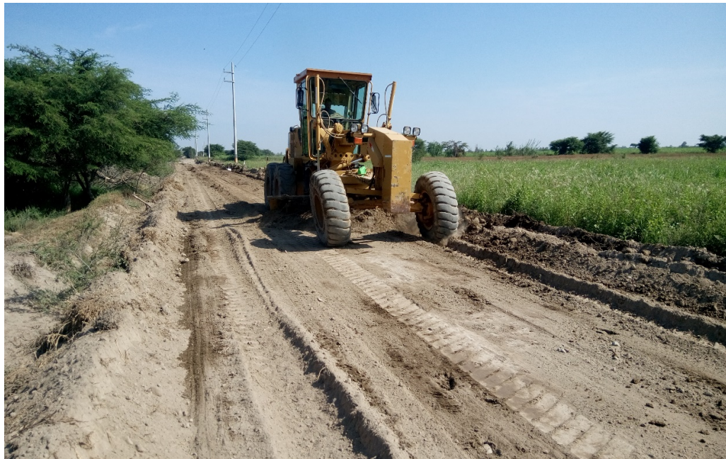
Conformación y ensanchamiento de Camino
