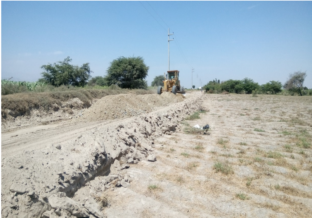
Conformacion de Sub base granular
