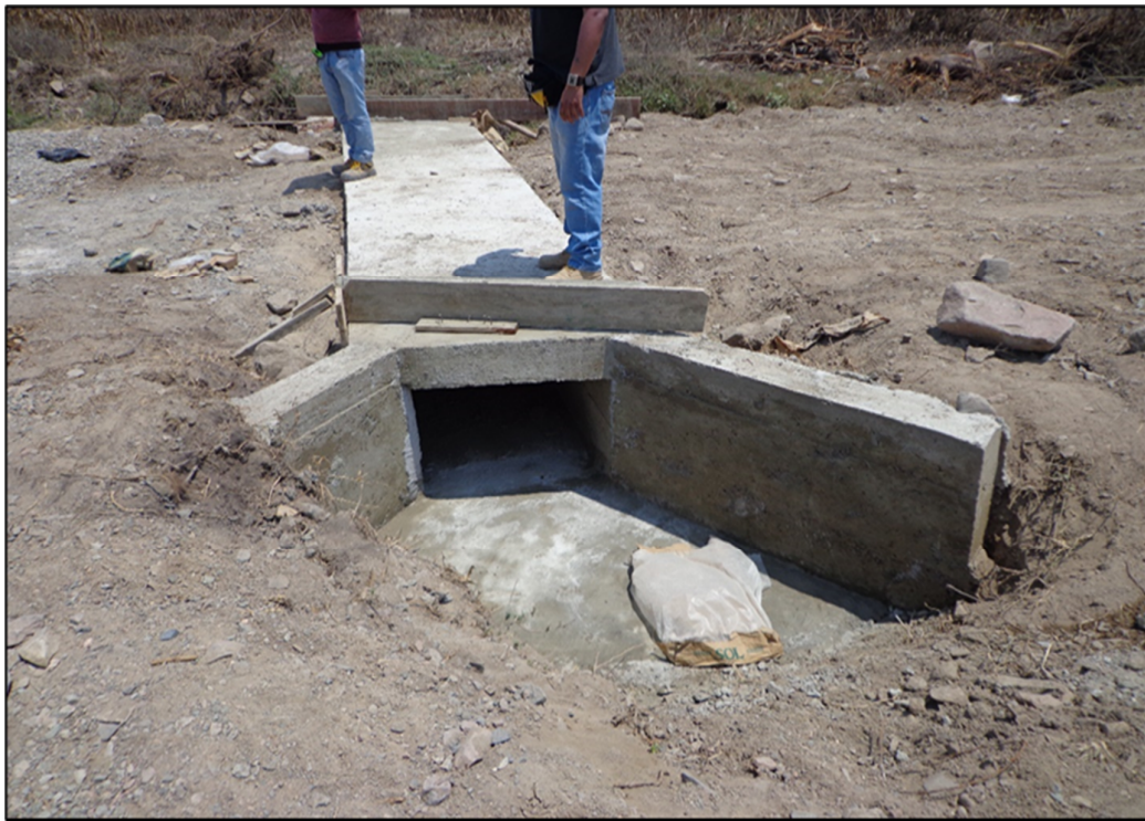
Finalizacion de la construccion de alcantarilla tipo 1
