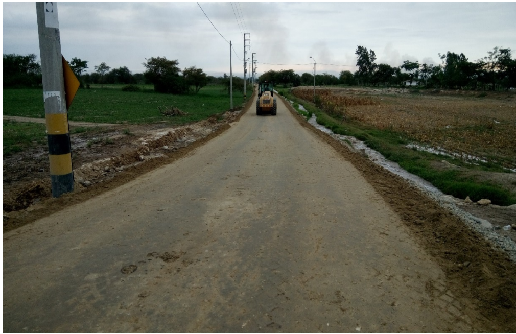
Refinado de compactacion en Base granular
