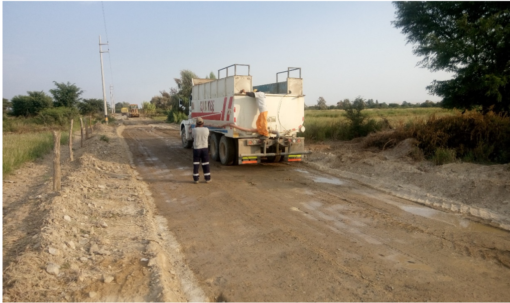
Compactacion de sub base granular
