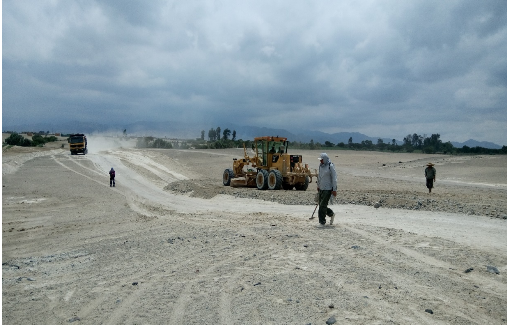
Riego y compactacion de Base granular
