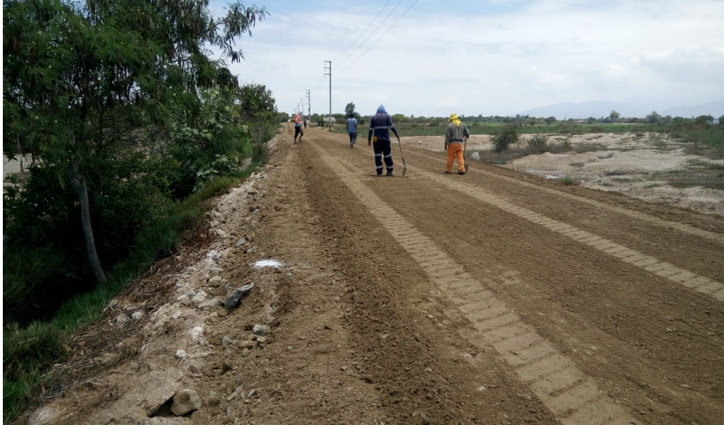
Proceso de conformacion de material granular
