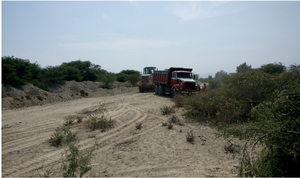
Acarreo de material para sub base
