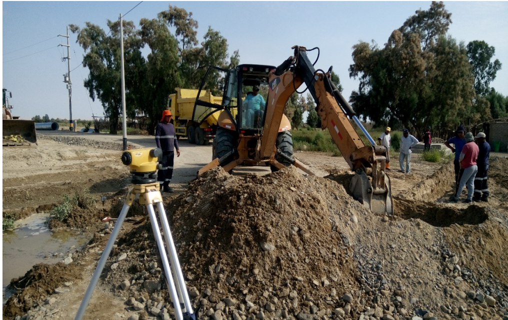
Traslado de Afirmado para Base Granular
