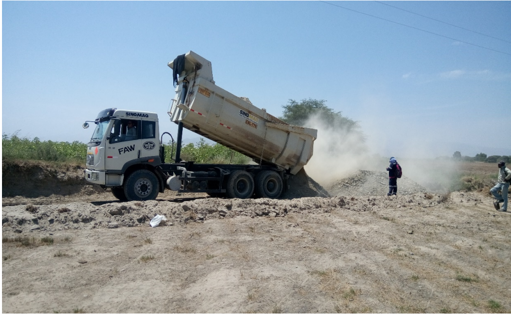
Conformacion de Sub base granular
