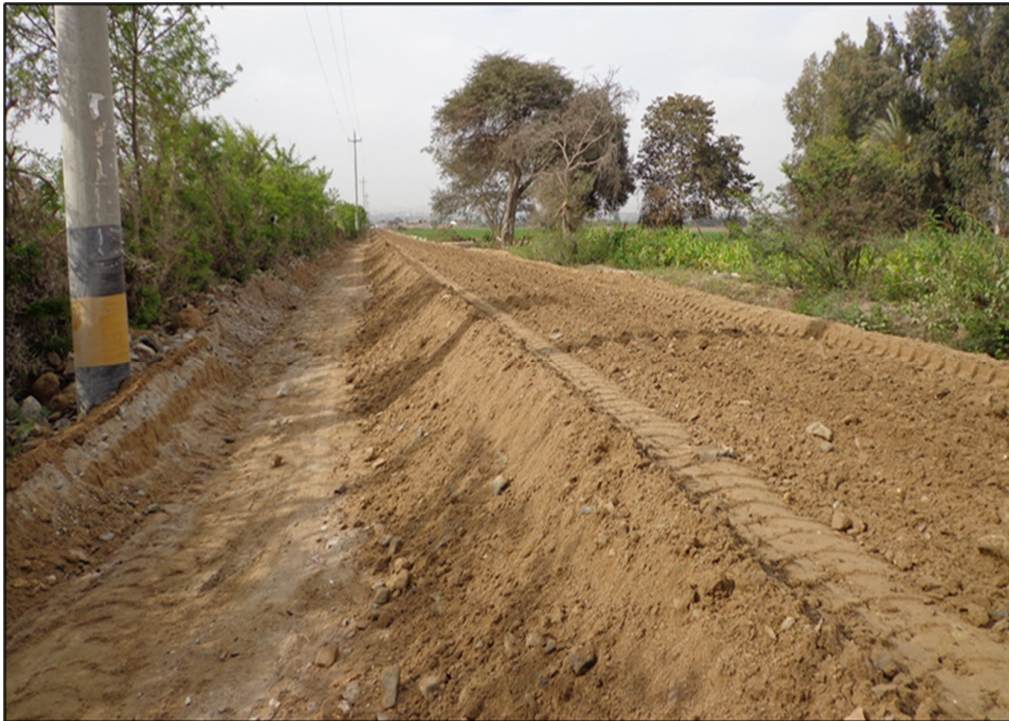
Proceso de conformacion de material granular
