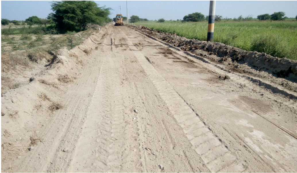
Conformación de Sub Rasante
