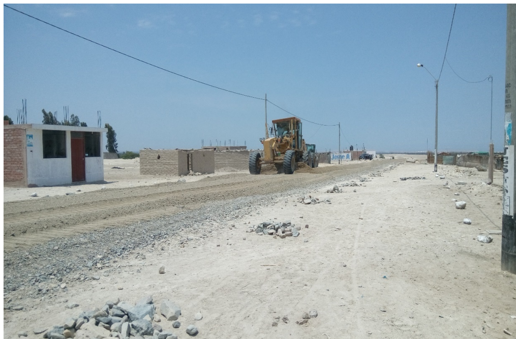
Conformacion de Base granular en Tramo final C.P. Nuevo Huanuco
