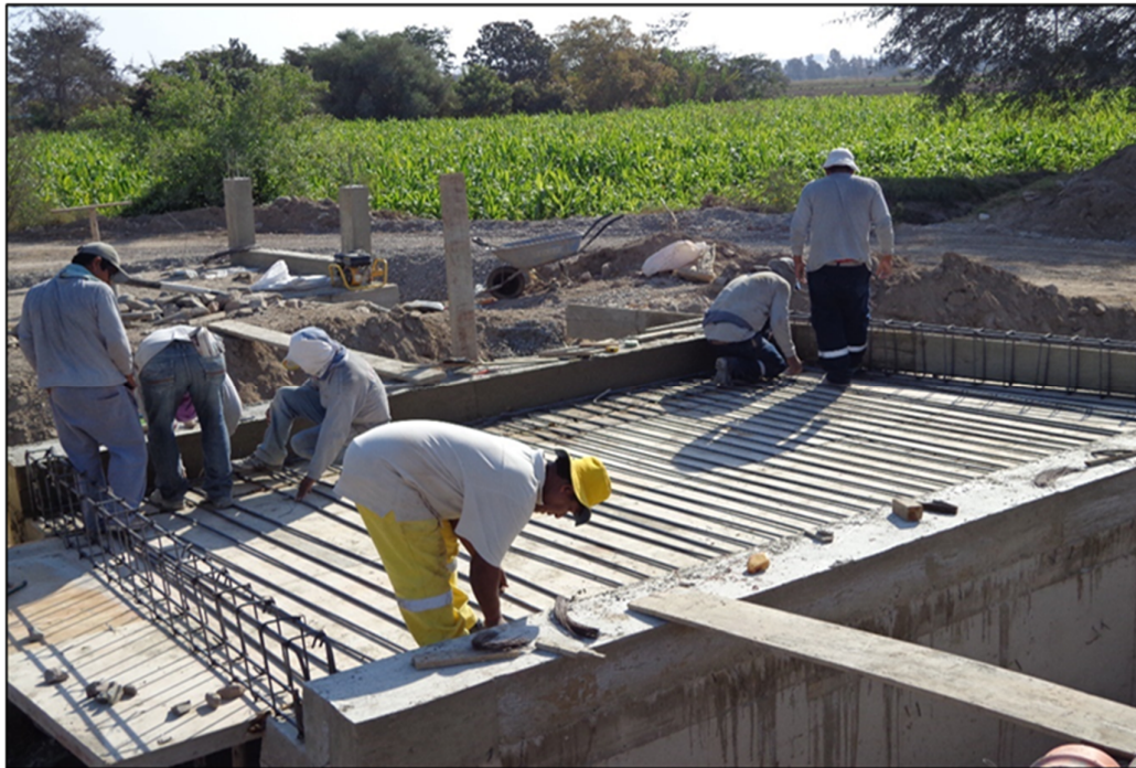
Construcción de losa en pontones
