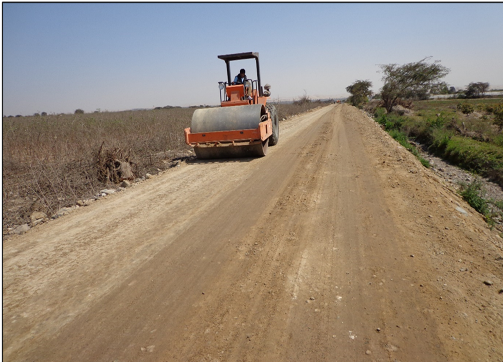
Compactación de base granular
