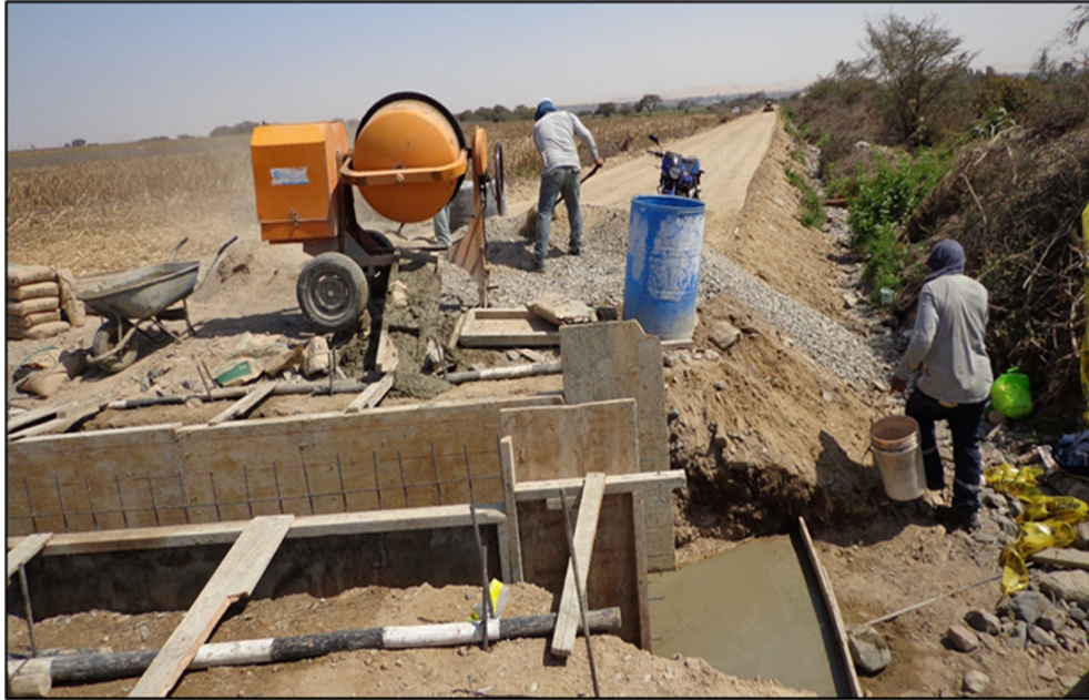
Construcción de alcantarillas tipo 1
