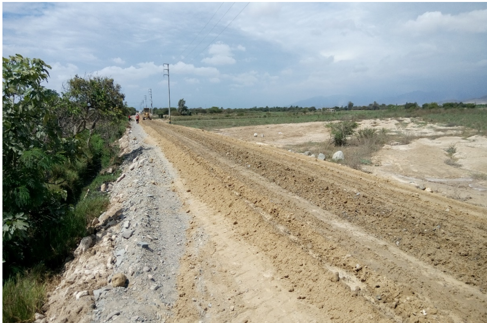
Conformacion de base Granular
