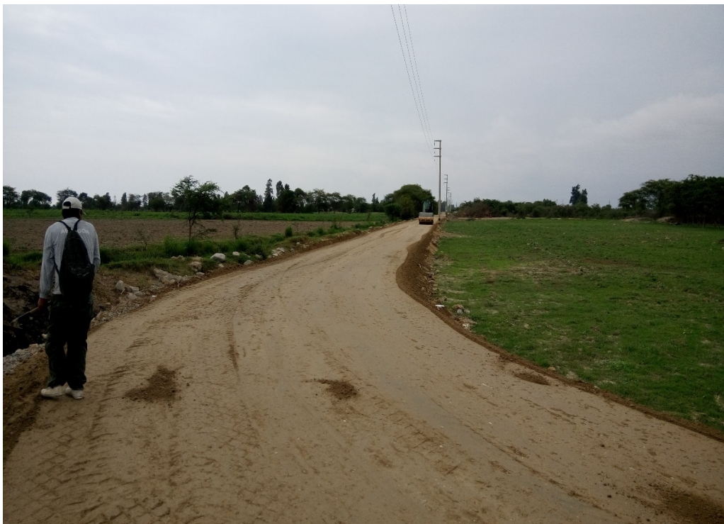
Refinado de compactacion en Base granular
