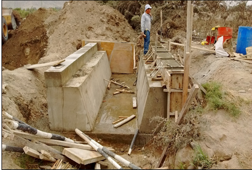
Construcción de estribos de pontones
