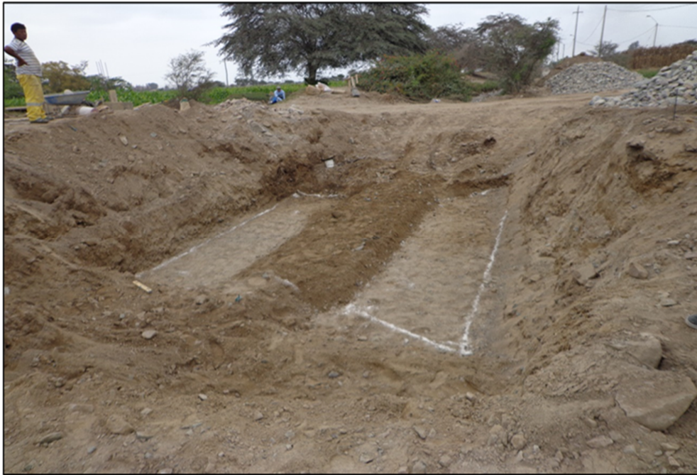
Trazo y replanteo en pontones
