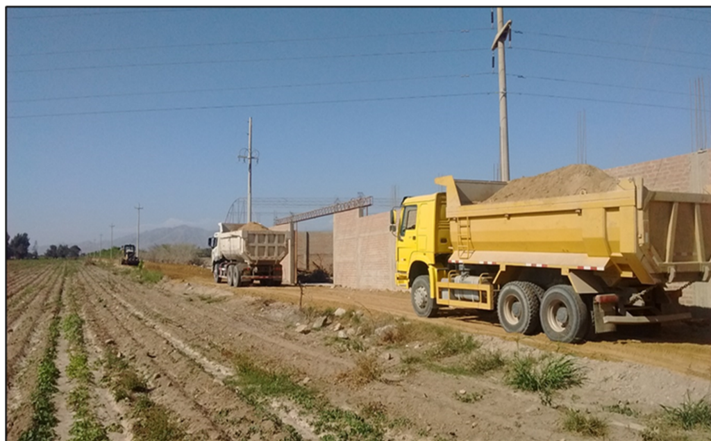
Tendido de material granular
