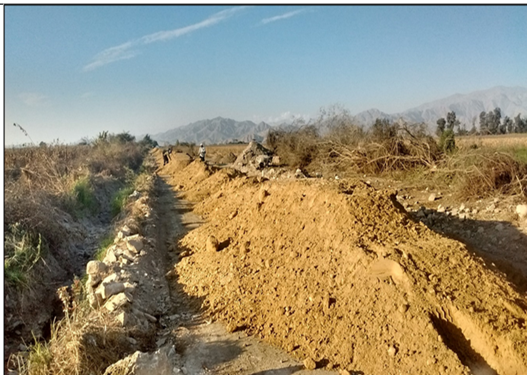
Tendido de material granular
