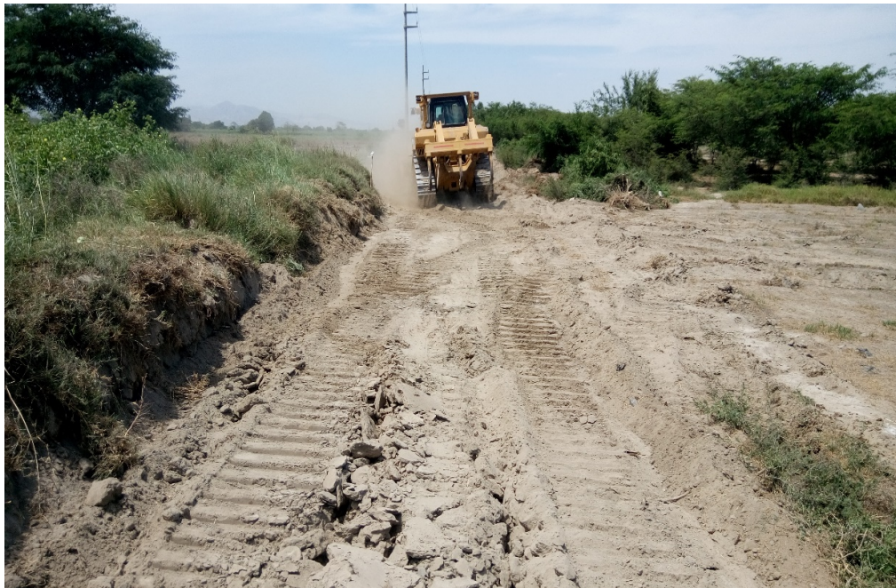
Movimiento de tierras masivo (corte a nivel sub rasante)
