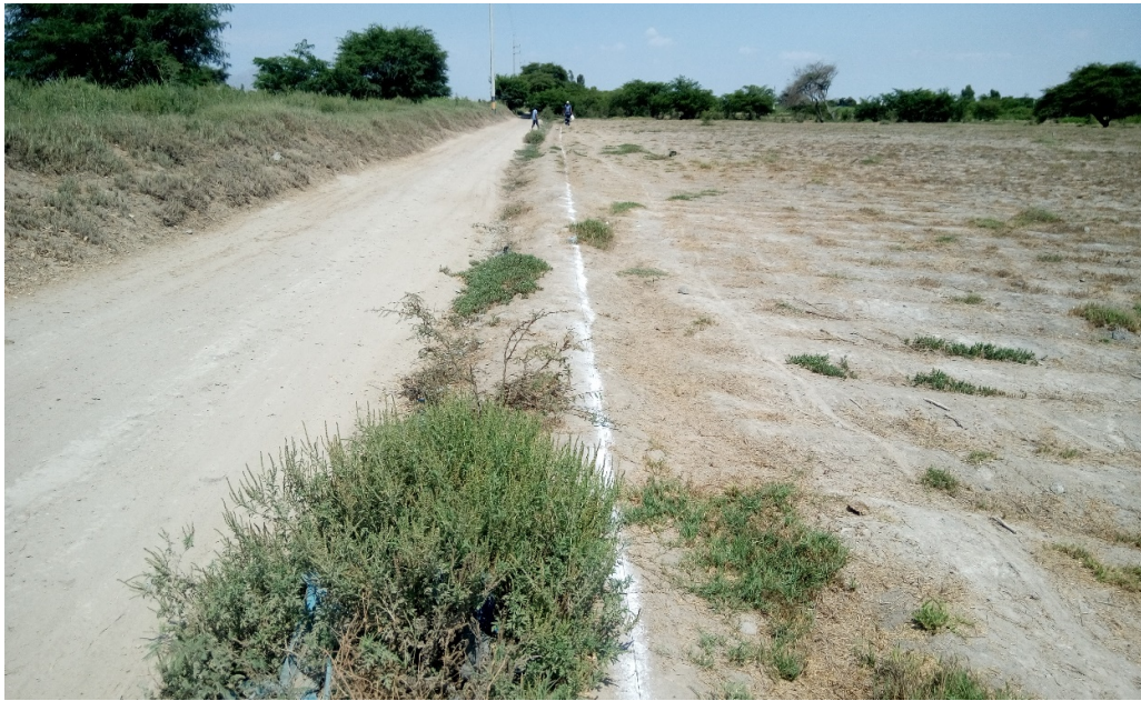
Trazo de ancho de vía en otra progresiva
