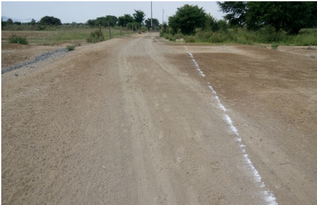
Trazo de ancho de vía en otra progresiva
