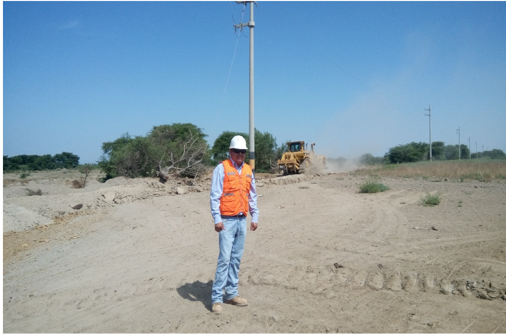
Movimiento de tierras masivo (corte a nivel sub rasante)
