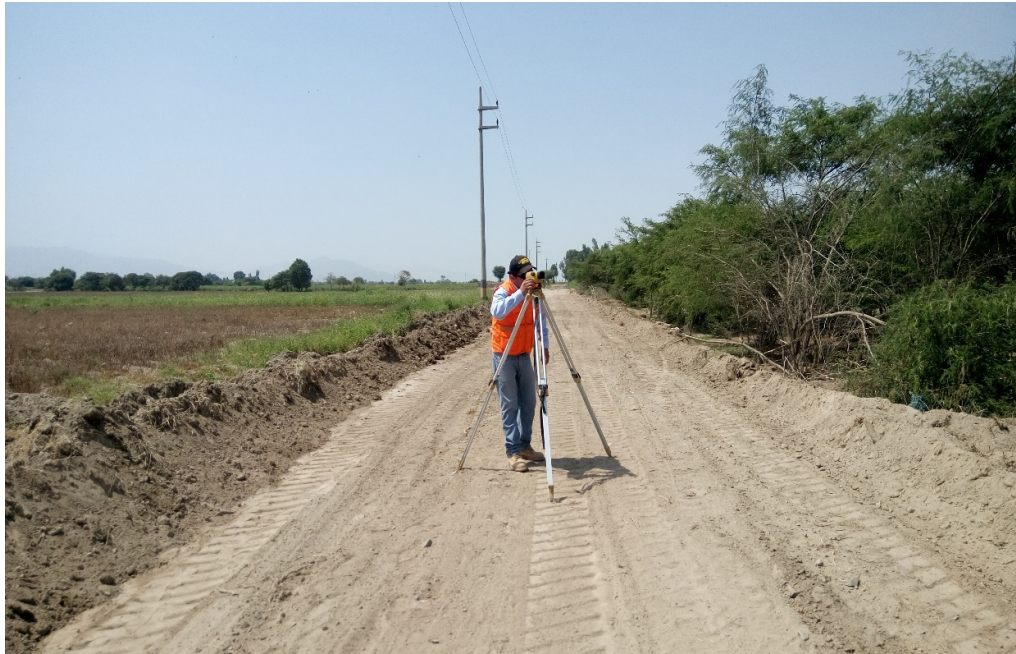
Colocacion de plantillas para control de niveles
