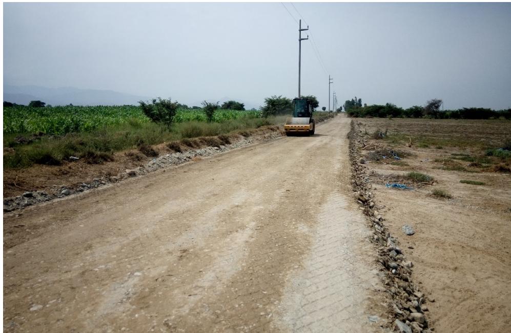
Compactacion de sub base granular
