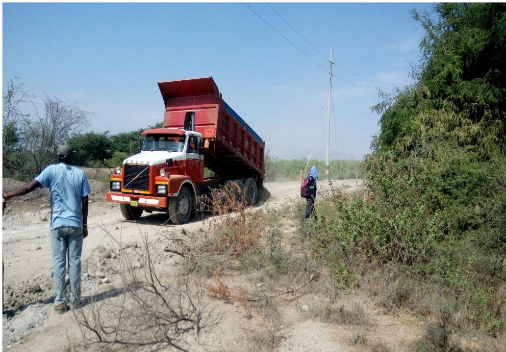
Acarreo de material para sub base
