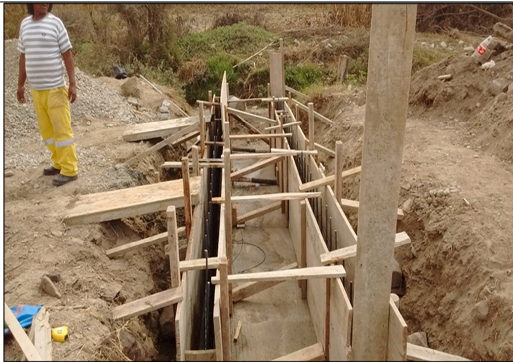
Construcción de alcantarillas tipo 1
