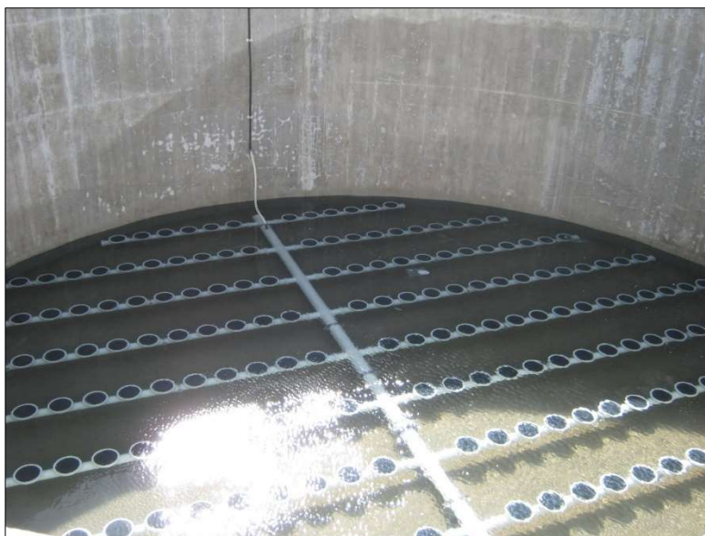
Digestor de Lodos
