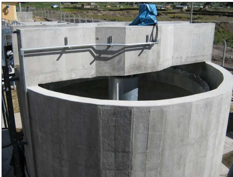
Espesador de Lodos
