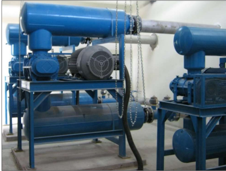
Sala de sopladores (Hacia reactor biológico) Tanque Icaas
