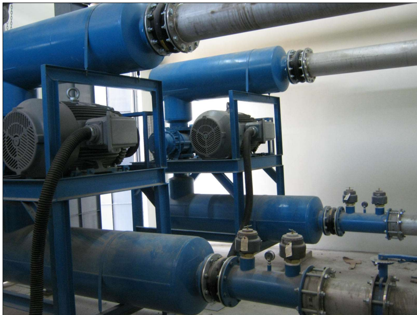
Sala de sopladores (Hacia reactor biológico) Tanque Icaas
