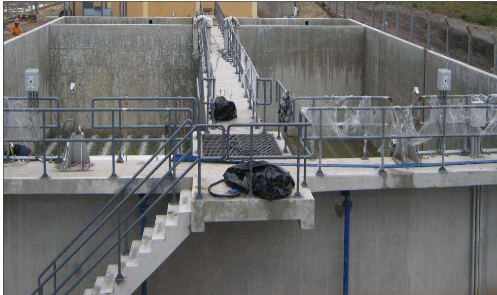
Sistema de Decantación (Tratamiento Secundario)
