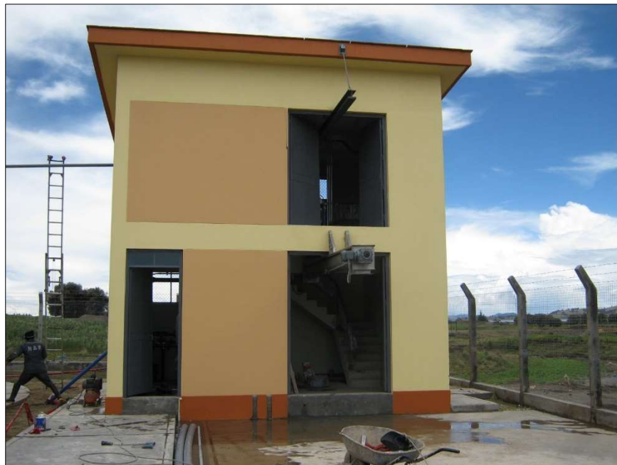
Tornillo de desplazamiento – Disposición final del Lodo
