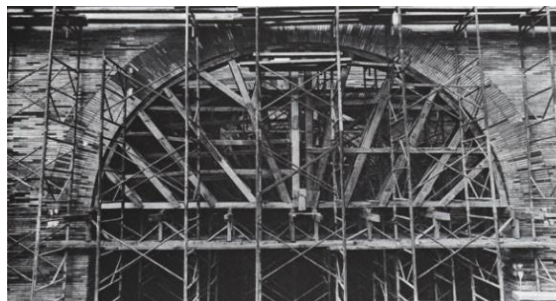
Ilustración 18: Construcción de los arcos del museo de Arte Romano
