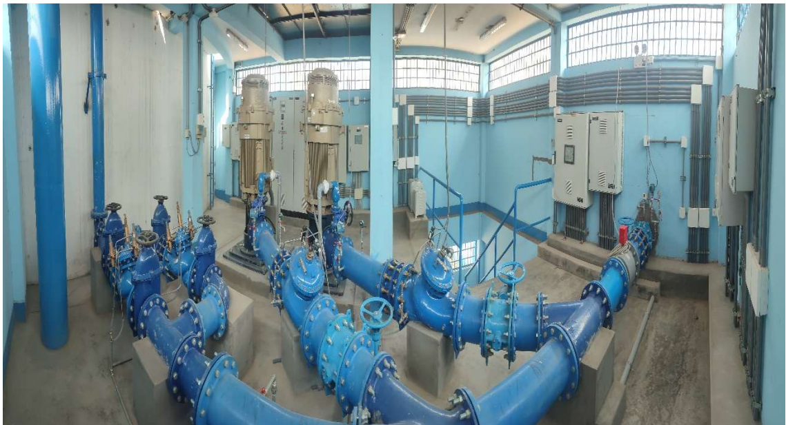
Árbol de Impulsión Reservoirio R-01 hacia Reservoirio RP-02 ejecutado
