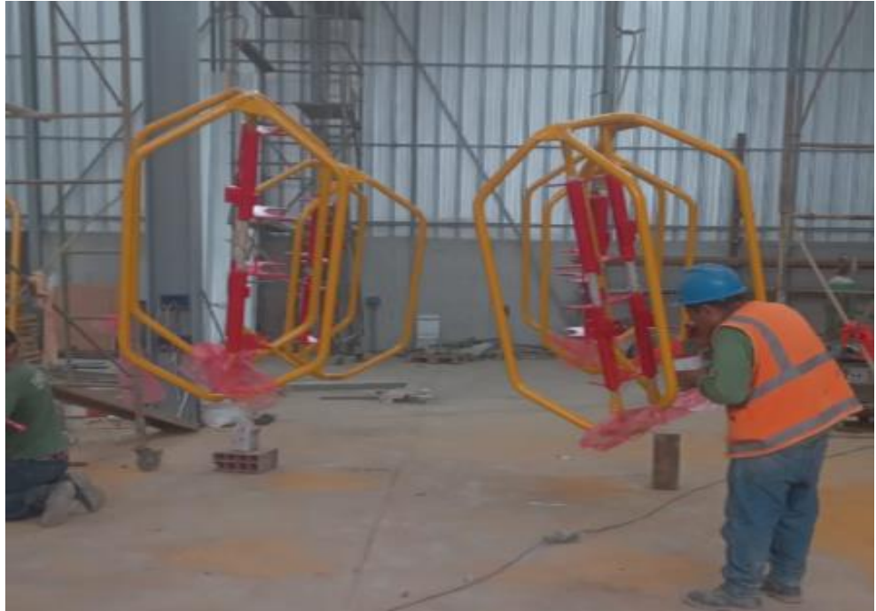
Fig. 34 Detalles finales de pintura en estructura de skit
