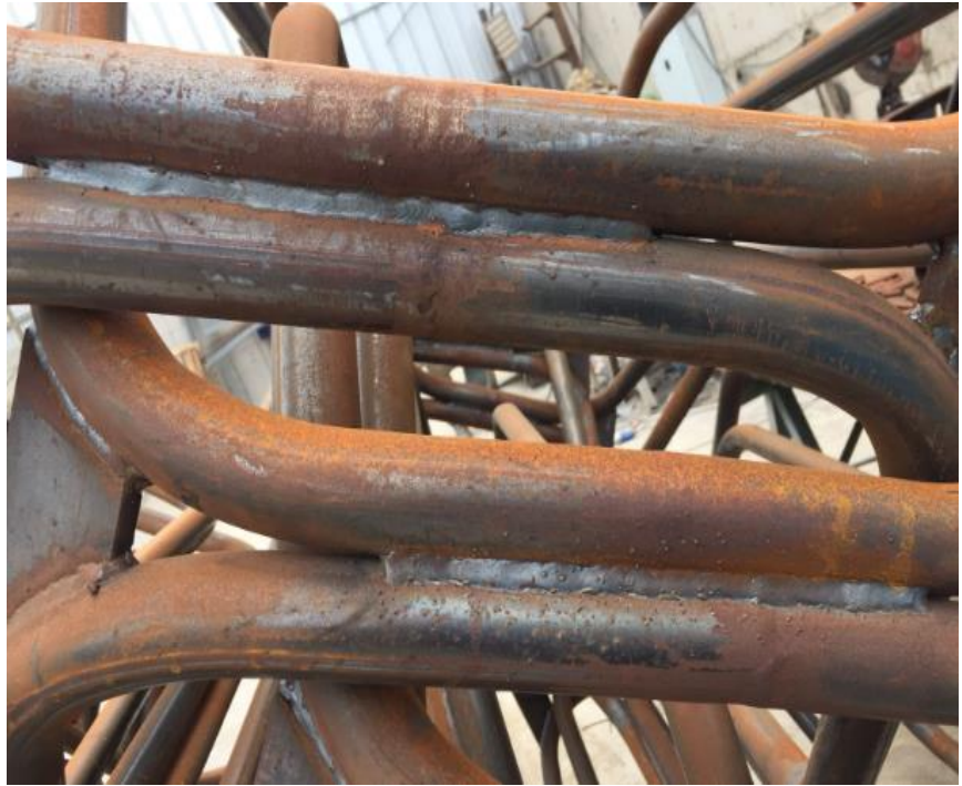
Fig. 18 Inspección de calidad en juntas soldadas de estructura de skit
