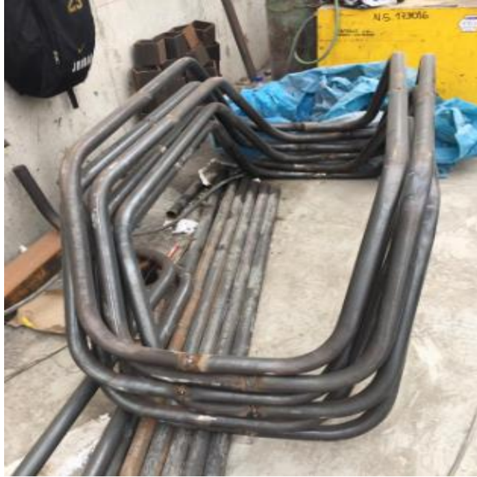
Fig. 16 Tubería base para estructura del skit
