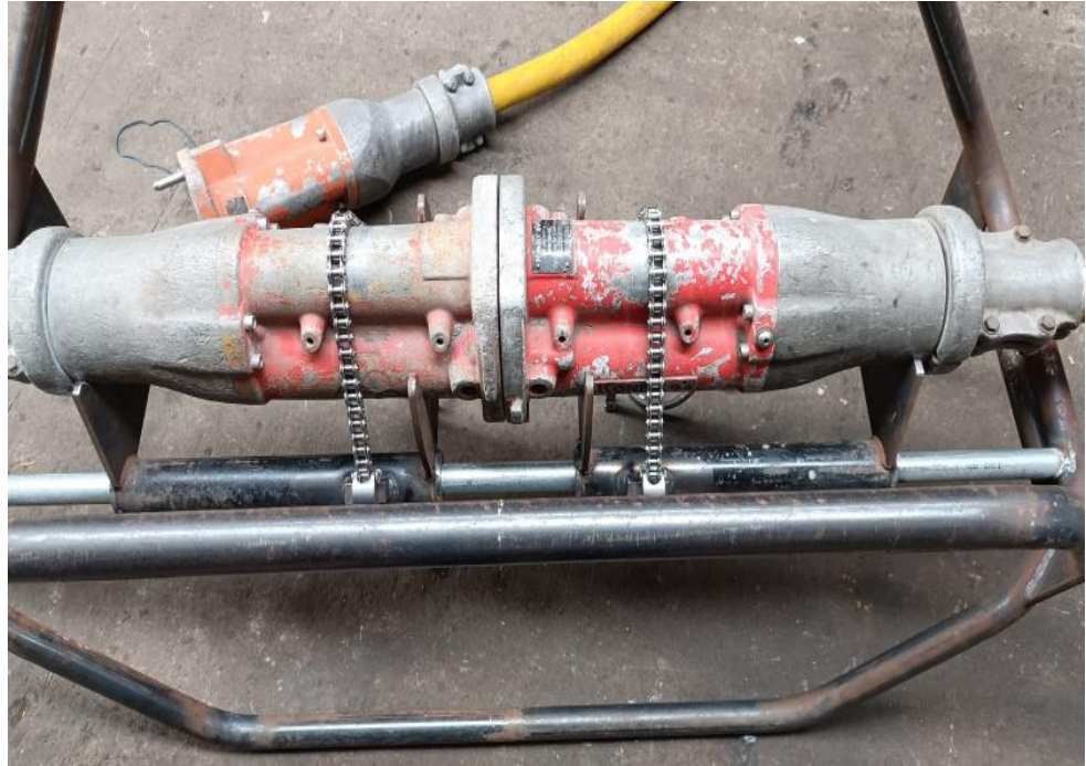
Fig. 30 Verificación de ajustes de conectores mediante cadenas de skit
