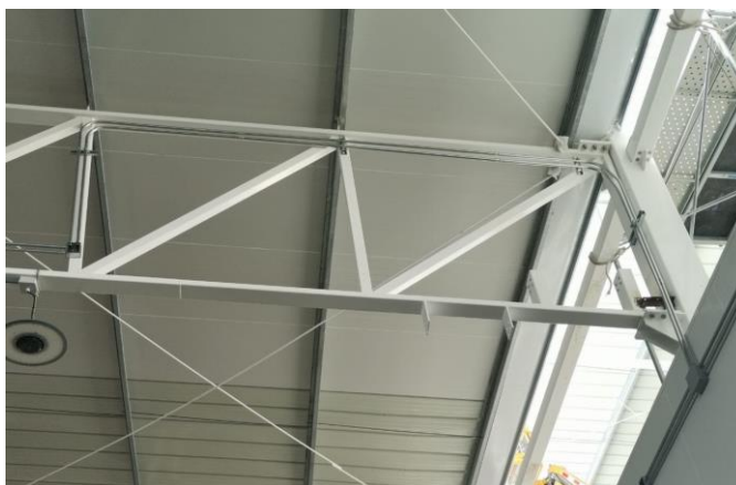
Fig. 464: Canalizaciones EMT del sistema de detección y alarmas
