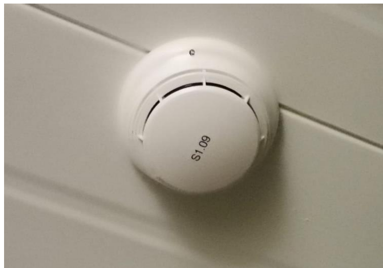
Fig. 574: Instalación de detectores de humo
