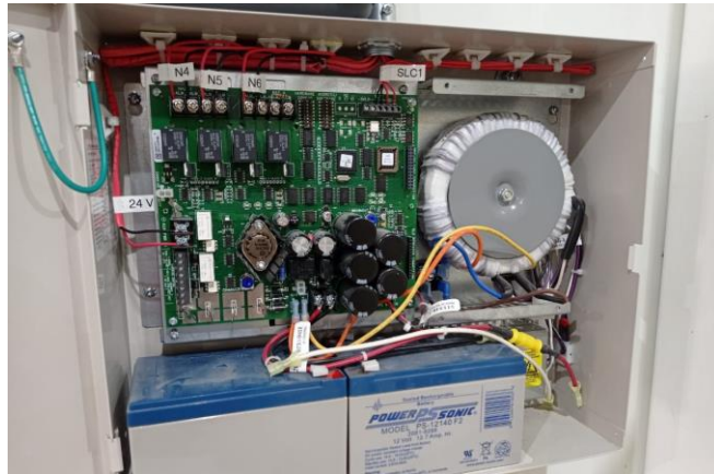
Fig. 859: Instalación de fuentes Nac extender
