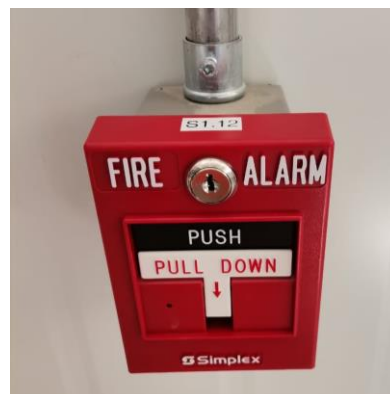
Fig. 705: Instalación de estación manual de alarma
