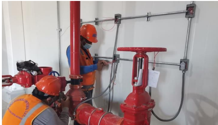
Fig. 760: Instalación de la caja y la base del módulo IAM
