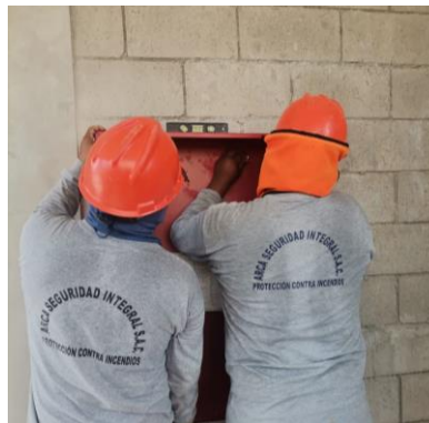
Fig. 914: Montaje del gabinete del panel de detección y alarmas
