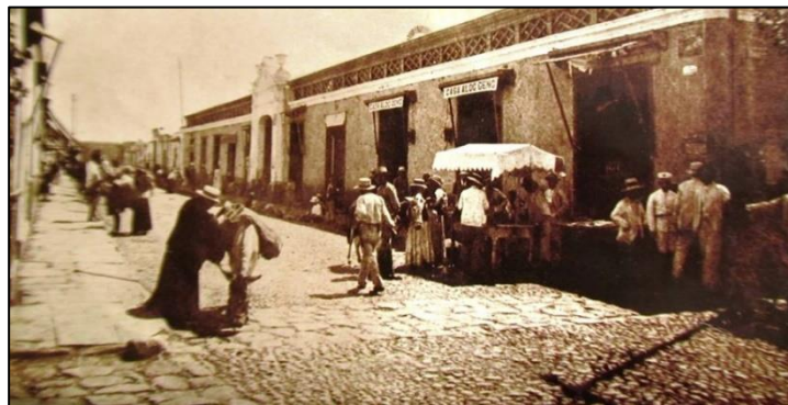
Figura 9: Estado del Mercado de Abastos de Ica 1899 antes de la intervención.
