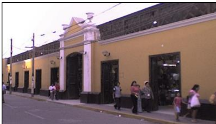
Figura 10: Estado del Mercado de Abastos de Ica después de la intervención.
