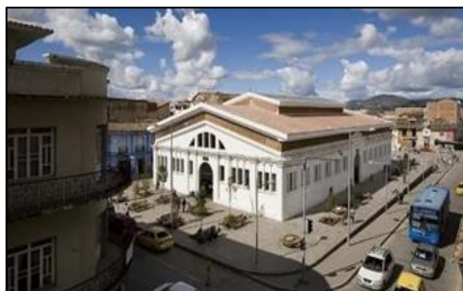
Figura 6: Proyecto de rehabilitación del Mercado 9 de octubre de Cuenca
