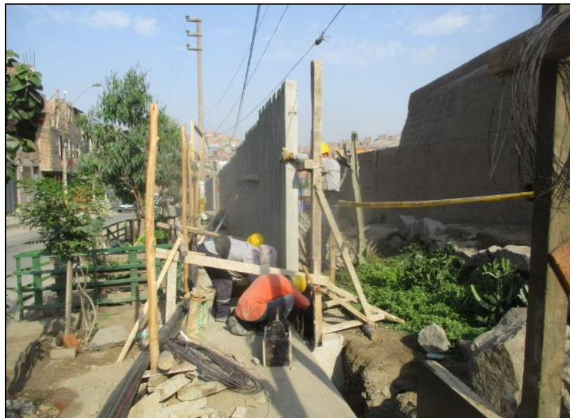
Figura 24. Vista de los trabajos de ingeniería ejecutados fuera de los límites optados por el arqueólogo (HN°5).
