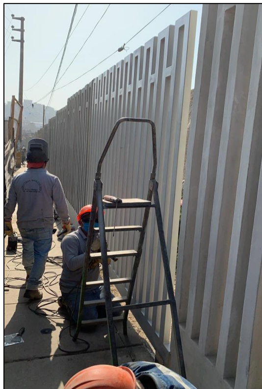
Figura 27. Proceso de instalación del cerco metálico colocado por encima de la vereda
