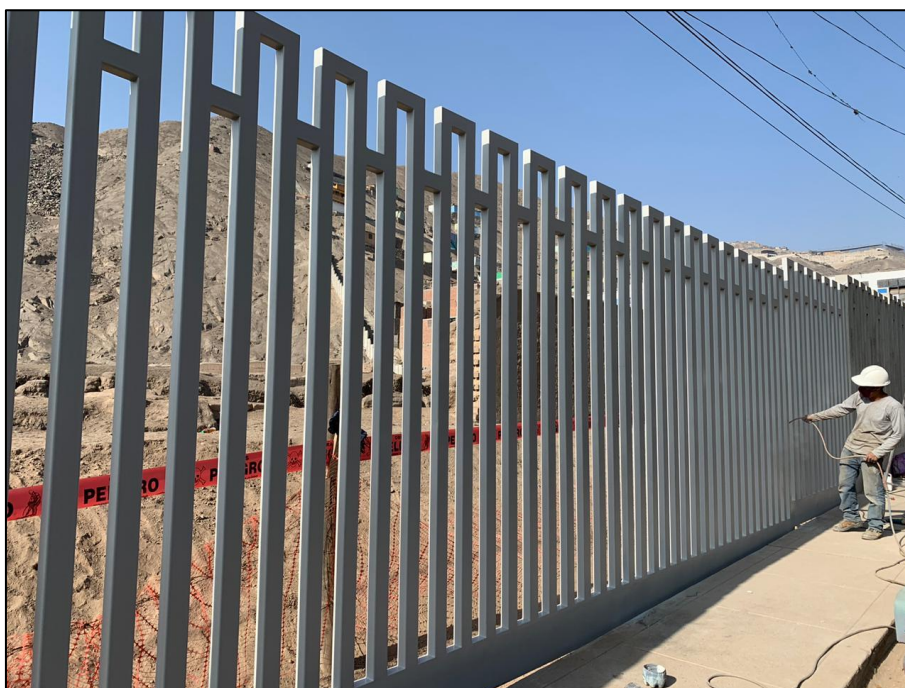
Figura 28. Vista del cerco metálico donde se puede apreciar su colocación a la altura y por encima de la vereda. Asimismo, se aprecia el contraste con el cerco perimétrico tipo Uni.
