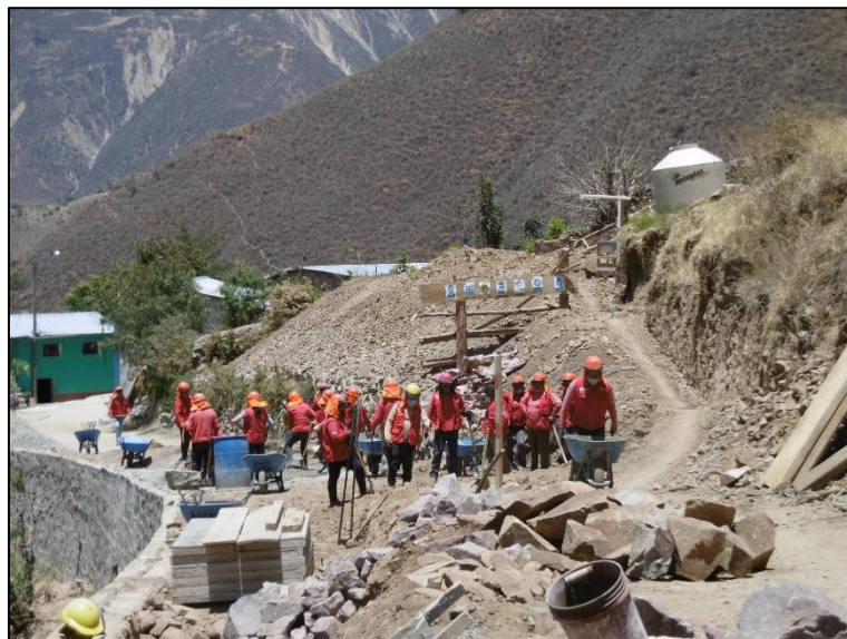
Figura 44. Ejecución de obra
