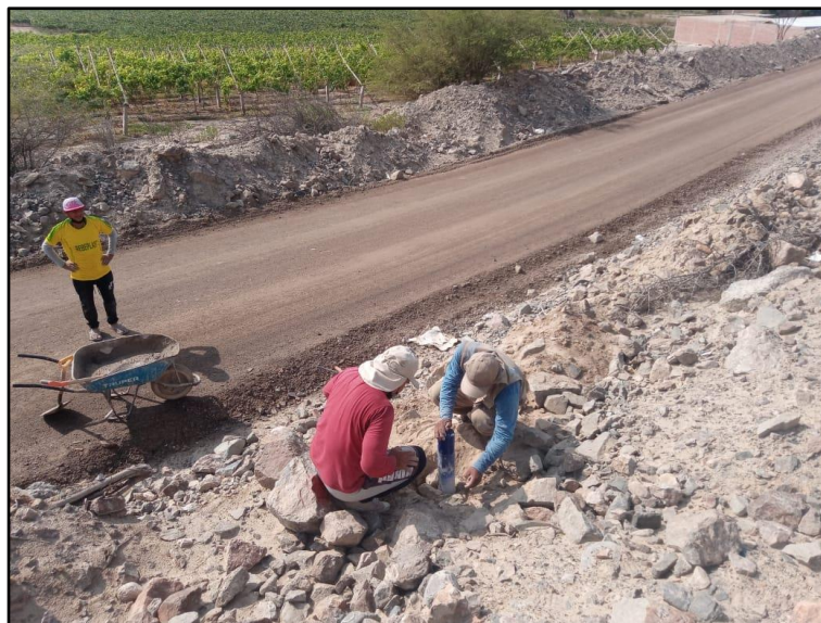
Figura 69. Proceso de instalación de Hitos
