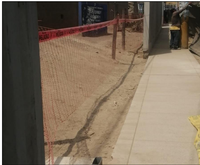
Figura 26. Vista del tapado de las zanjas
