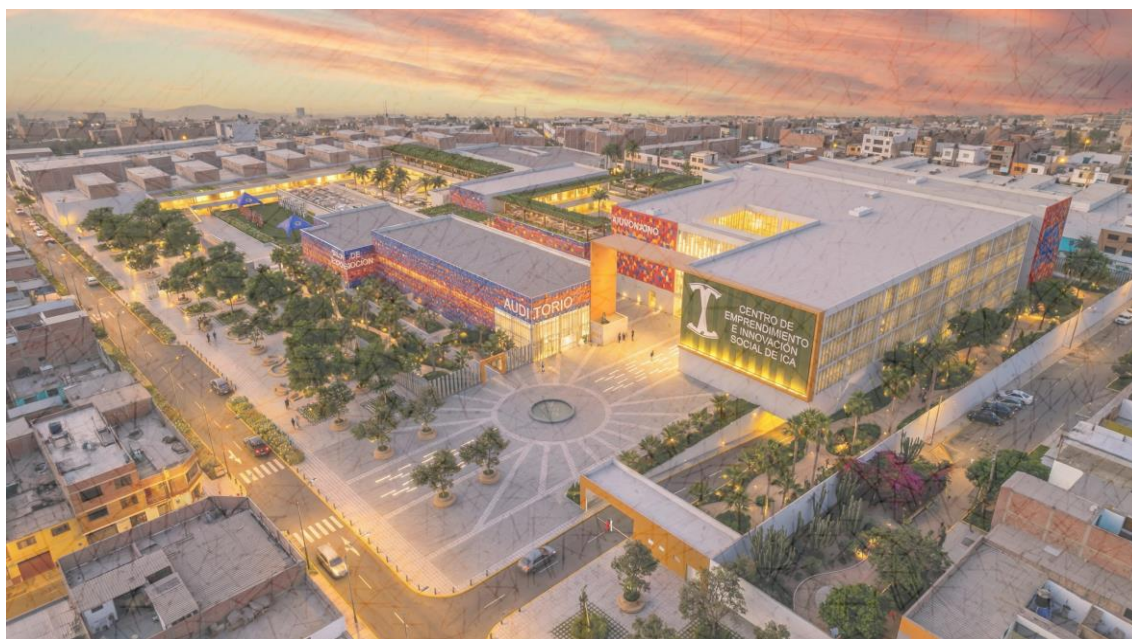
Figura 89. Vista de Explanada de Ingreso
