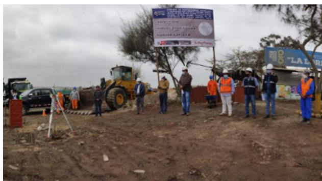
Figura 10: Trabajos de los trabajadores con sus implementos de seguridad.
