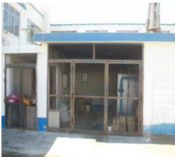
Figura 5. Vista frontal de la sala de incineración y disposición final de los residuos sólidos hospitalarios
