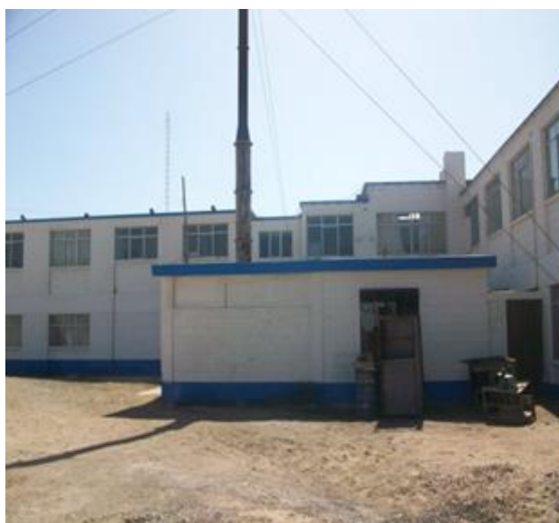
Figura 6. Vista lateral derecha sala de incineración y sala G.E. N°1
