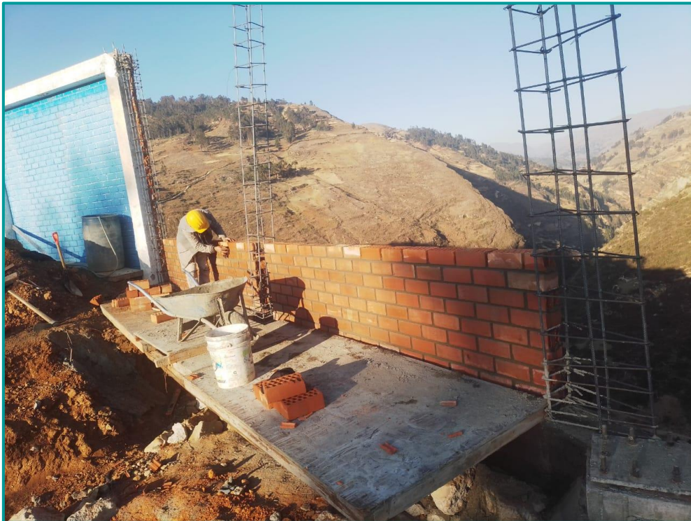
Reposición de muro de la estructura afectada (inicia en punto de culminación del muro)
