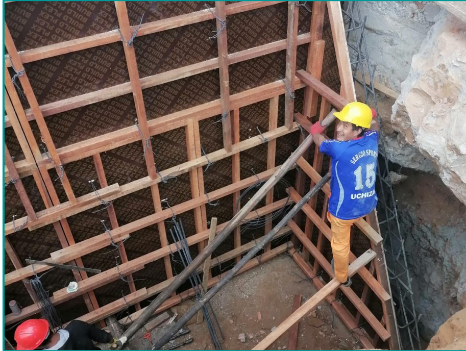
Fig. 12. Encofrado con panel fenólico
