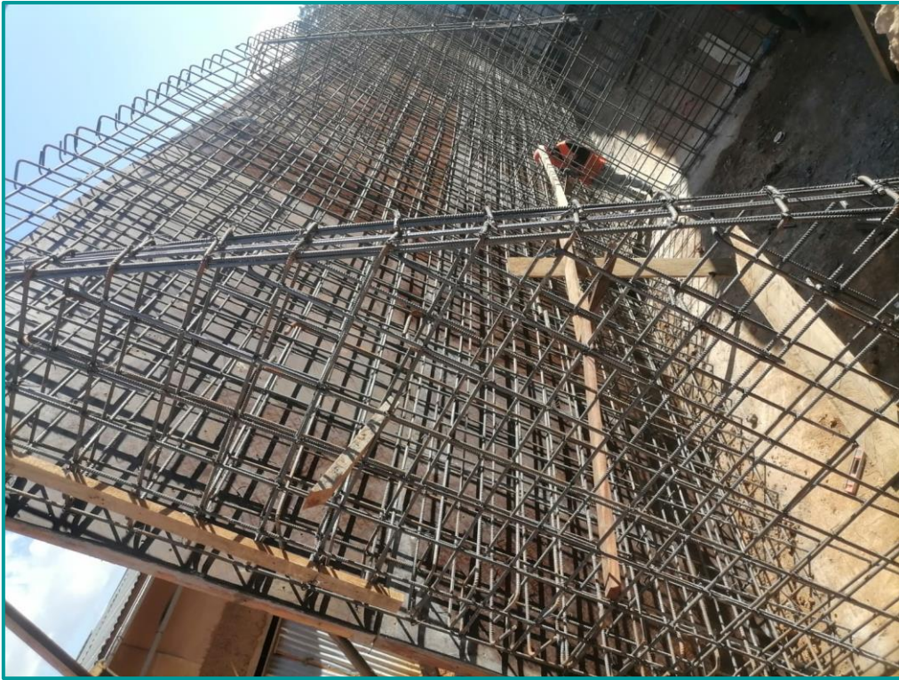
Colocación de tubería PVC 2" como lloronas
