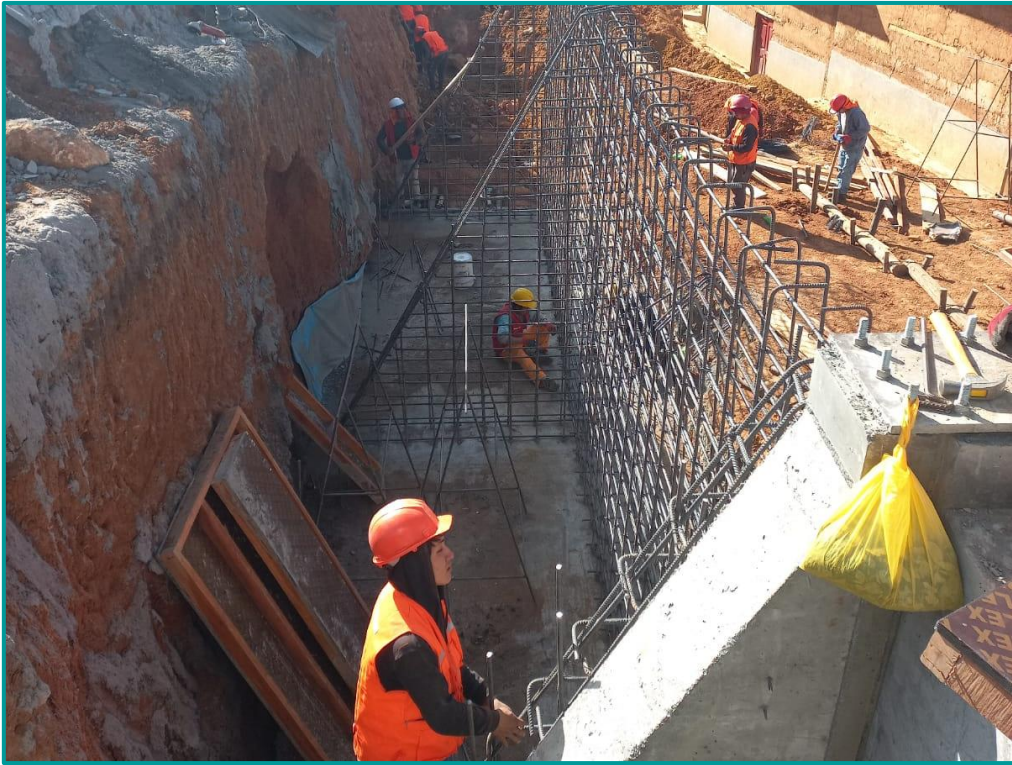
Armado de acero para pantalla y contrafuerte
