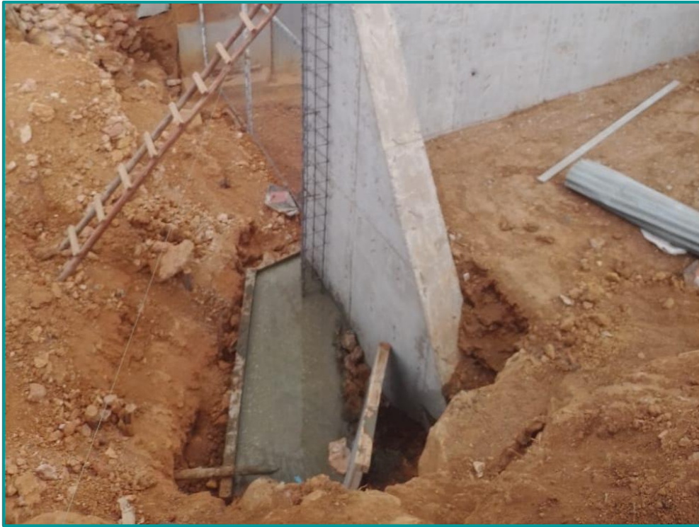
Reposición de la estructura afectada (punto de culminación del muro)
