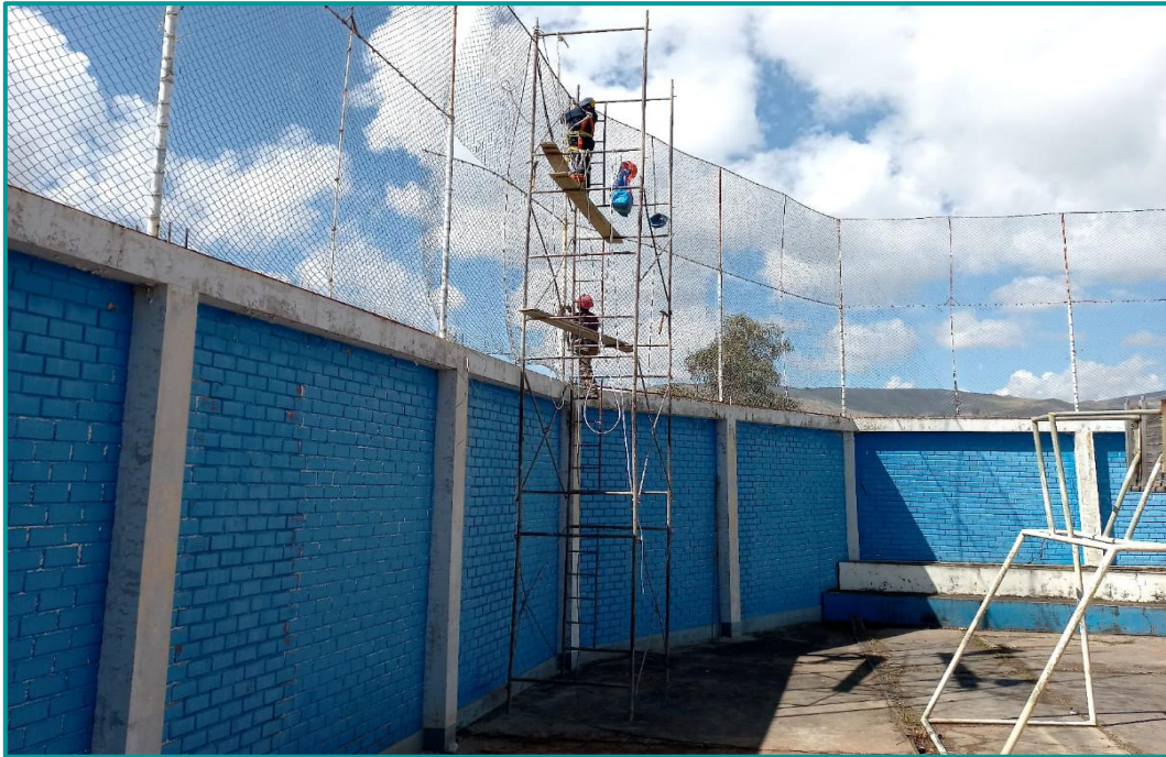
Desmontaje de malla metálica
