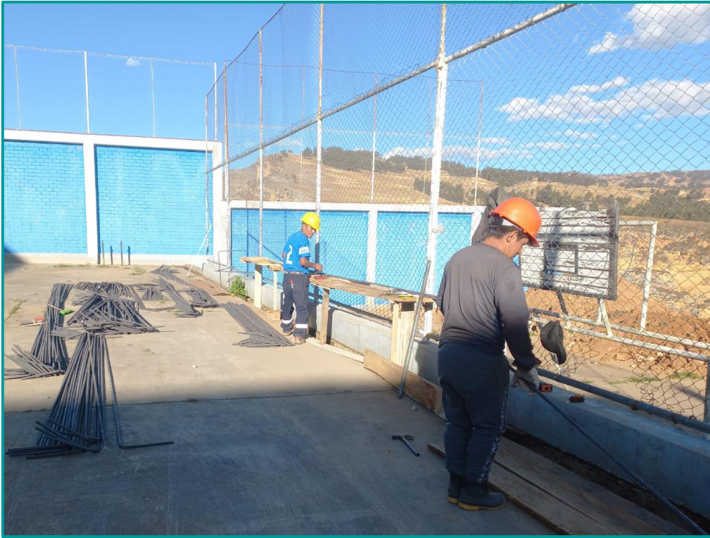
Medición, doblado y corte de acero
