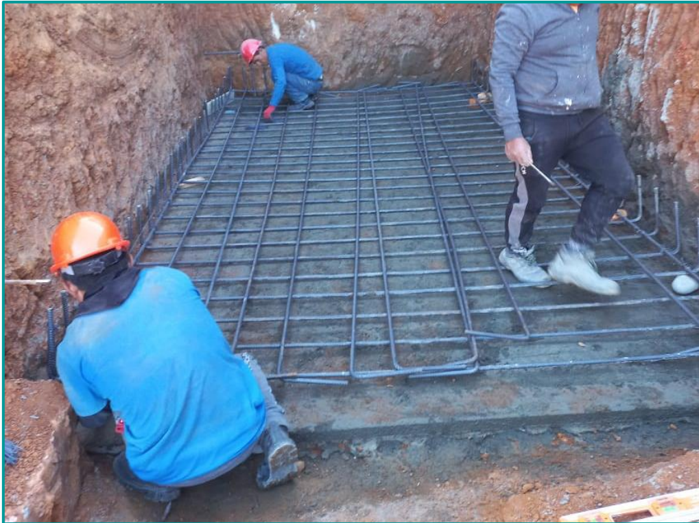
Vaciado de solado y armado de acero para zapatas
