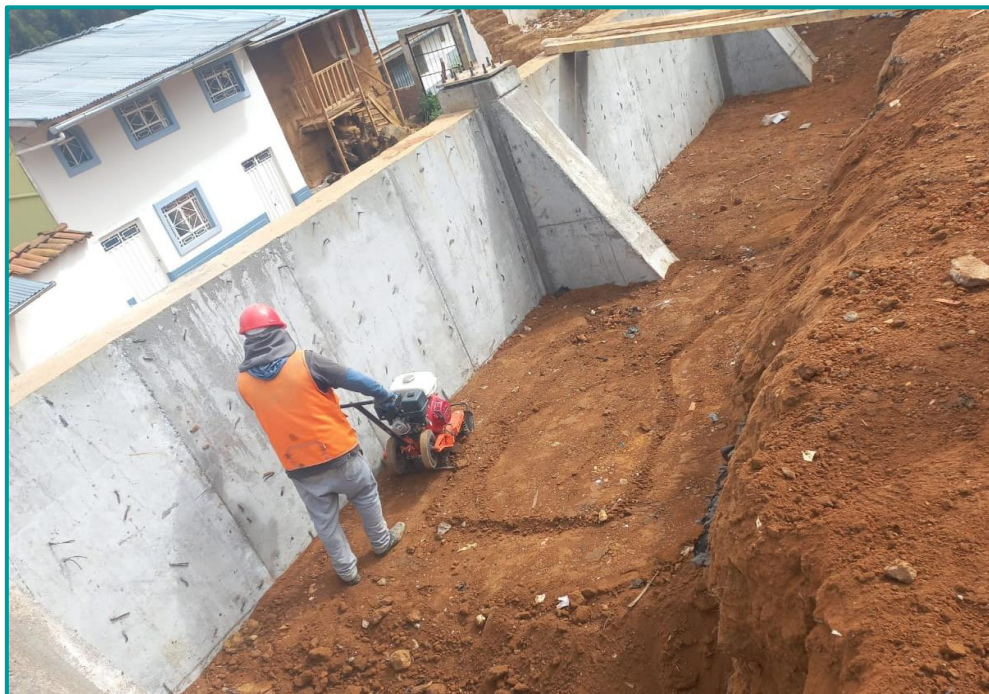
Compactación con material propio seleccionado con plancha compactadora
