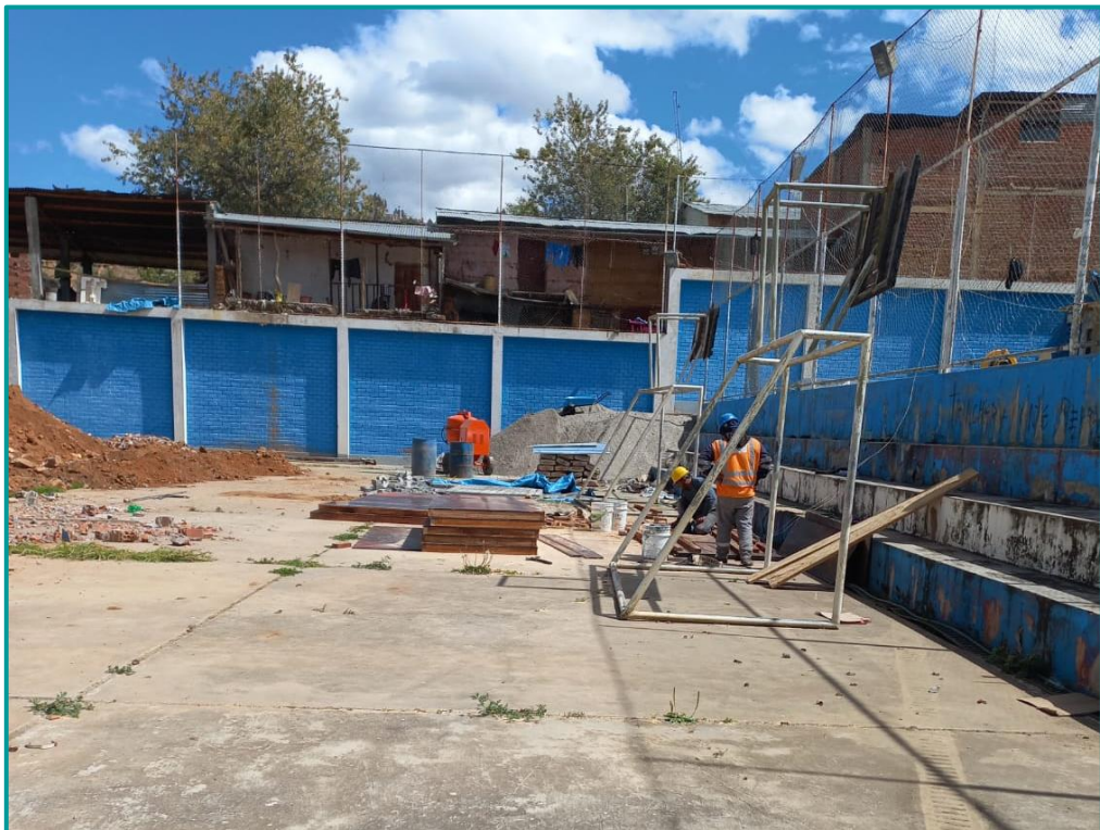
Armado de paneles para encofrado
