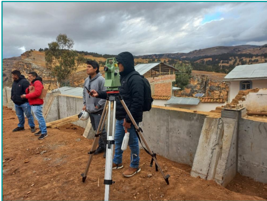
Fig. 18. Replanteo por parte del área de proyectos
