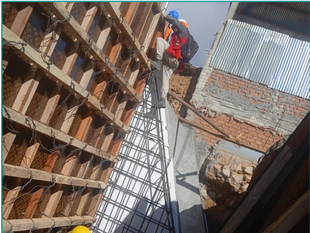
Colocación de junta con espuma sintética de poliuretano
