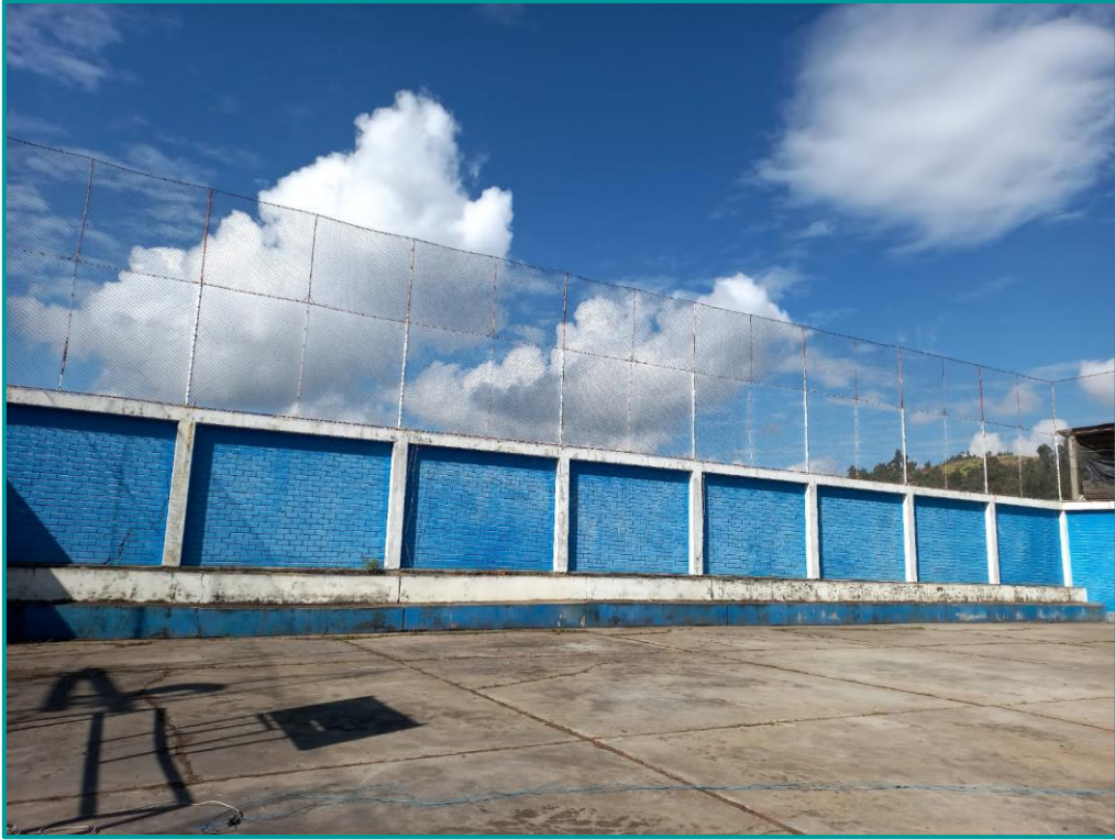
Muro de contención a demoler
