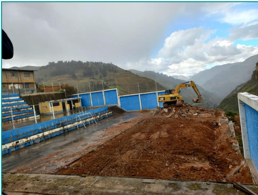
Demolición de la infraestructura existente con maquinaria
