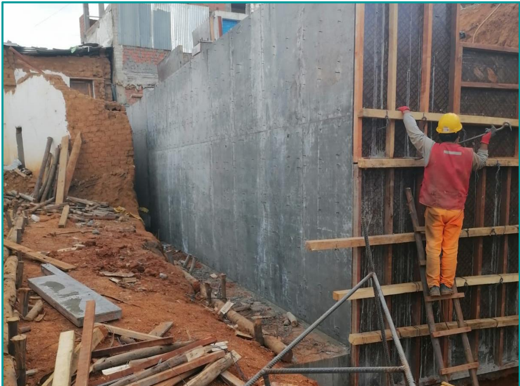
Desenformado de muro
