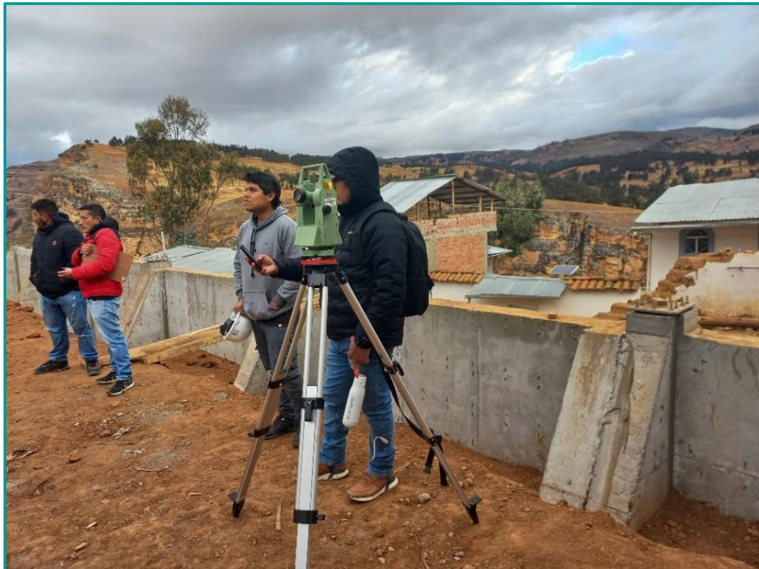
Fig. 4. Replanteo por parte del área de proyectos
