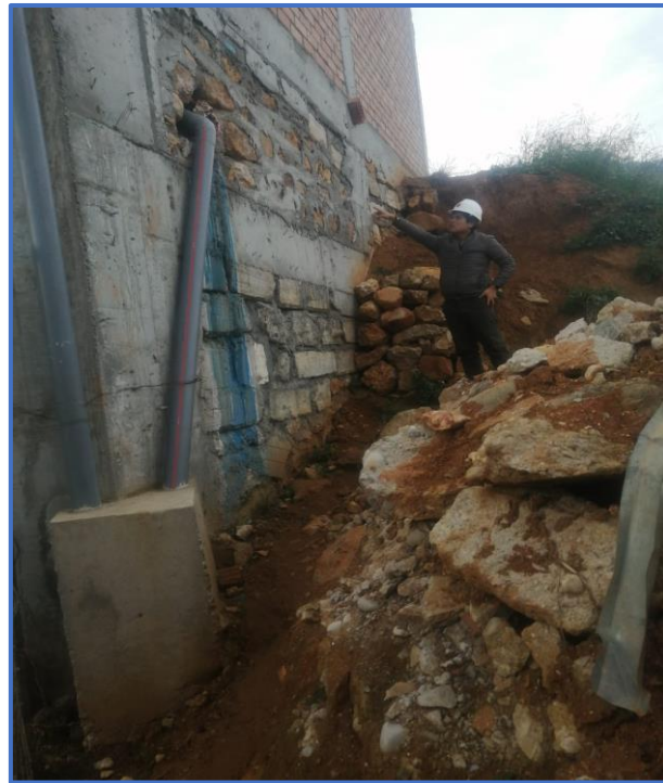
Se puede visualizar un muro de mampostería con una viga media y sobrecimiento para el muro de reposición de la estructura afectada
