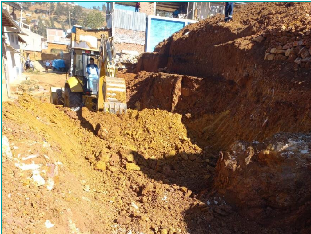
Excavación masiva para zapatas
