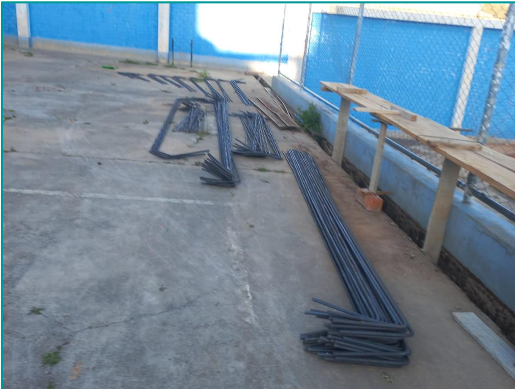
Acero doblado, listo para montaje
