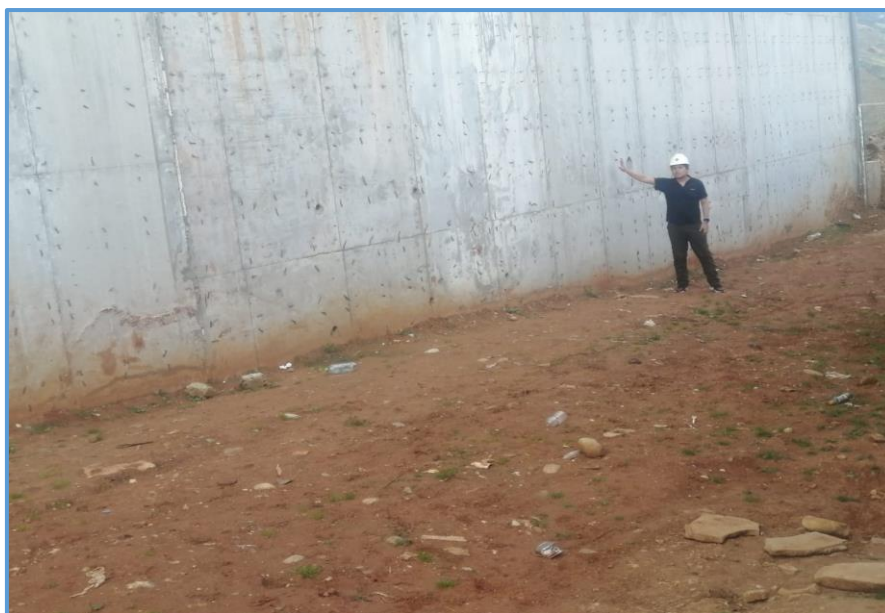
Fig. 52. Culminación de la obra
