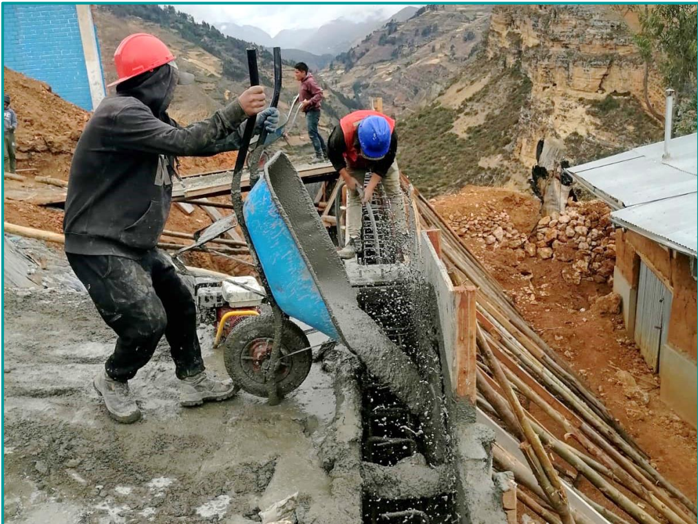
Vaciado de concreto en los muros tipo I, II y III
