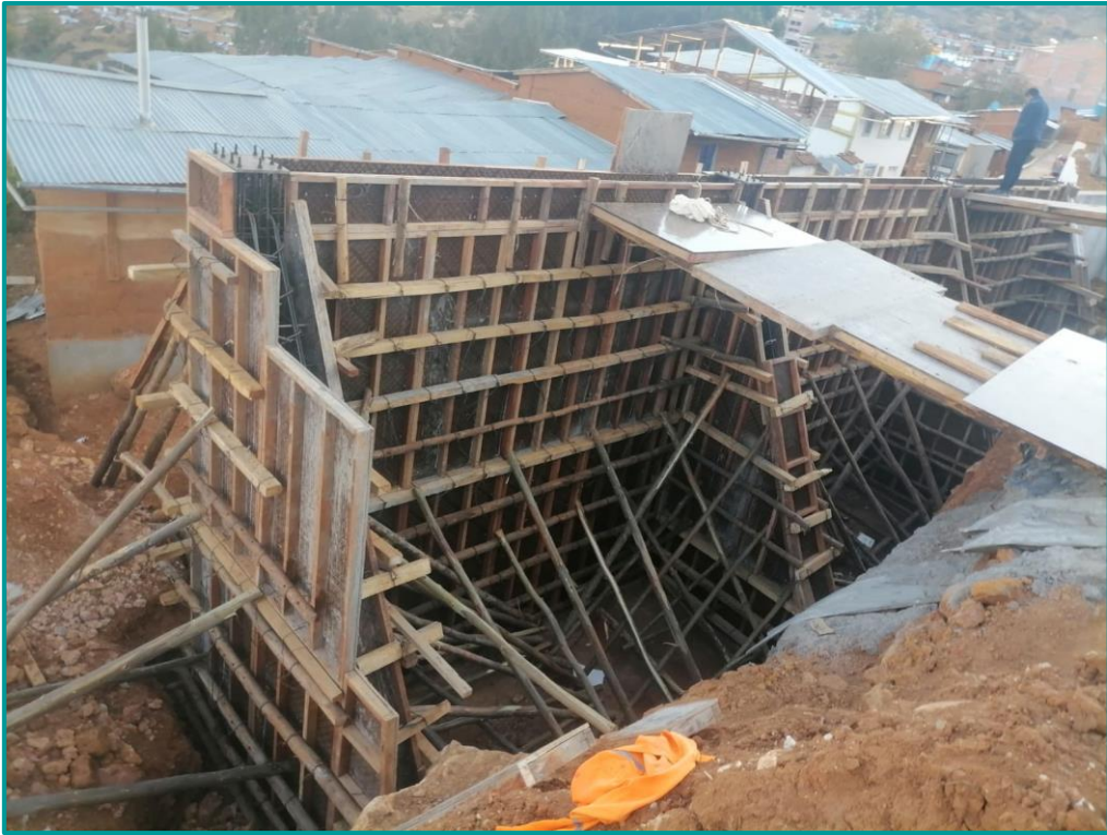
Finalización de los trabajos de encofrado en los 03 tipos de muros
