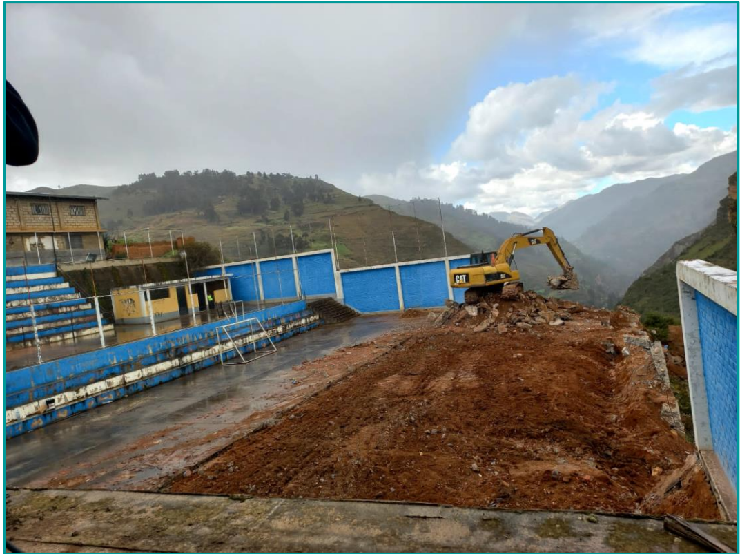
Fig. 5. Excavación masiva y conformación de talud
