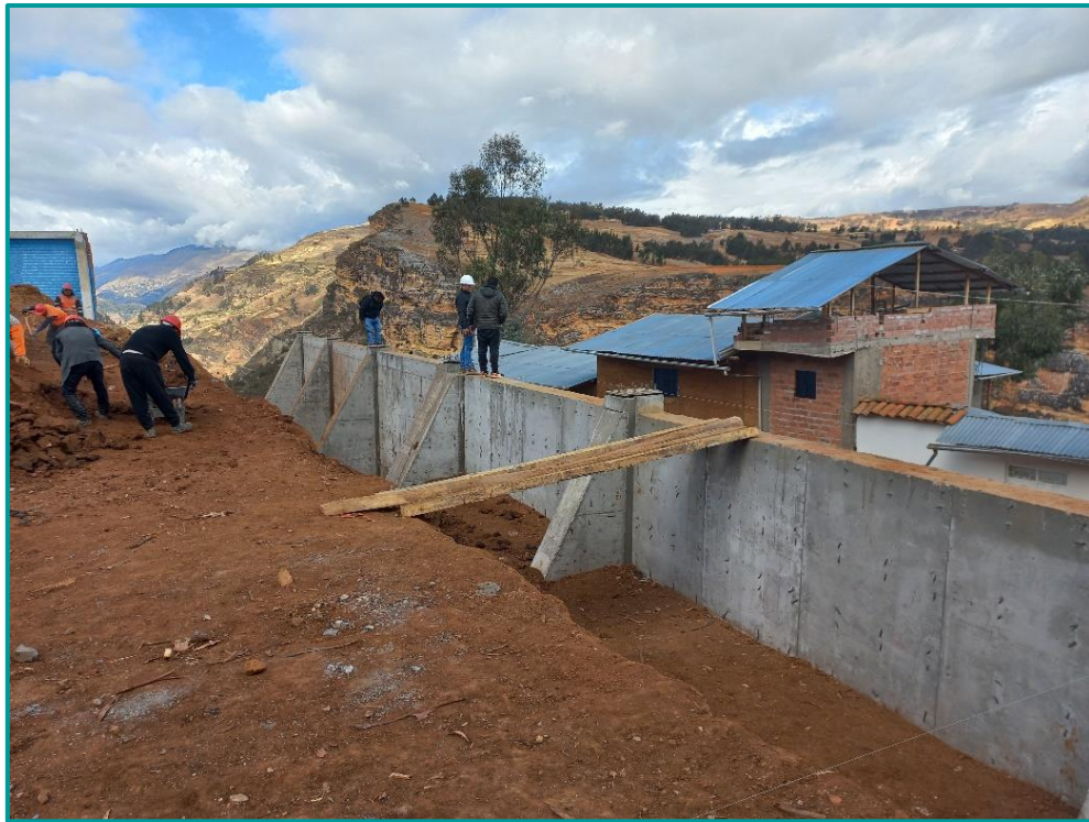
Avances de los trabajos de compactación con material propio seleccionado
