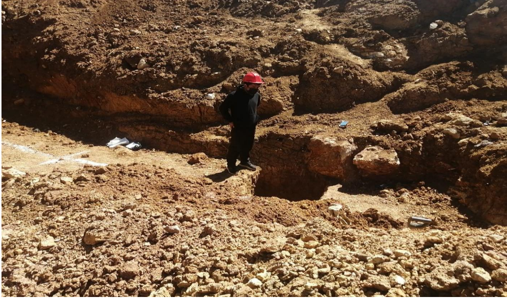
Fig. 51. Verificando la zona de extracción
