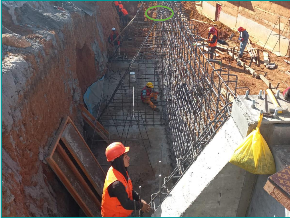
Fig. 10. Montaje de acero
