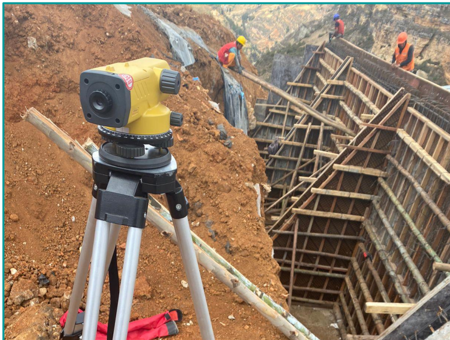
Fig. 19. Control con nivel topográfico
