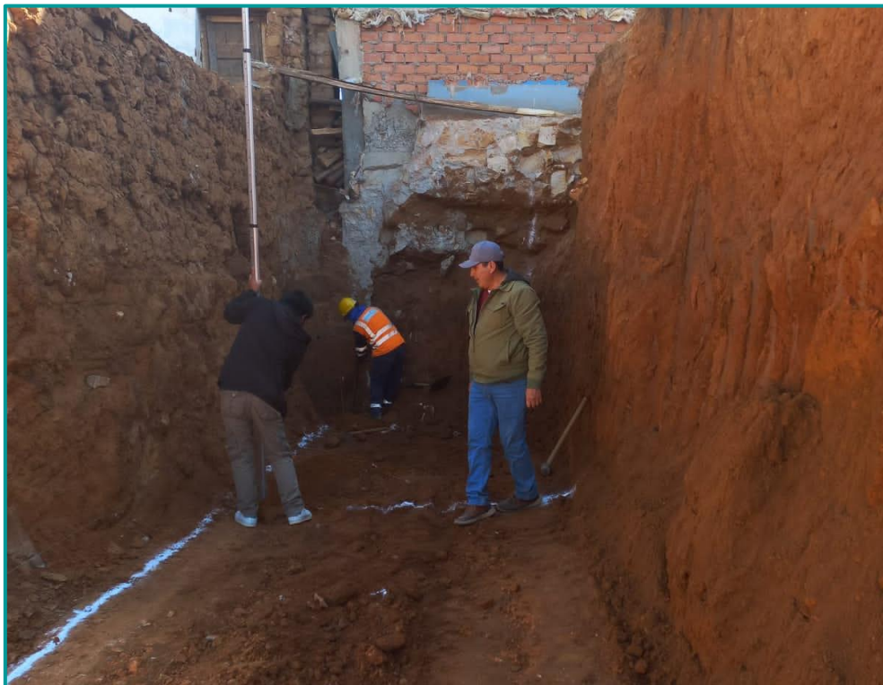
Trabajos de trazo y replanteo
