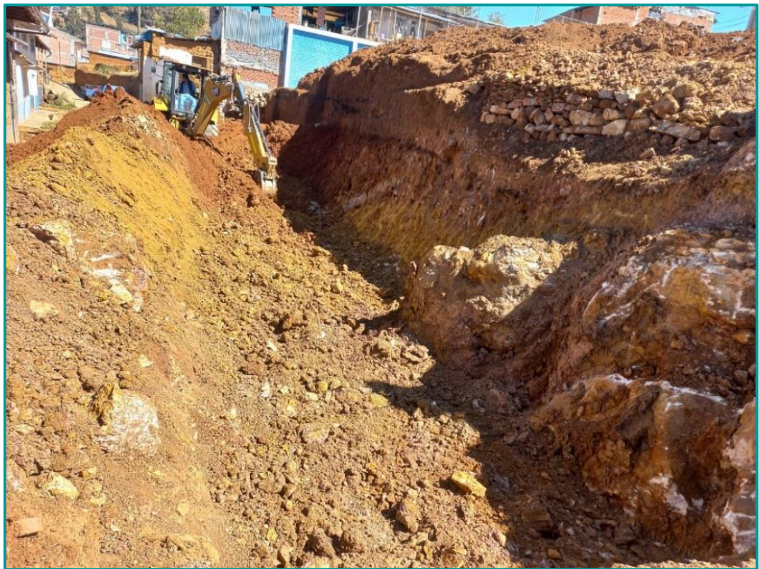
Fig. 6. Excavación masiva y perfilado de talud
