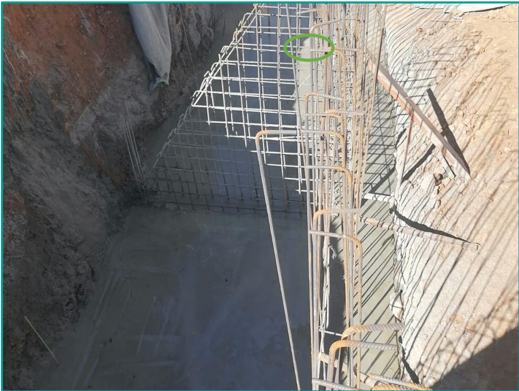
Fig. 11. Montaje de acero
