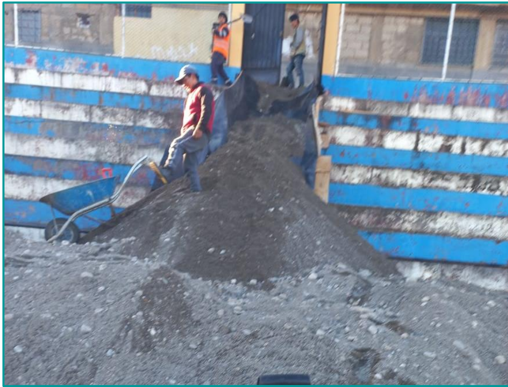
Traslado de agregados
