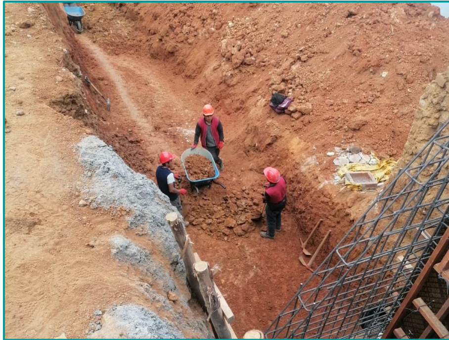
Fig. 7. Estabilización de talud con lechada de cemento y espacio antropométrico
