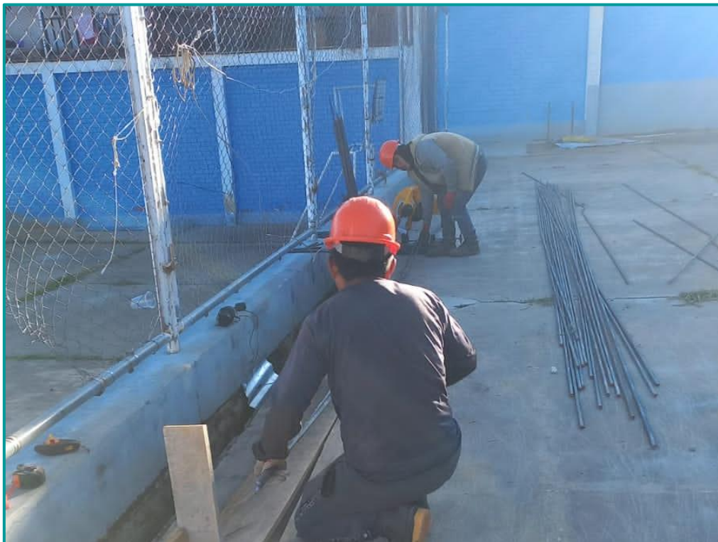
Medición y corte de acero
