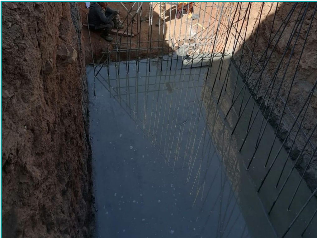
Vaciado en zapatas
