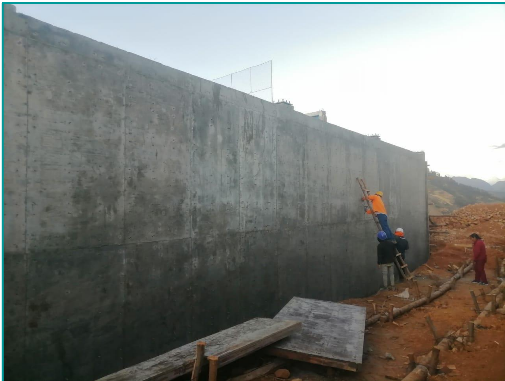
Culminación de los trabajos de desencofrado
