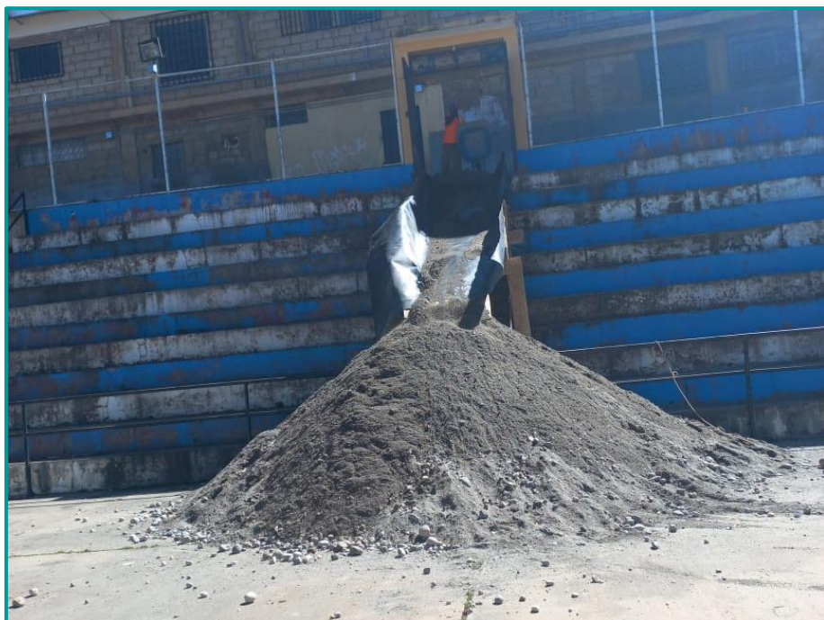
Fig. 8. Rampa provisional para apilamiento de material y otros insumos
