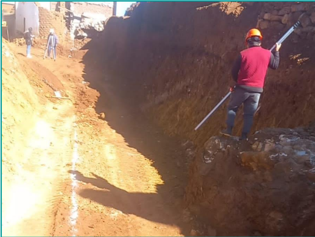
Trabajos de trazo y replanteo
