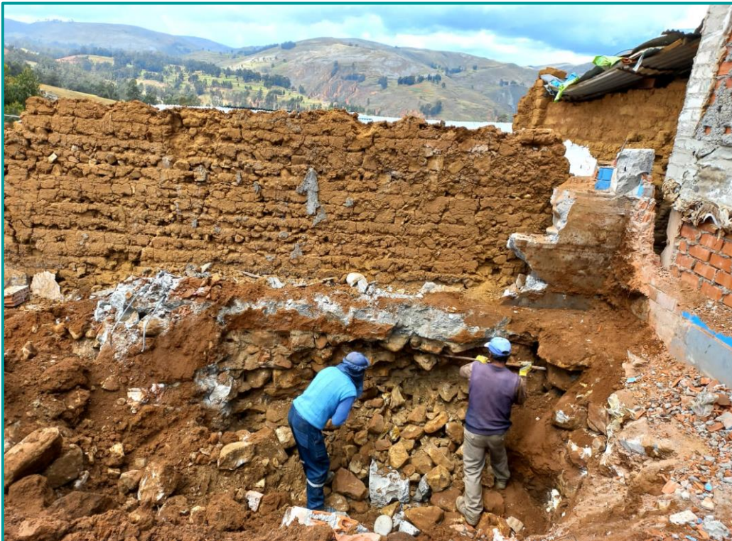
Demolición manual de material rocoso
