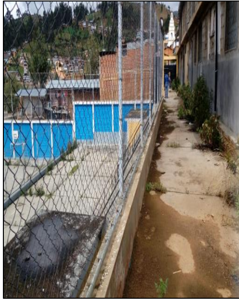
Fig. 30. Se muestra parte de la estructura existente
