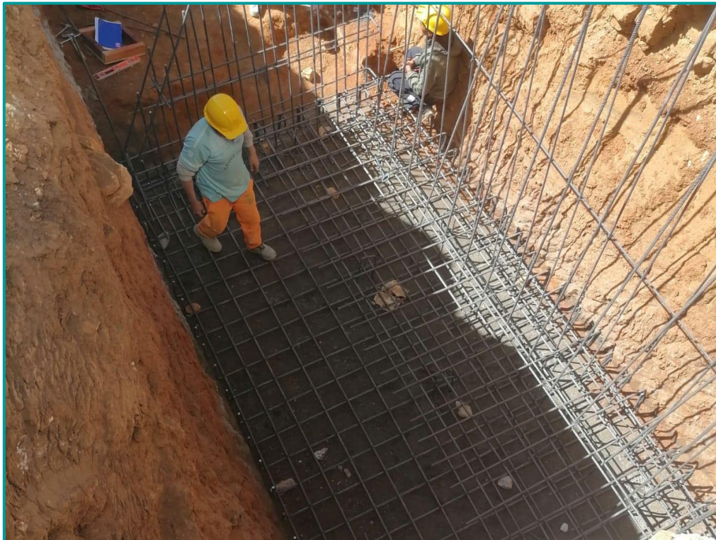
Armado de acero para zapata, pantalla y contrafuerte
