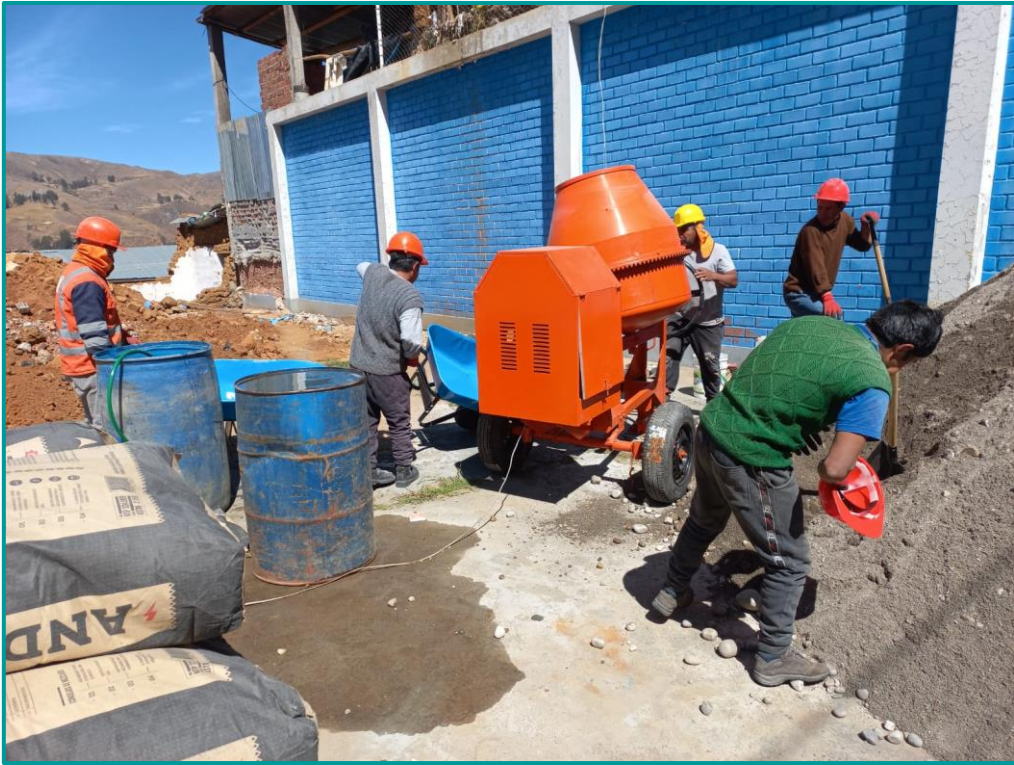
Preparación de mezcla para vaciado en zapata
