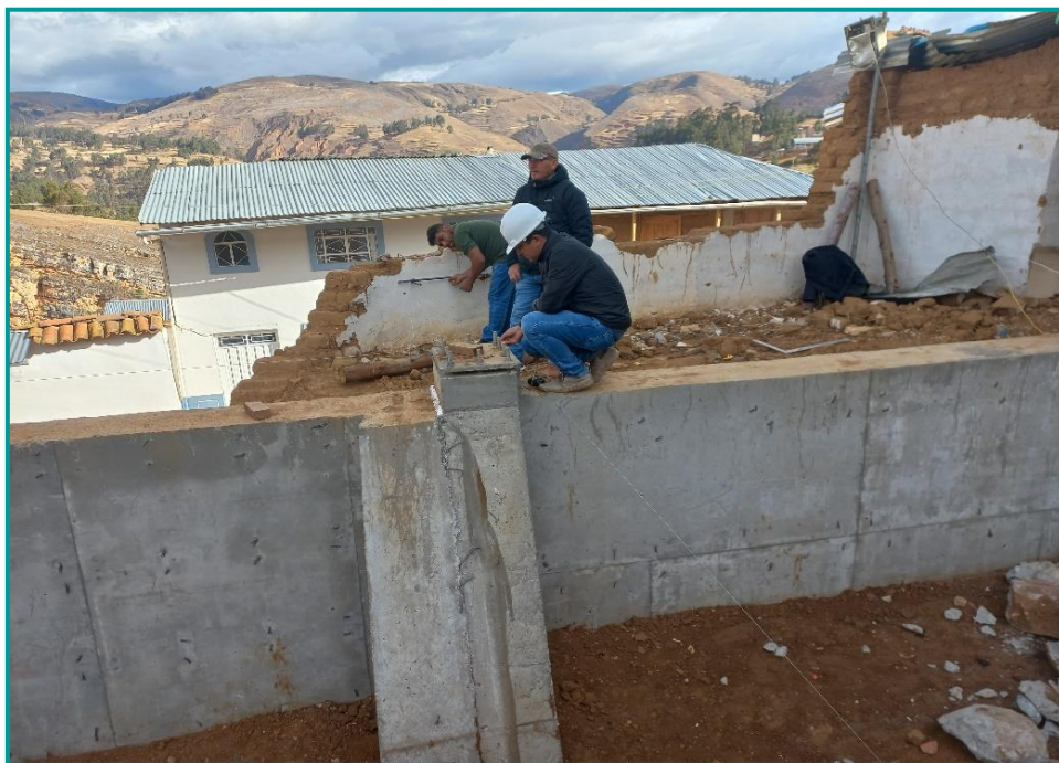
Colocación de placa base o placa nivelante para el sistema de anclaje hacia la cobertura del futuro proyecto
