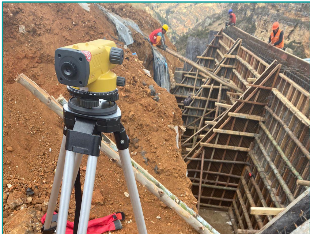
Control de los niveles con instrumento topográfico
