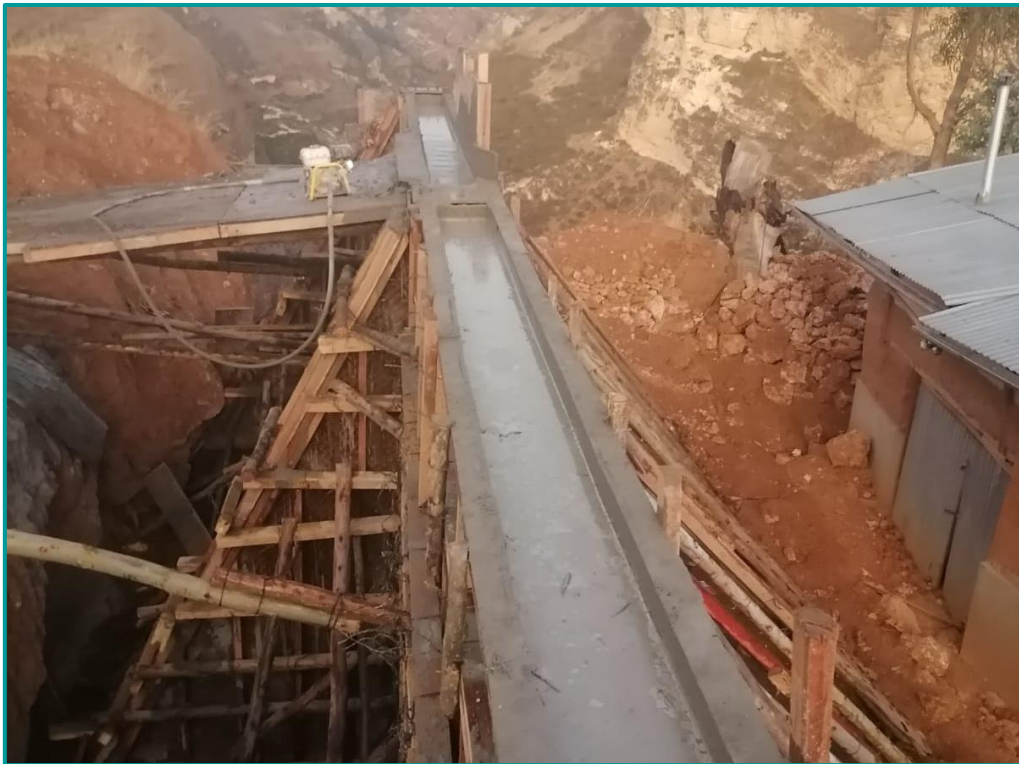
Finalización de los trabajos de vaciado de los 03 tipos de muros
