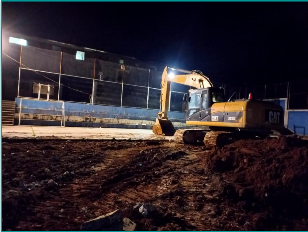
Culminación de trabajos de demolición
