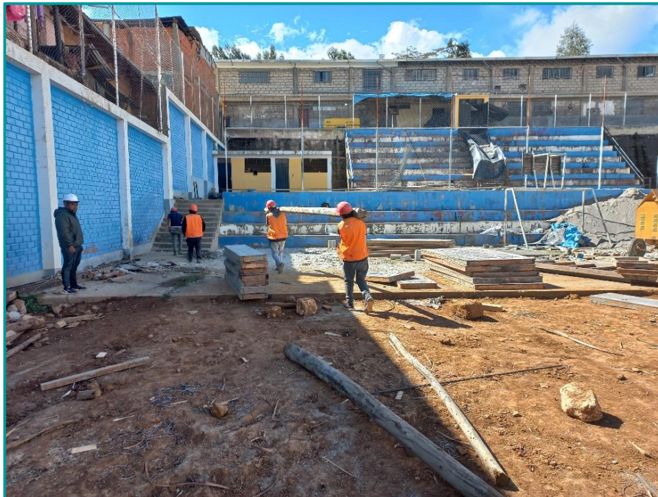
Trabajos finales de limpieza de obra
