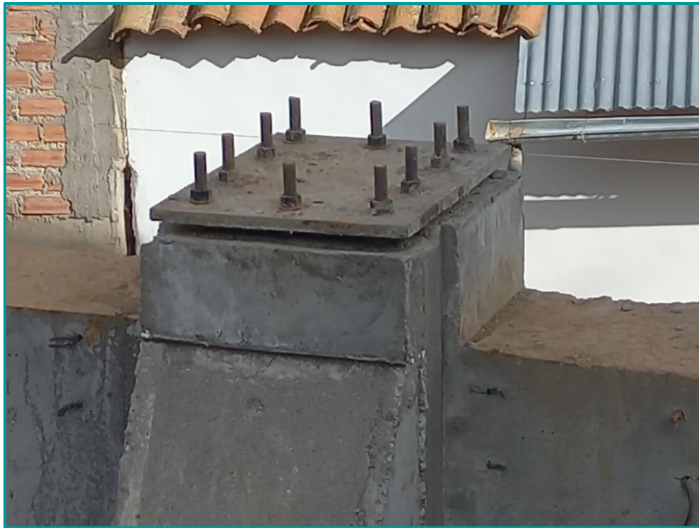
Placa nivelante correctamente puesta y con cordel de referencia para el resto
