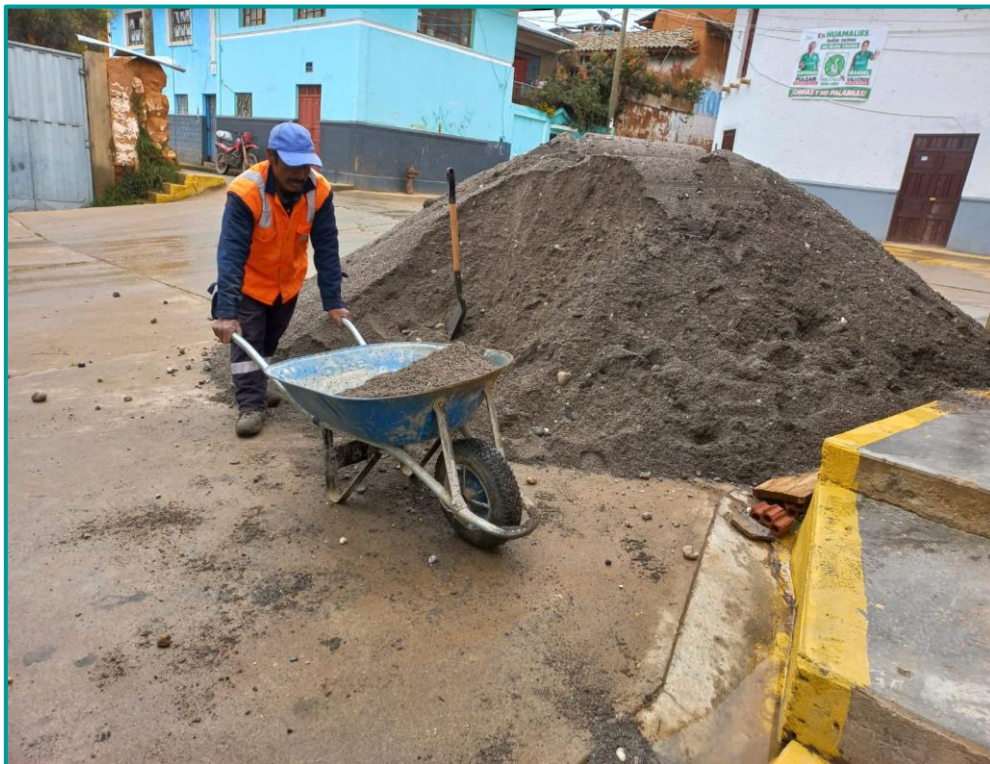
Traslado de agregados
