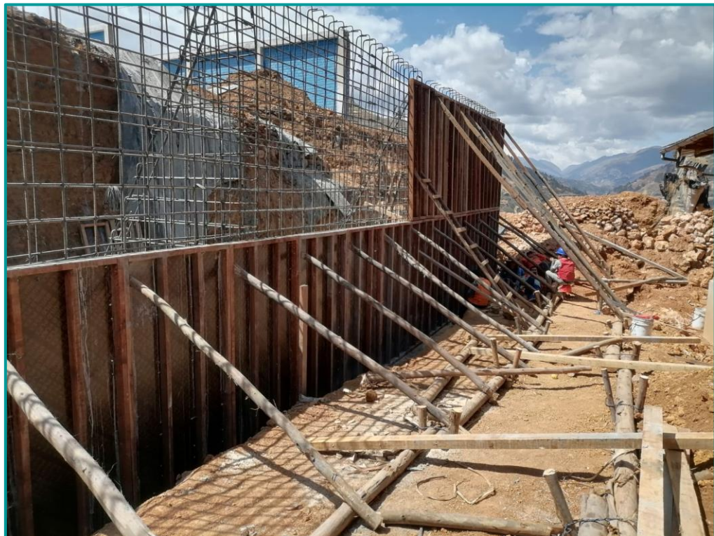
Encofrado de los muros Tipo I, II y III
