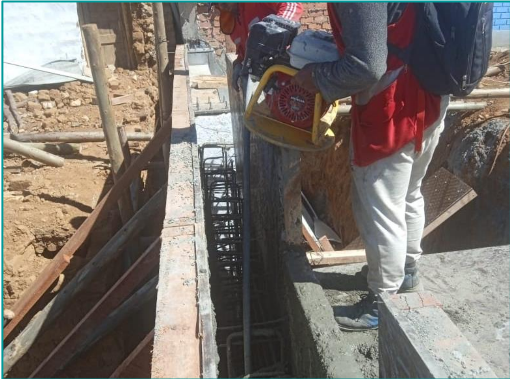
Vibrado del concreto
