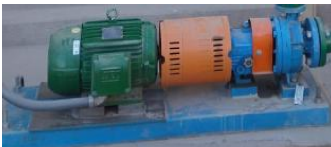
Figura 22: Montaje de bomba centrífuga de 15HP
