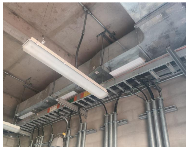
Figura 44: Montaje final de ductos retorno
