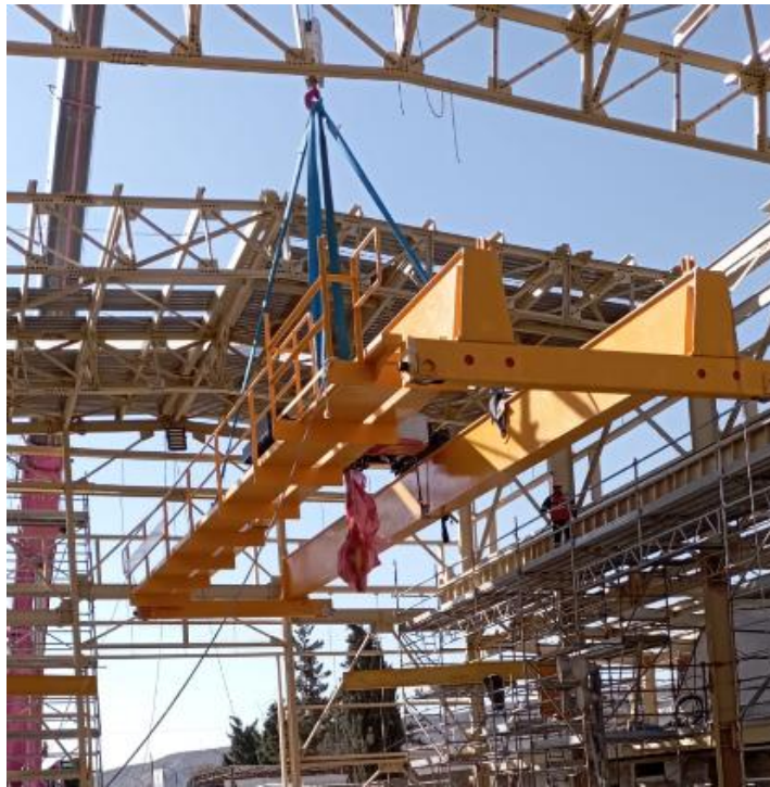
Figura 67: Izaje en U del puente grúa 5726031-CN-005
