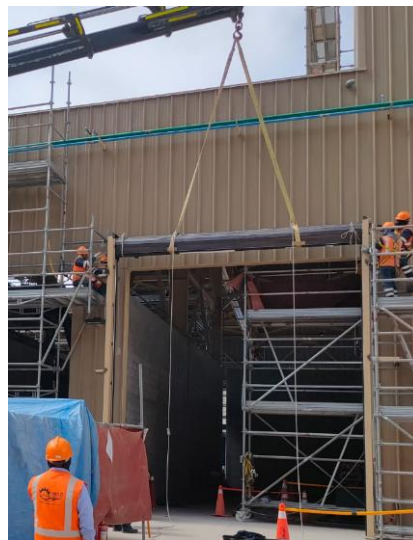
Figura 42: Proceso de montaje de portón corredizo 5951026-XM-001
