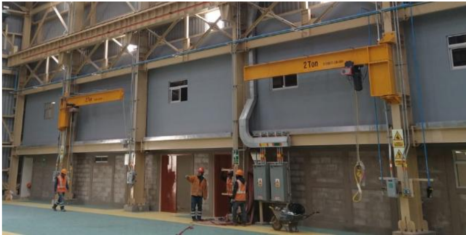
Figura 66: Montaje final de las grúas pescantes
