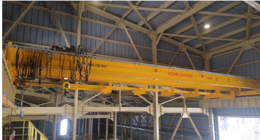
Figura 40: Montaje final del puente grúa
