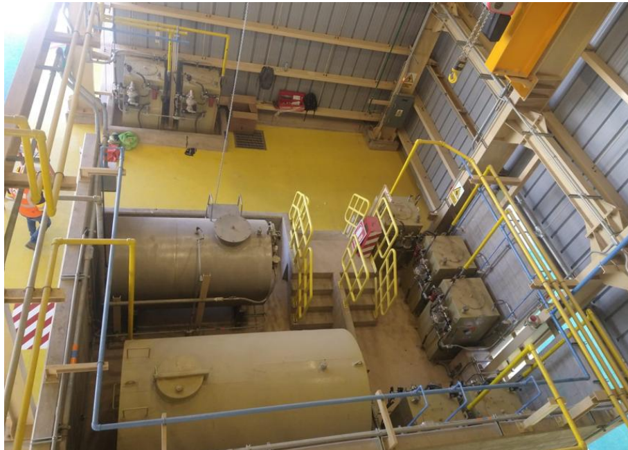
Figura 25: Montaje final de tanques de lubricantes
