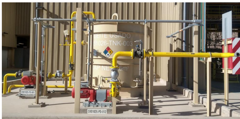
Figura 28: Montaje final de sistema de aceites usados
