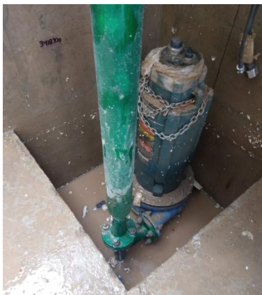
Figura 33: Montaje final de bomba sumergible tipo JCU
