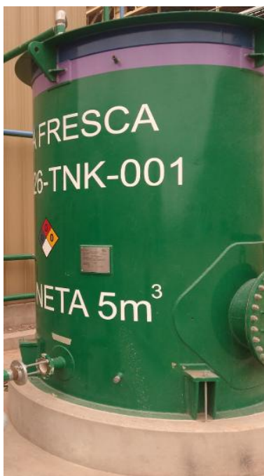
Figura 21: Montaje de tanque de agua fresca
