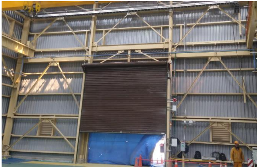
Figura 69: Montaje de portón enrollable 5726031-XM-001
