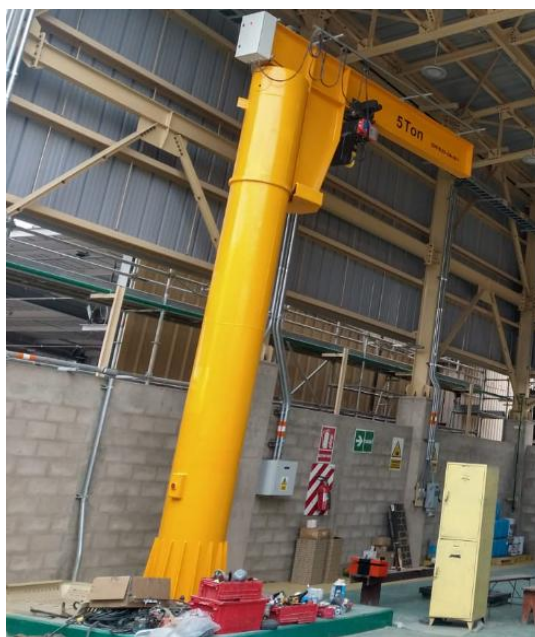
Figura 57: Montaje final de la grúa pescante tipo columna
