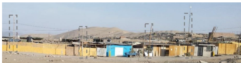
Figura 23. Infraestructura eléctrica en las calles secundarias
