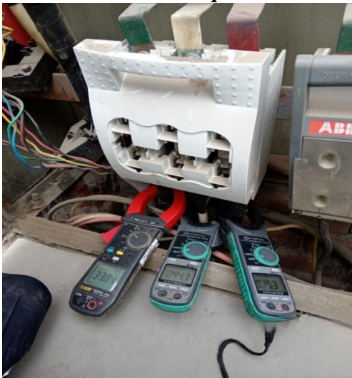
Figura 3.13: Verificación de la llave 1 Fuente: Equans Perú
