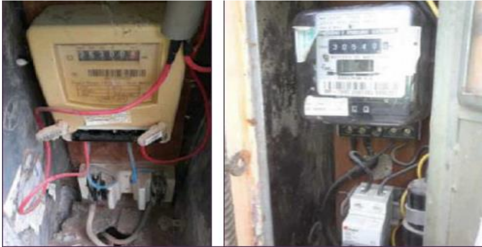
Figura 3.20: Medidores electromecánicos
