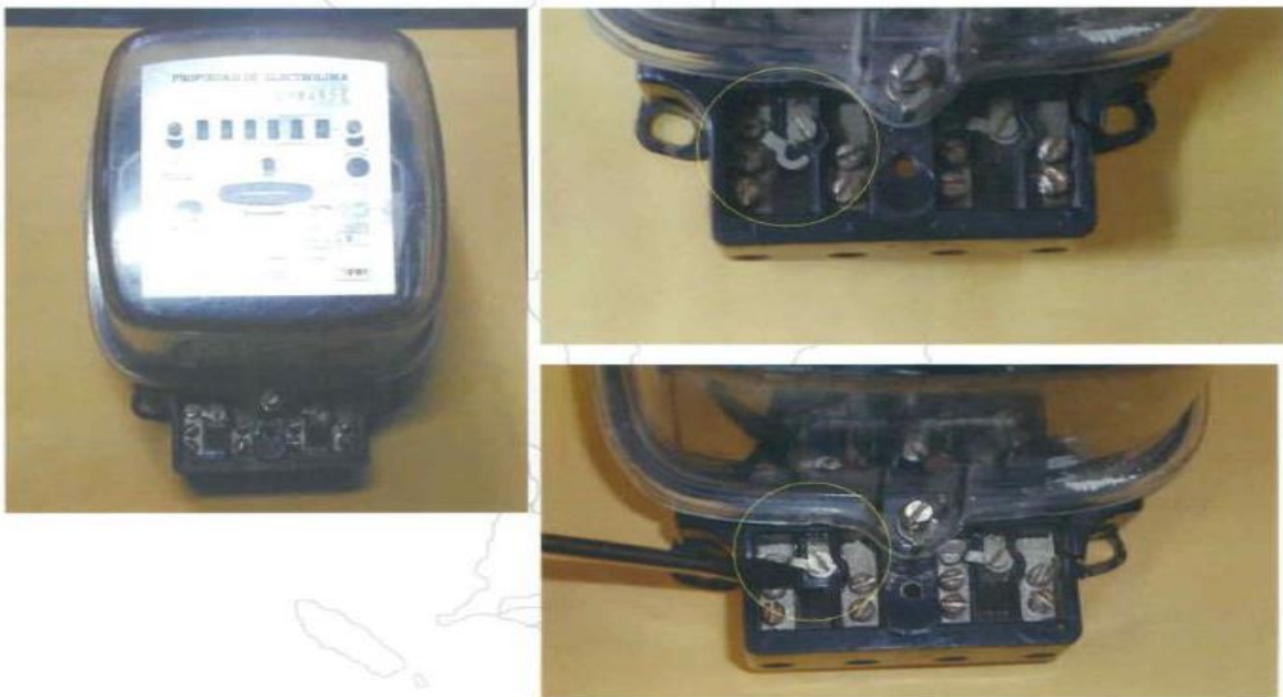
Figura 3.28: Vulneraciones en el equipo de medición
