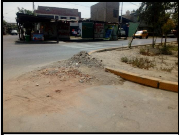
DESMONTES EN LA AV. SIETE (BERMA)
