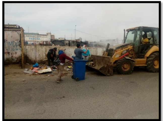
UTILIZACIÓN DE RETROEXCAVADORA Y TACHOS PARA RETIRO DE RESIDUOS
