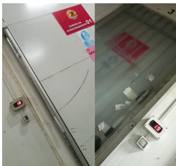
Figura 10. Entrada y Salida en cámaras de Almacenamiento
