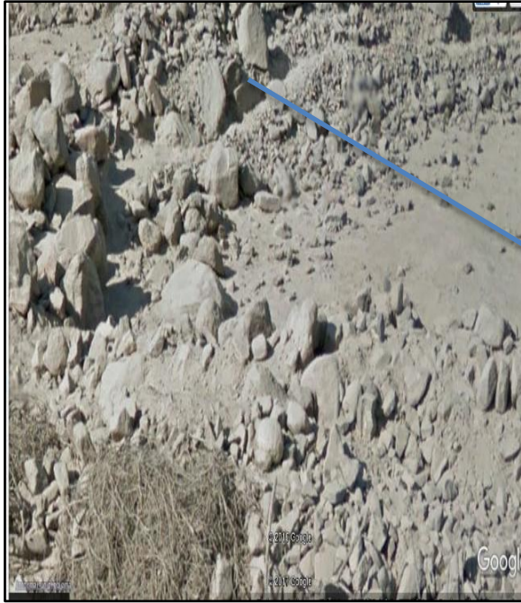
Detalle del paramento o muro
