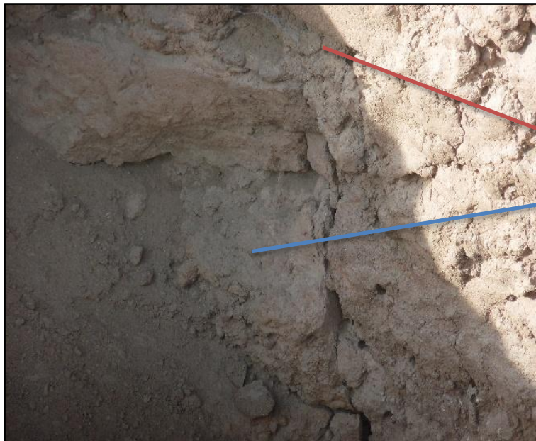
Materiales: adobe y argamasa. sistema constructivo del sitio.
