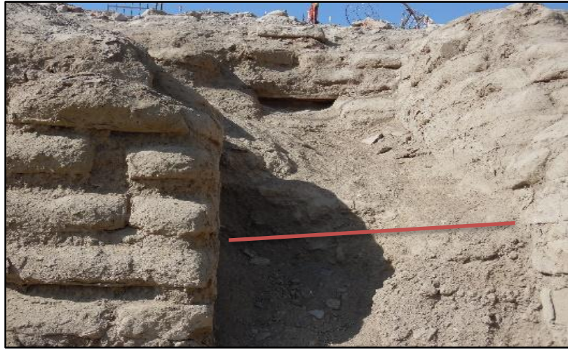
Evidencia de cabeza de muros y entrada clausurada de la pirámide
