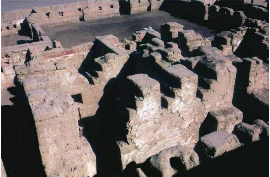
Figura 25. Remate de cabecera de muro escalonado, similar a la L invertida escalonada. Fuente: Protzen y Morris; 2004: 273pg
