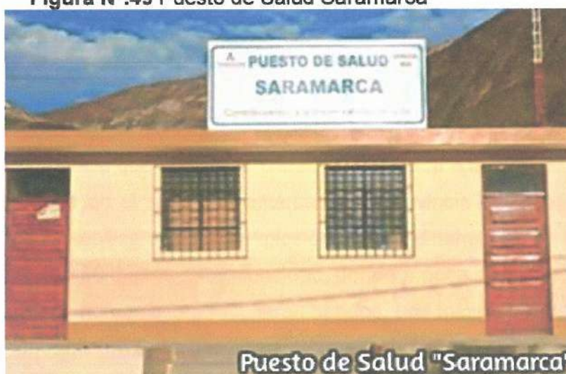
Figura N°.49 Puesto de Salud Saramarca
