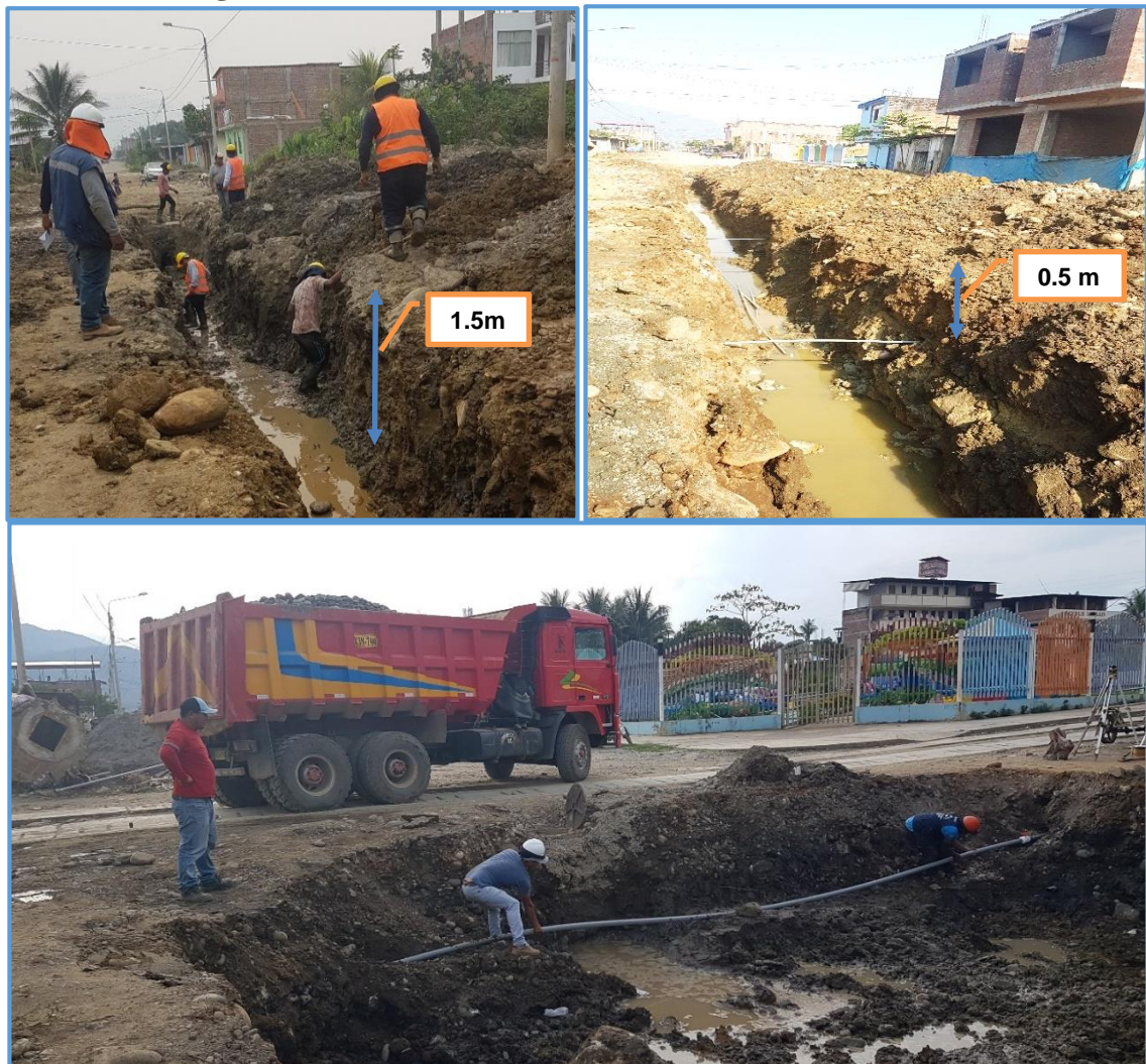
Imagen N°19: Niveles de tuberías de saneamiento existentes
