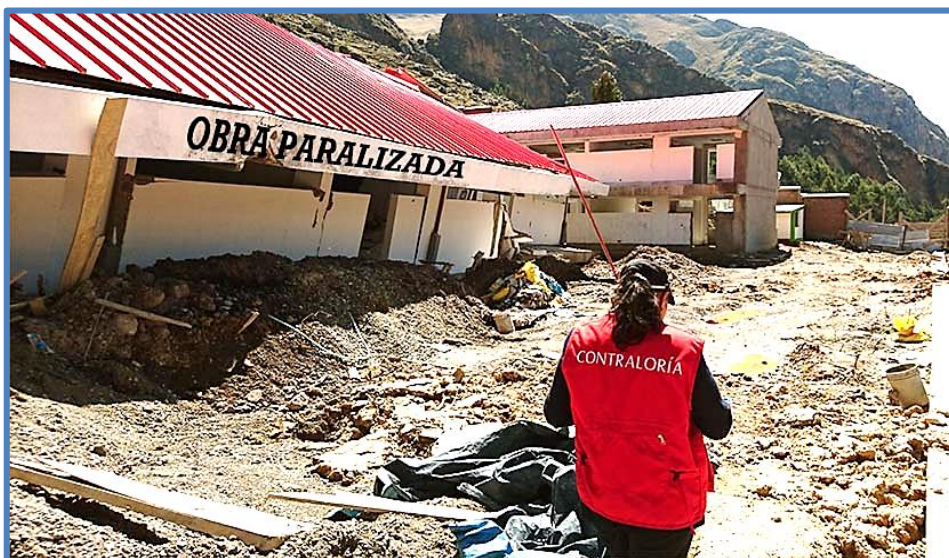
Imagen N°01: Obra Paralizada Referencial.
