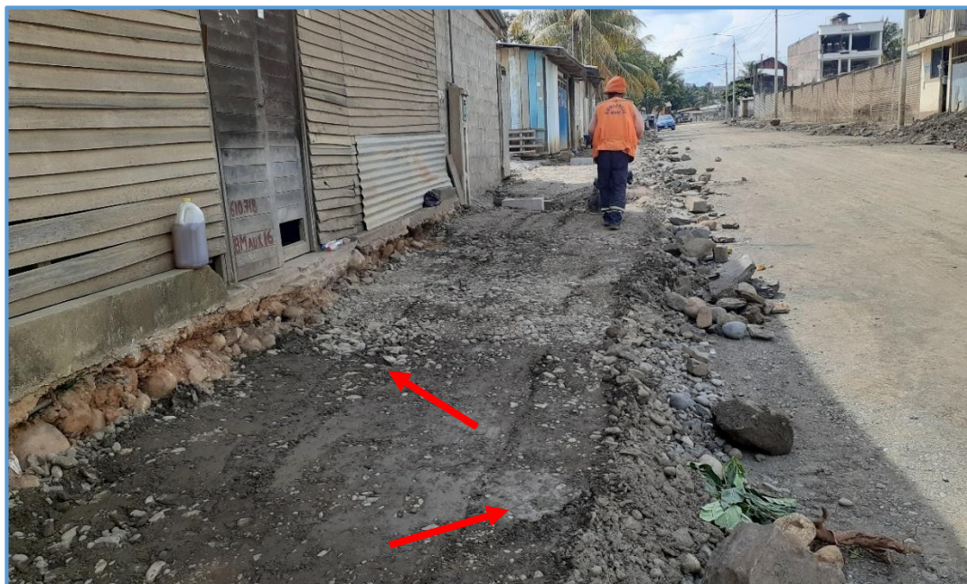
Imagen N°31: Compactado de base granular de veredas
