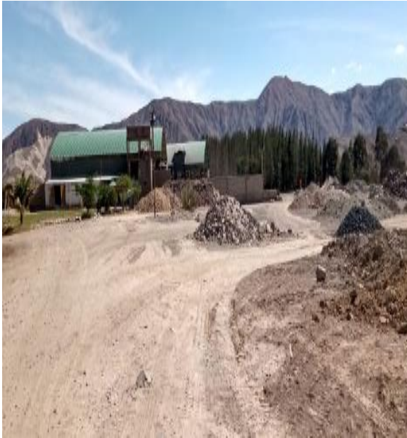
a) Interior de la Planta—Cancha de minerales
