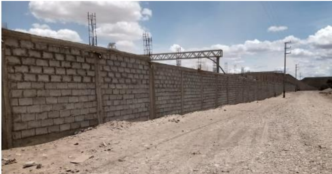
a) Exterior de la Planta
