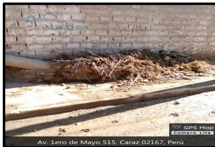
Figura N° 25: Material propio conglomerado
