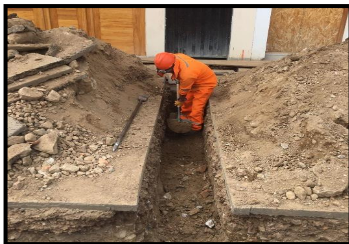
Figura N° 12: Refine y Nivelación de Fondo de Zanja
