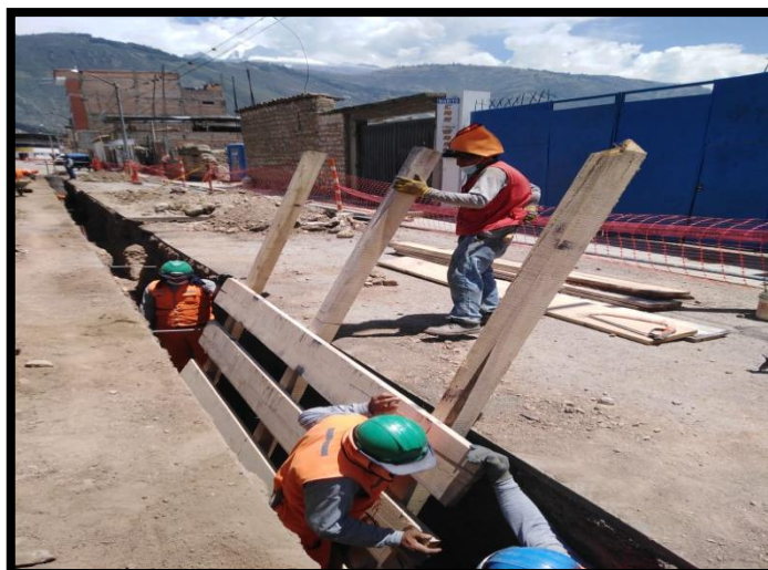
Figura N° 16: Entibado de zanjas
