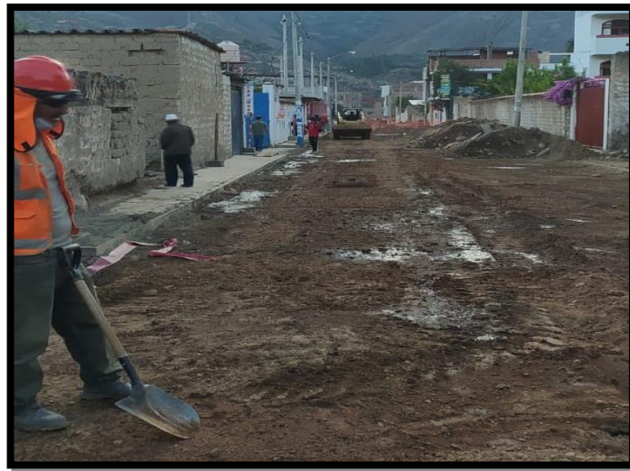
Figura N° 22: Limpieza y disposición final del material de desmonte en zonas las cuales ya se terminó los trabajos de remoción de tierra
