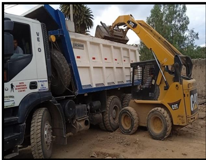
Figura N° 13: Eliminación De Material Propio
