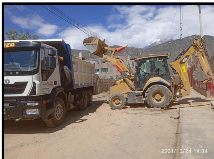
Figura N° 17: Eliminación de material de desmonte
