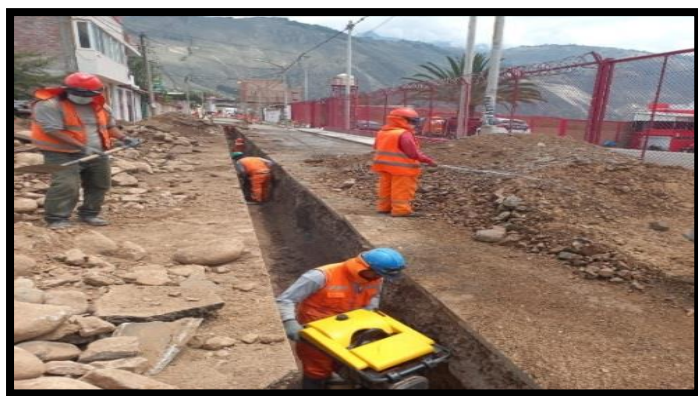
Figura N° 11: Compactación Con Material Propio y Control De Material Particulado
