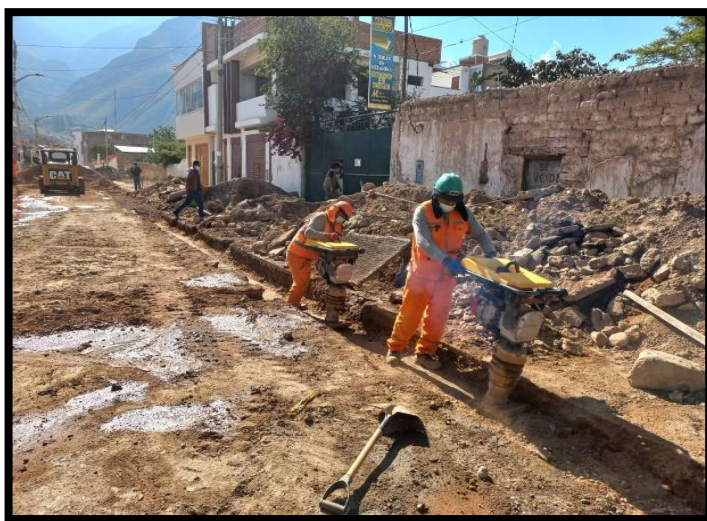
Figura N° 19: Compactación con Material Propio en zanja
