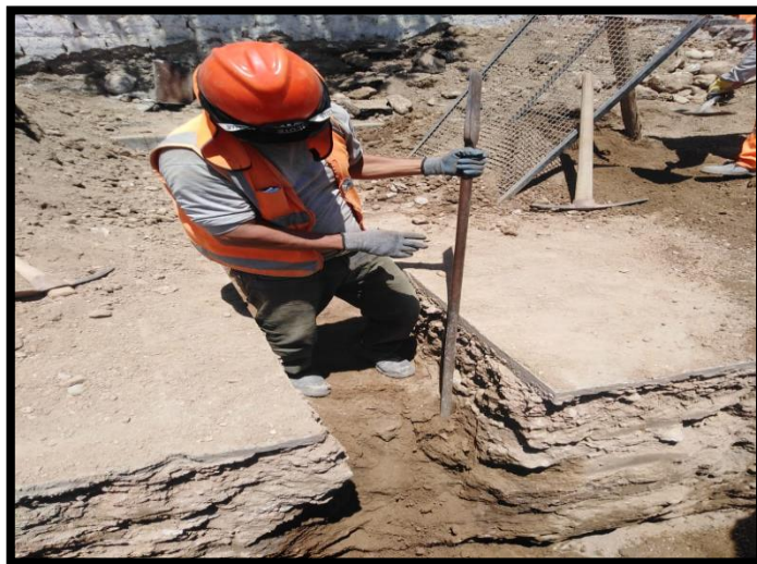
Figura N° 15: Excavación de Zanja
