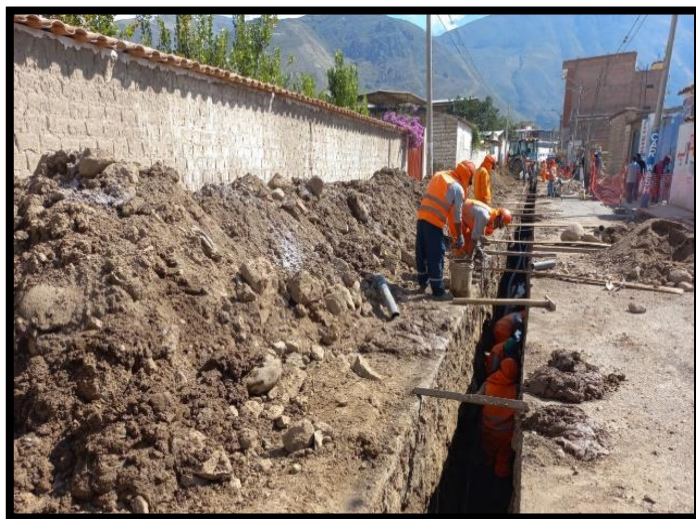
Figura N° 18: Instalación de tubería de agua potable
