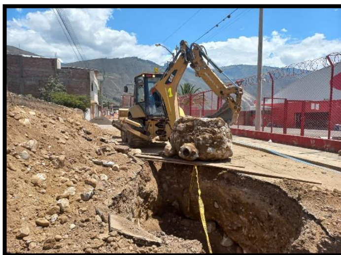
Figura N° 14: Excavación De Zanja En Conglomerado De Rocas
