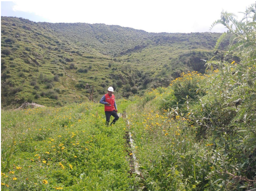
Fig. 3 Tramo 0+540 – 0+790.60, excesiva vegetación en casi todo el tramo
