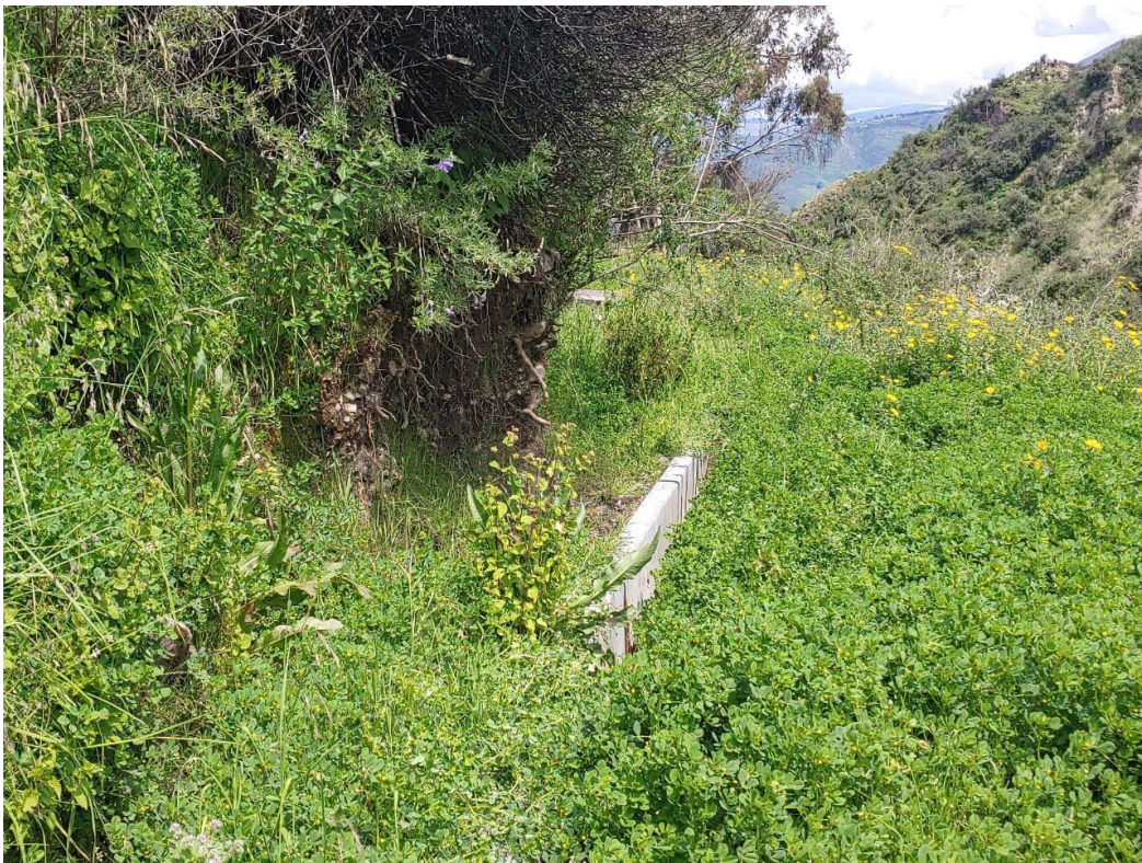
Foto 4. Excesiva vegetación en todo el tramo
