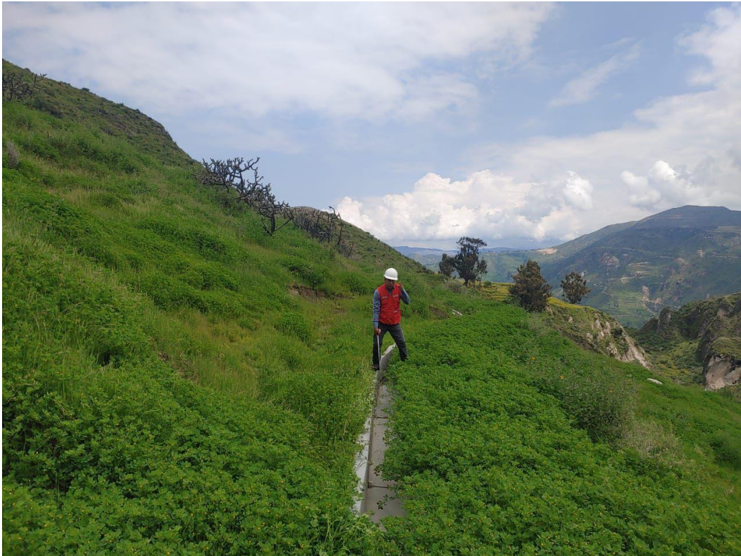
Foto 5. Excesiva vegetación en otros tramos
