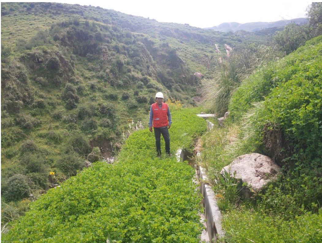
Foto 8. Excesiva vegetación en otros tramos
