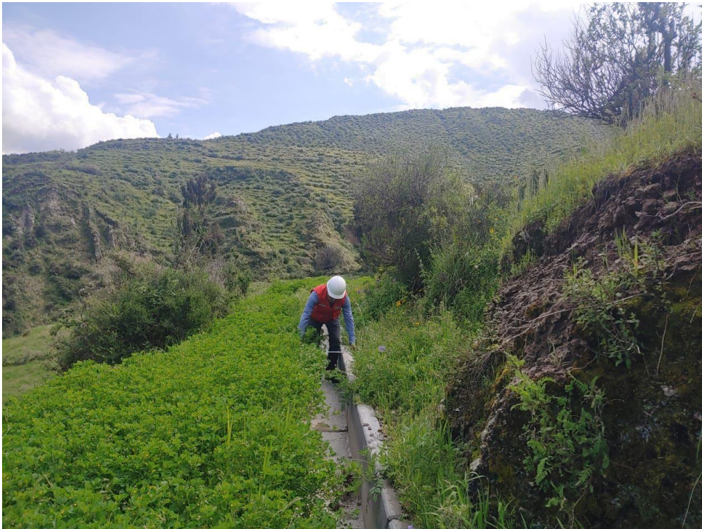
Foto 18. Medición del ancho del canal
