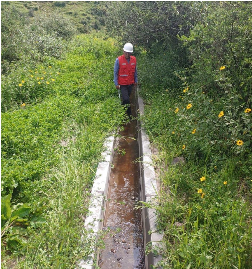
Foto 16. Otros tramos del canal
