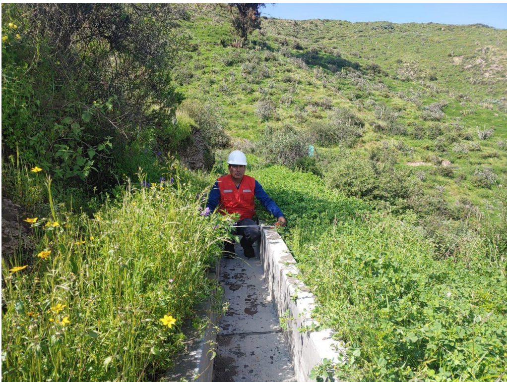
Foto 12. Tomando medidas del canal
