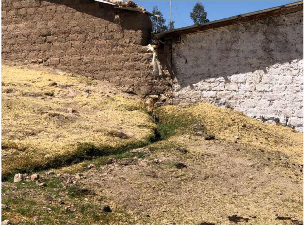
Fig. 30 Presencia de cunetas naturales en el Centro Poblado
