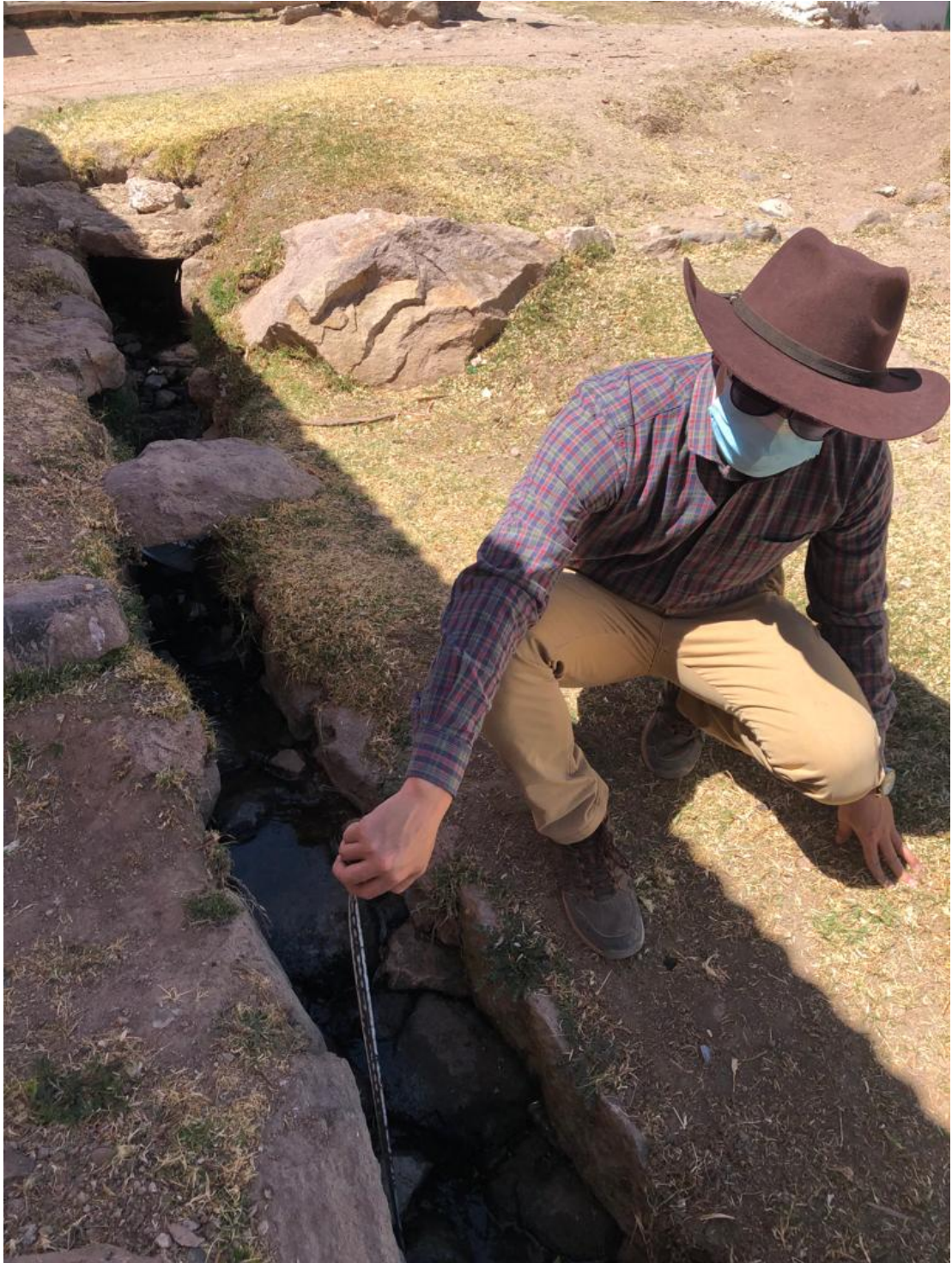
Fig. 15 Vista técnica a los canales de desagüe pluvial del Centro Poblado
