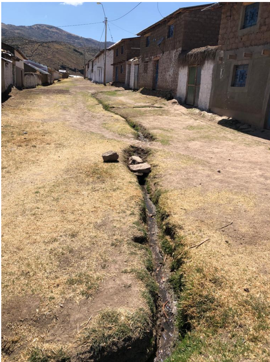
Fig. 14 Otros canales por donde se evacuan las lluvias en el Centro Poblado
