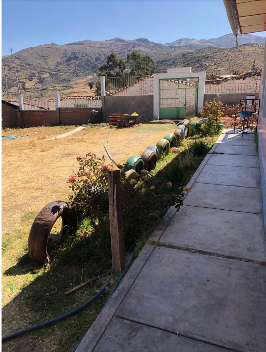
Fig. 23 Se reitera la inexistencia de cunetas de desagüe pluvial
