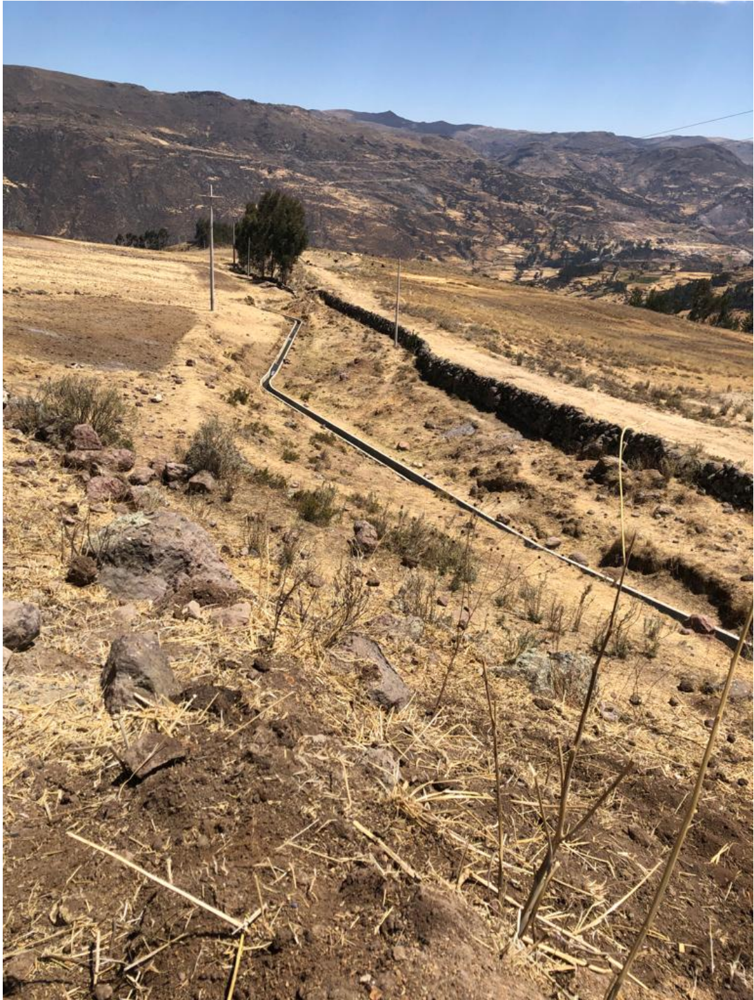
Fig. 16 Canaleta de desagüe pluvial del Centro Poblado – Sector 2
