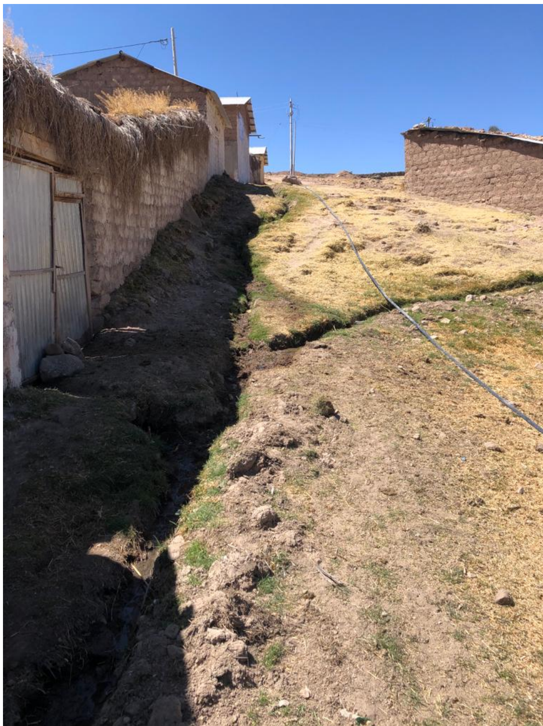
Fig. 13 Canales por donde se evacuan las lluvias en el Centro Poblado
