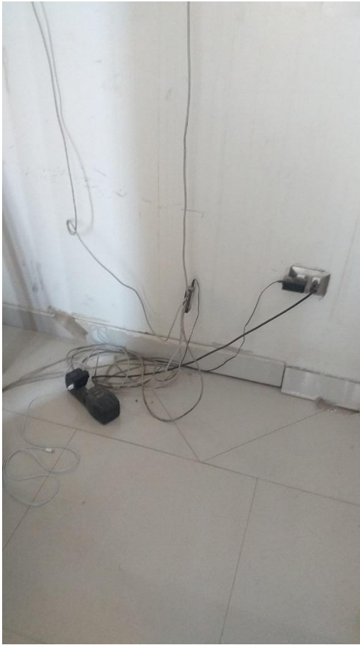
Fig. 27. Conexiones caóticas
