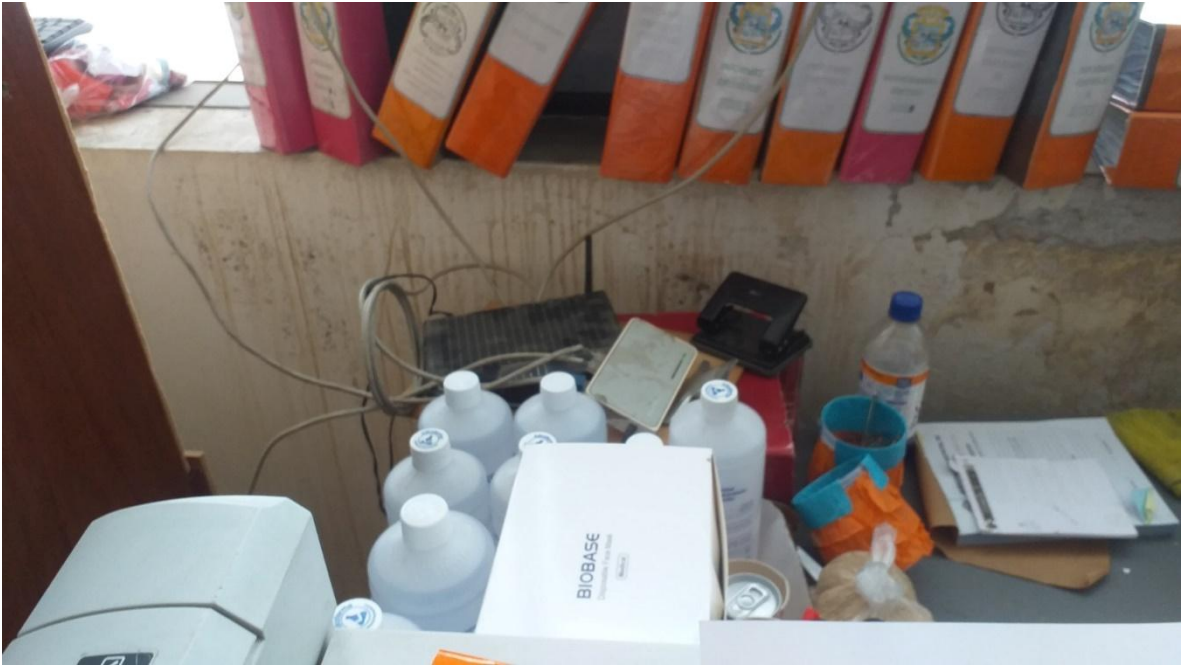
Fig. 26. Conexión de switch de comunicaciones
