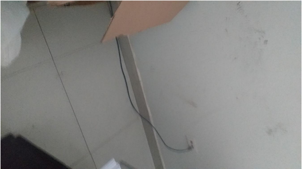
Fig. 17. Canaleteado deficiente
