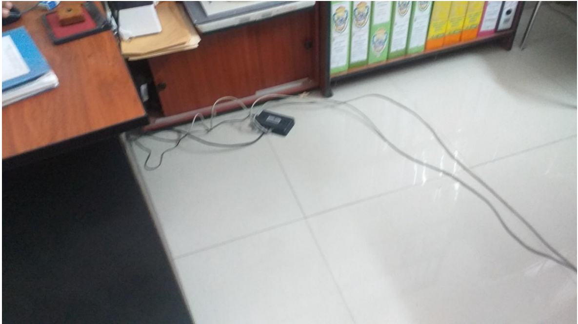
Fig. 24. Improvisación de conexiones de red
