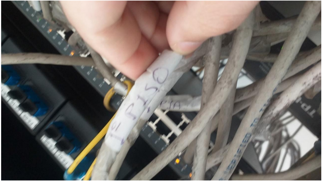
Fig. 10. Estado de la identificación de los puntos de red.
