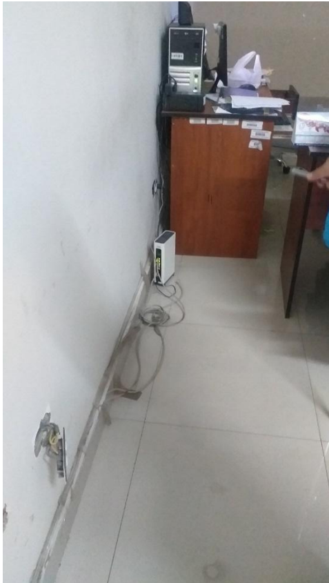
Fig. 19. Equipos de comunicación y cableado deficiente
