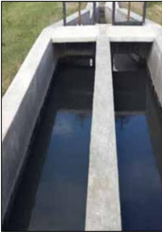
Figura 2.2. Desarenador de doble línea.
