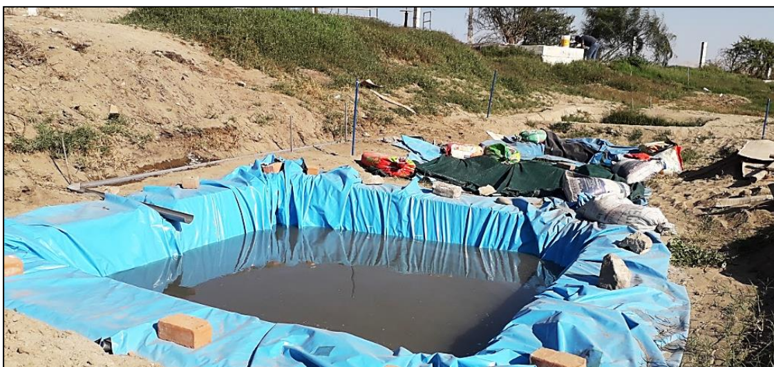
Figura 3.25. Laguna anaerobia, llenada hasta el nivel adecuado
