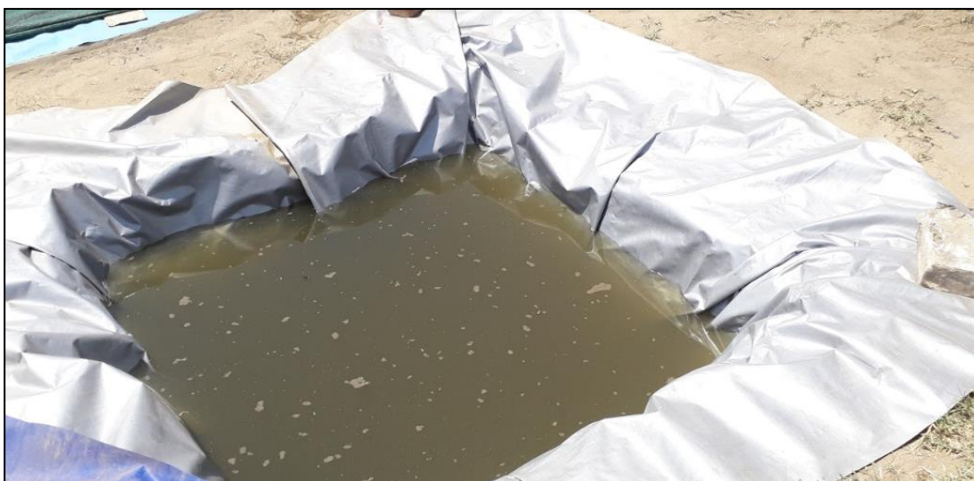
Figura 3.27. Laguna secundaria, con nivel adecuado de agua residual
