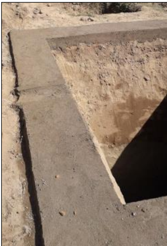
Figura 3.14. Base de cemento alrededor de esta
