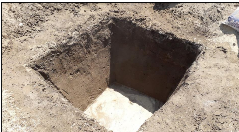
Figura 3.17. Ligera base de cemento en el fondo
