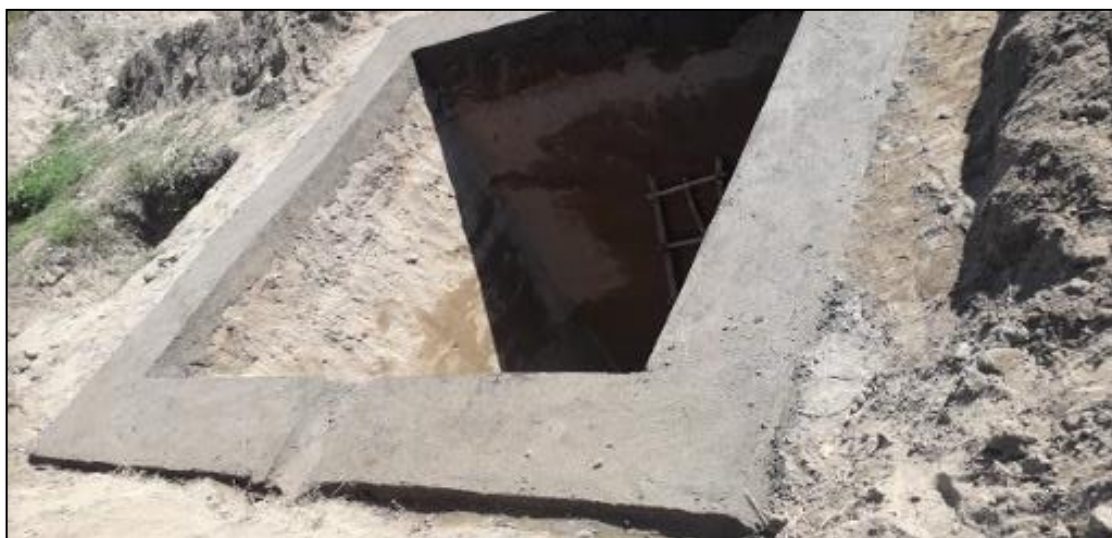
Figura 3.15. Laguna anaerobia culminada
