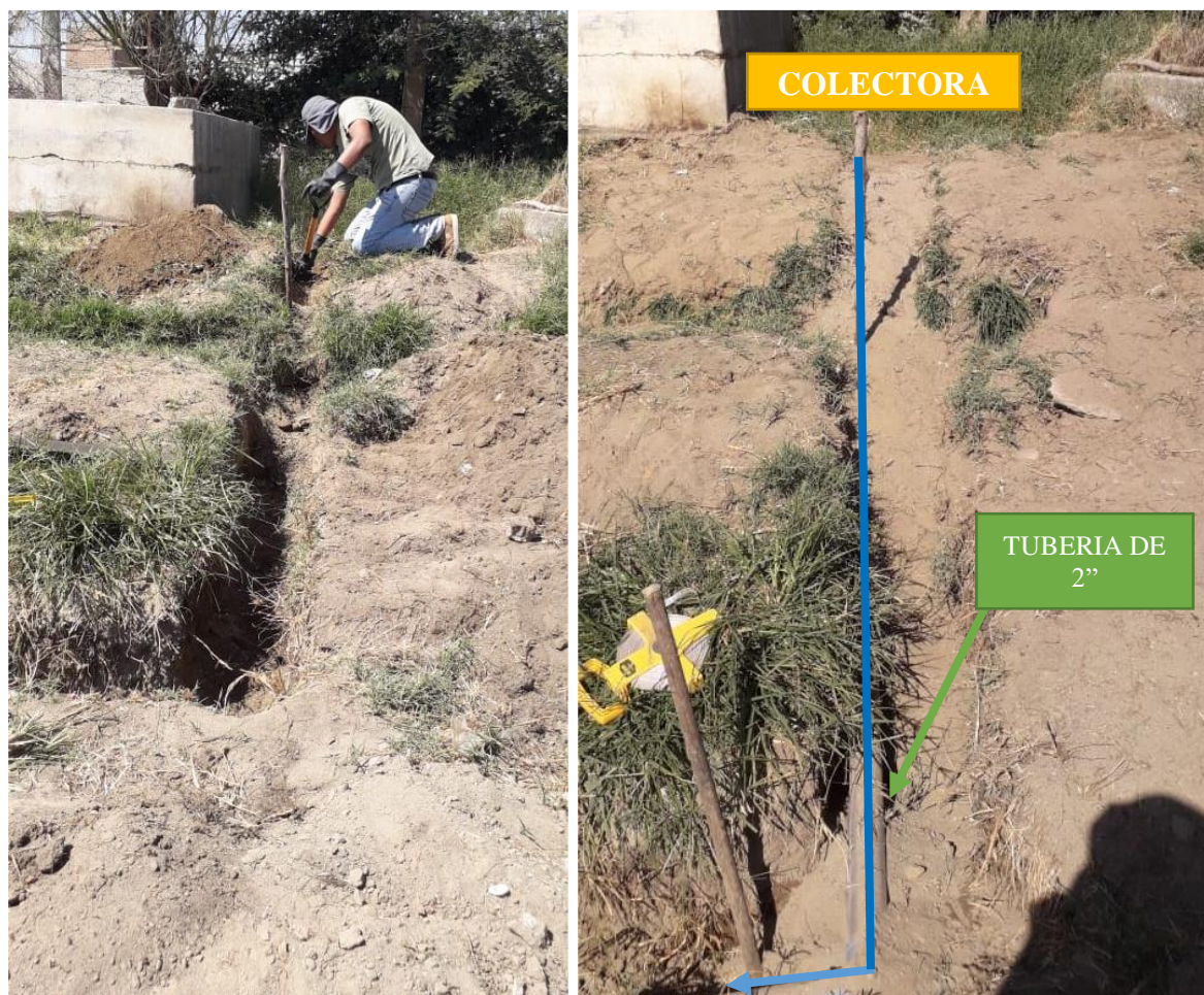
Figura 3.7. Colocación de la tubería de captación
