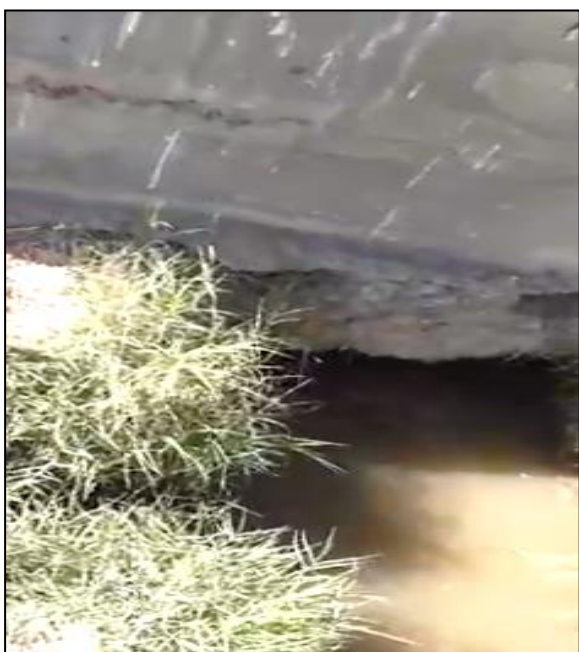
Figura 3.31. Colectora de la planta de tratamiento de Cachiche
