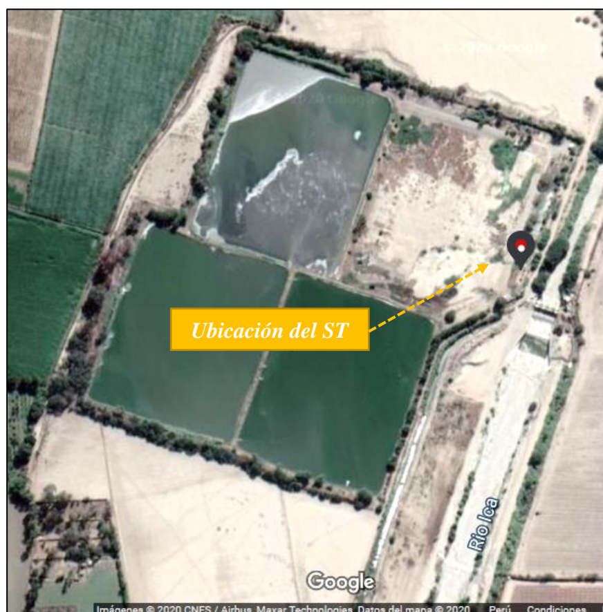
Figura 3.6. Ubicación exterior del ST
