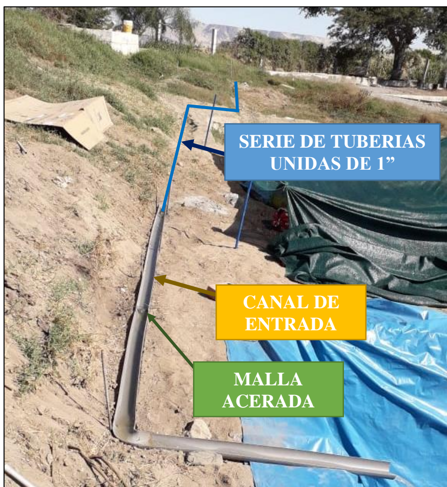
Figura 3.10. Colocación del canal de entrada
