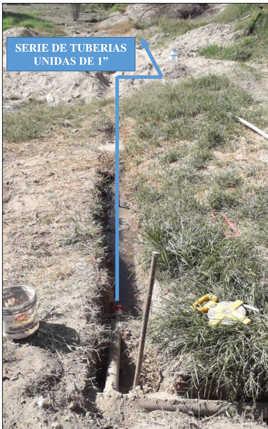
Figura 3.9. Colocación de tuberías de transporte de 1 pulgada
