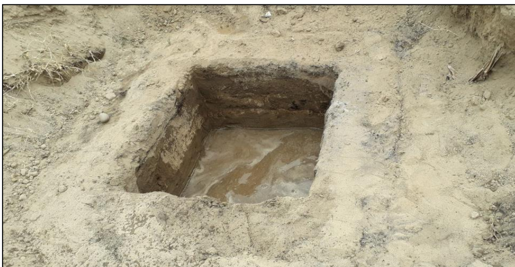
Figura 3.16. Empozando de agua a la laguna, para que los taludes tomen consistencia
