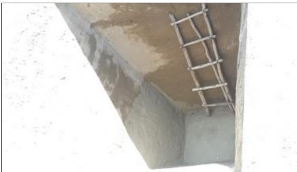
Figura 3.13. Laguna anaerobia, con taludes y profundidad definidos
