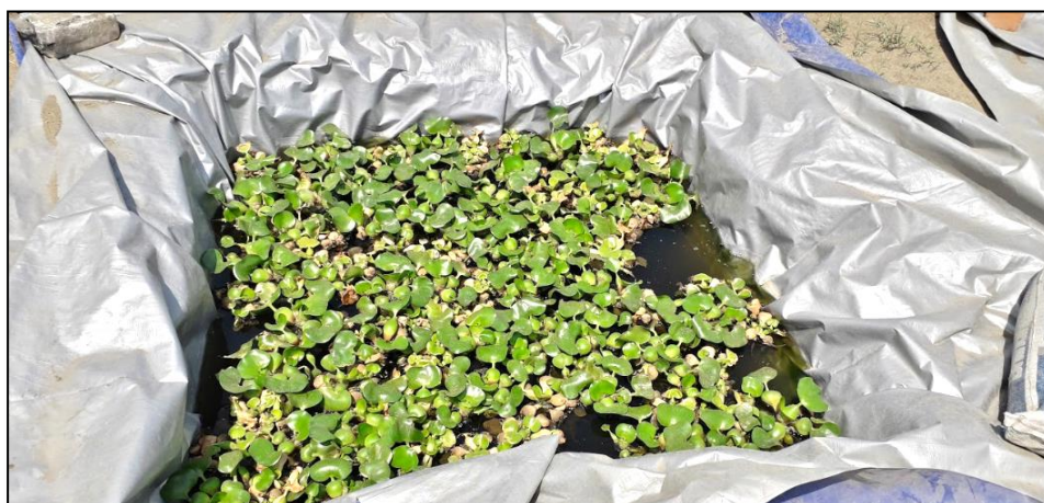
Figura 3.29. Laguna secundaria, cubierta con jacintos de agua
