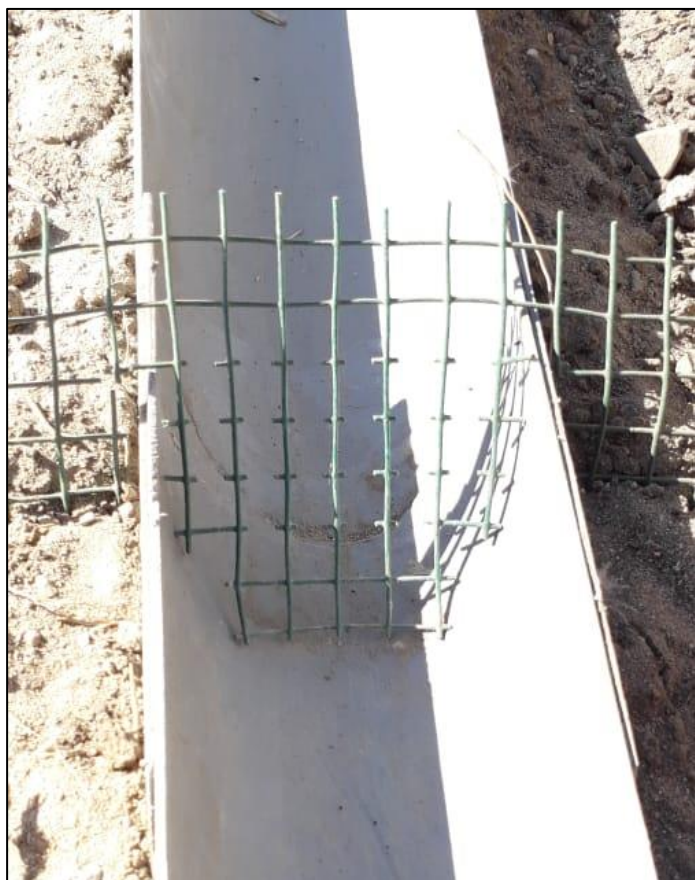
Figura 3.11. Colocación de la malla acerada
