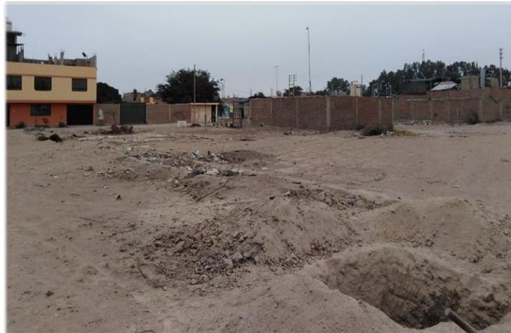
**Fig.7.** Para las calicatas de exploración con profundidad entre 1.00 a 2.50m se utilizaron herramientas manuales
