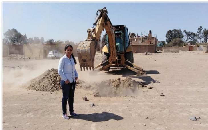
**Fig.8.** Para excavación de la calicata C-7 con fines de cimentación de la cámara de bombeo se utilizó maquinaria pesada
