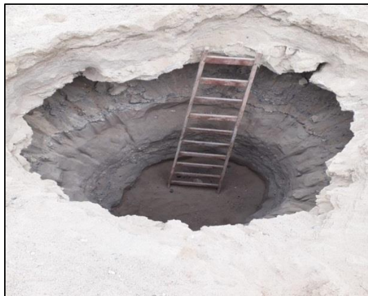
Fotografía: Vista de la Calicata sin presencia de nivel freático.
