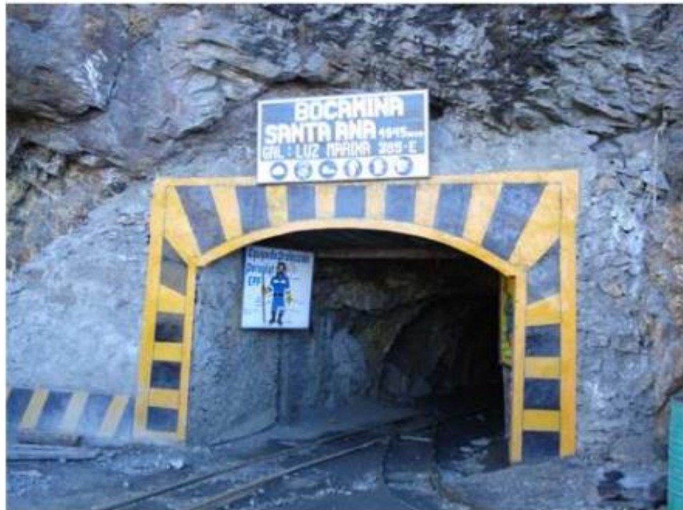
Foto 5. Bocamina Santa Ana.
