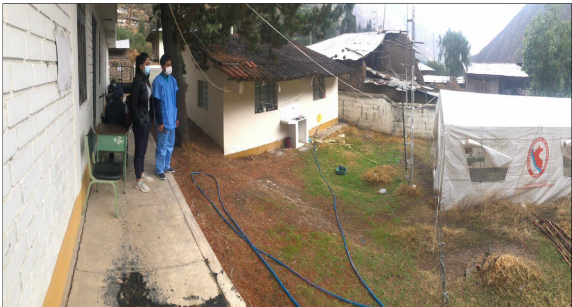
Figura.3 Situación actual al interior del Centro de Salud
