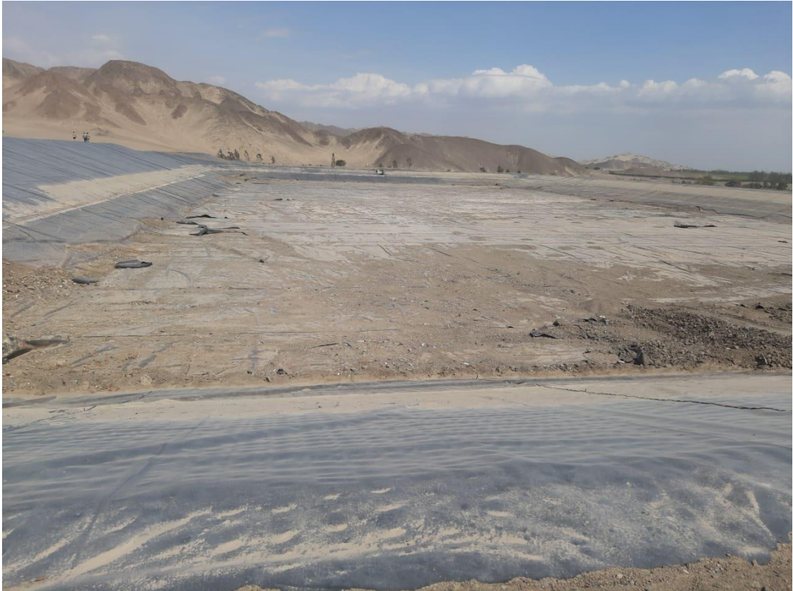
Foto 03 Laguna en mantenimiento
