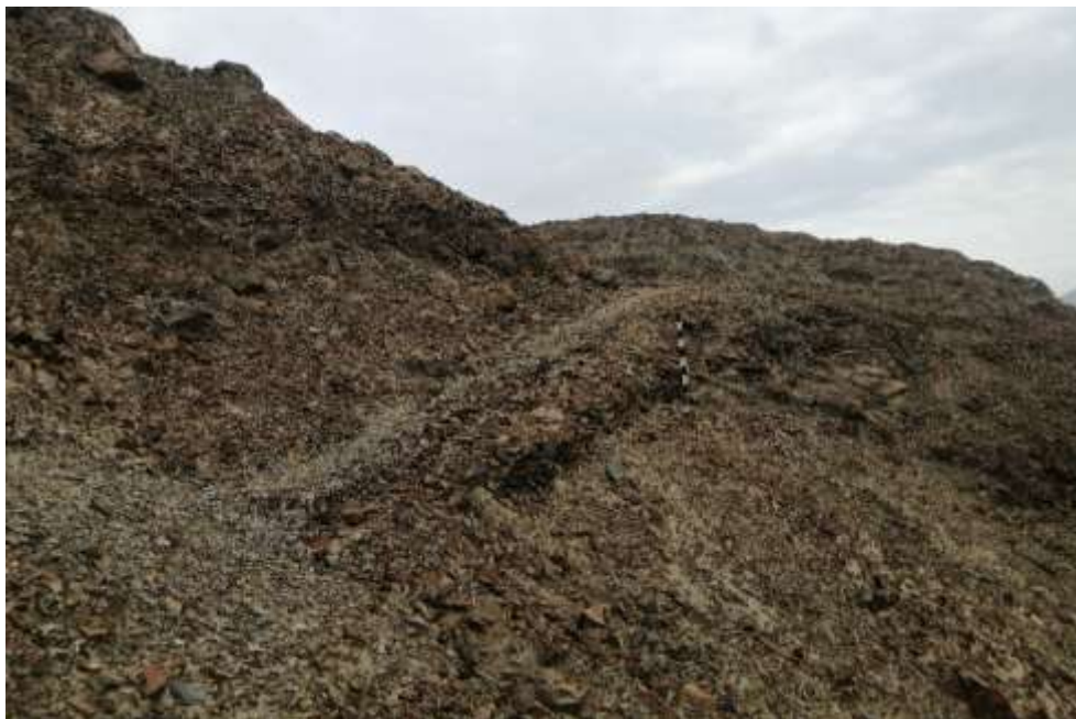
Figura 59: Vista general del muro de contención del acceso principal, sector C - centro poblado de Casa Blanca. Fuente: Gaby Pardo Taquiri.
