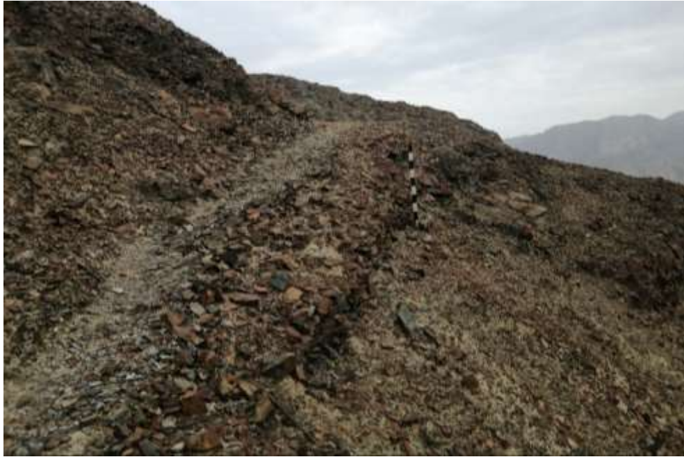
Figura 111: Vista general del muro de contención del camino que llega al sector C. Fuente: Gaby Pardo Taquiri.
