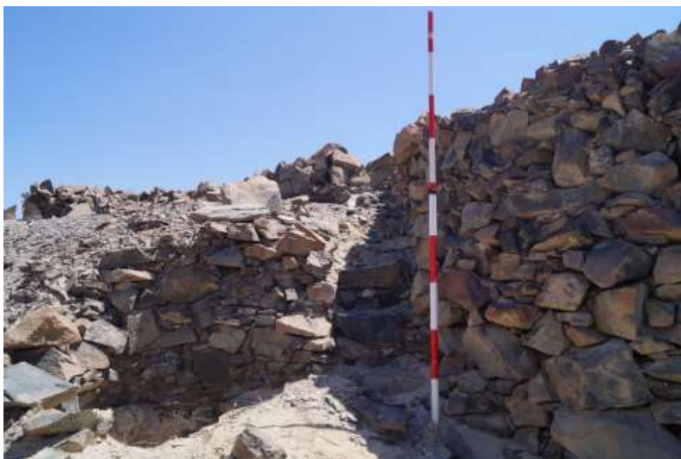
Figura 72: Vista general del acceso escalonado y la cista ubicados en el patio de la estructura 1, unidad arquitectónica N° 04. Fuente: Gaby Pardo Taquiri.
