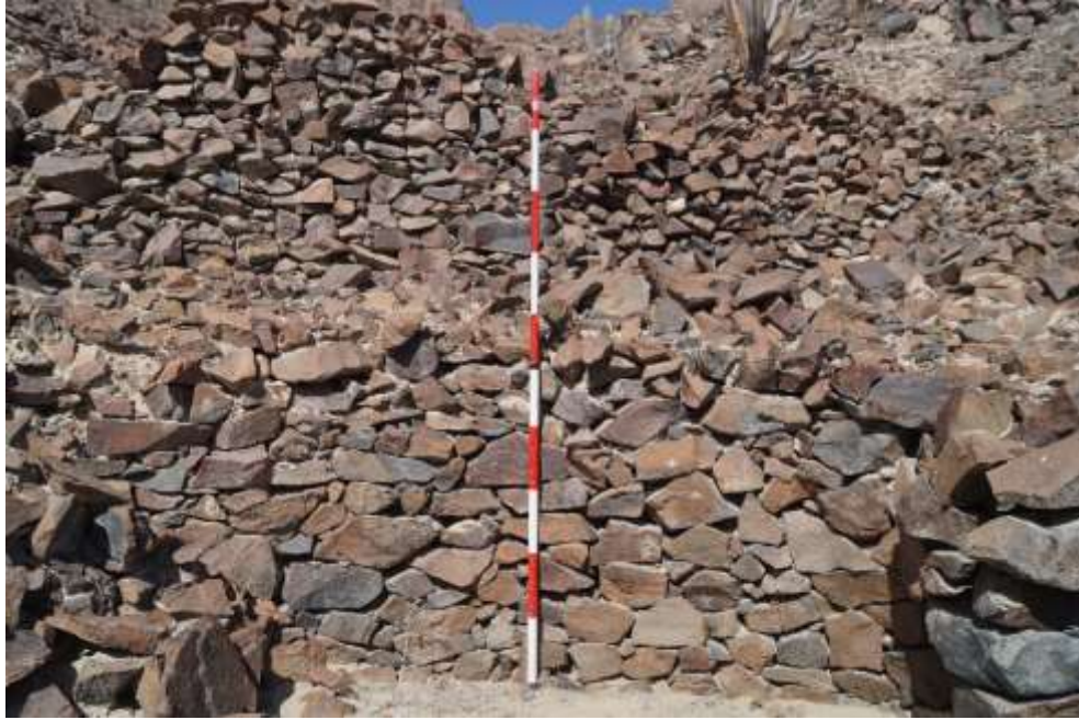
Figura 92: Vista general del primer y segundo nivel de las terrazas, en el sector B. Fuente: Gaby Pardo Taquiri.
