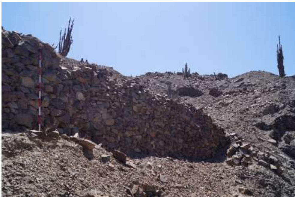
Figura 86: Vista general del muro de contención o de defensa, en el sector C Fuente: Gaby Pardo Taquiri
