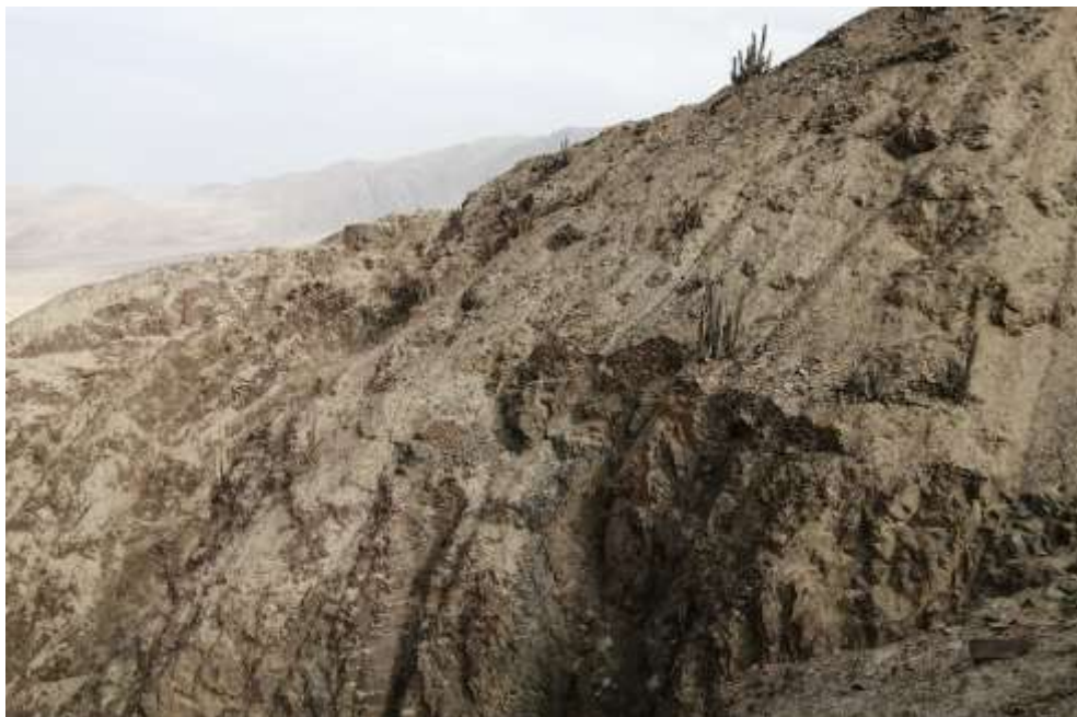
Figura 84: Vista general del muro de contención o de defensa, construido al borde del abismo, en el sector C. Fuente: Gaby Pardo Taquiri.
