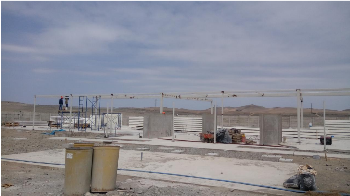
Culminación del montaje de estructuras e inicio de techado de paneles
