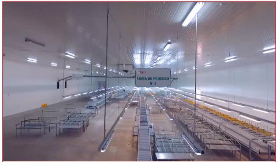
Fig. 5: Construcción sala de procesos, Friopacking SAC
