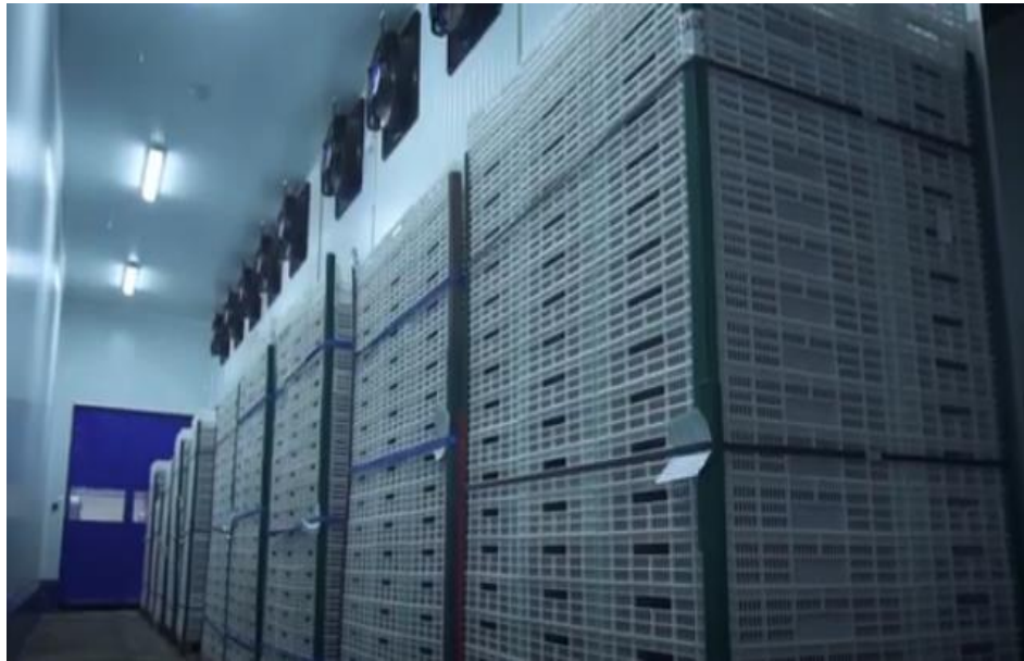
Fig.12: Cámara de almacenamiento del arándano a 0° C
