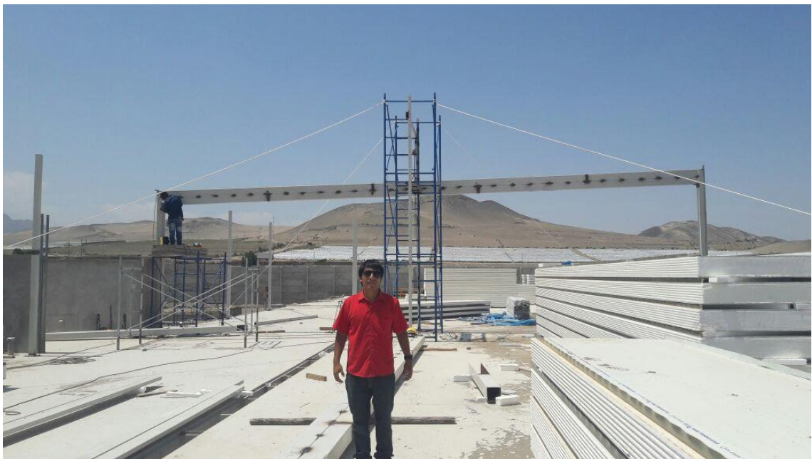
Fotografía, luego de colocar la viga principal de SP
