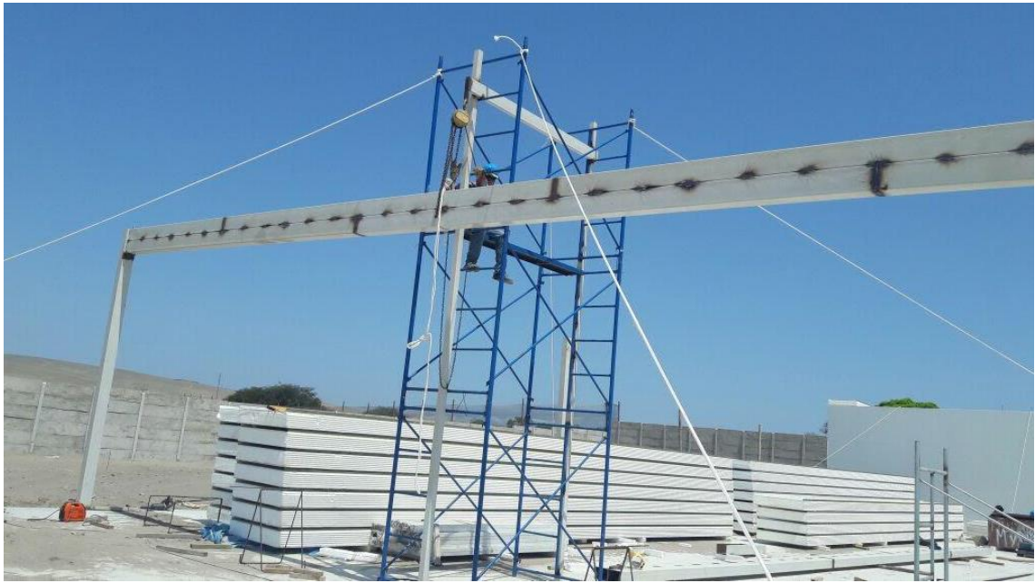
Inicio de la estructura, armado de la estructura que soportará el panel
