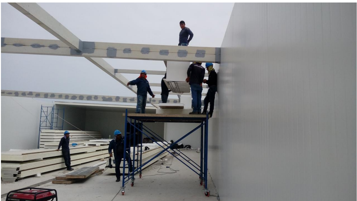
Levantamiento de pared de panel de poliestileno e izaje de equipos evaporadores
