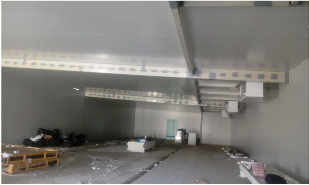
Techado de paneles y como se muestra los equipos ya instalados
