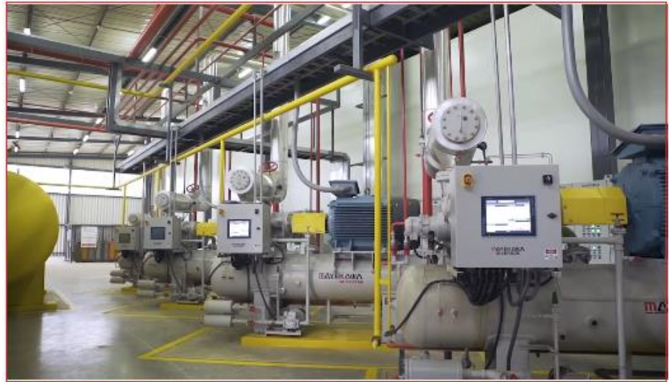
Fig. 4: Ingeniería del frío, instalación de equipos de Friopacking
