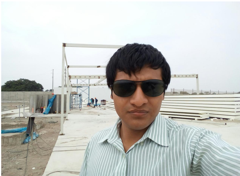
Montaje de la estructura y dar inicio a levantamiento de paneles para las paredes y techo
