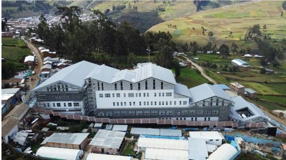
Figura N°7: Vista lateral izquierdo del Hospital de Llata.
