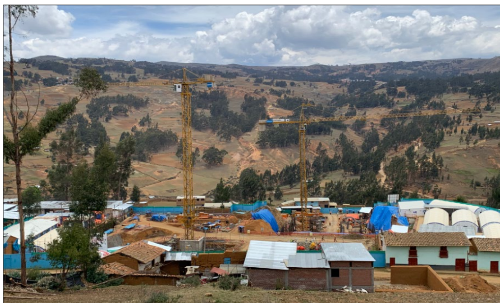
Figura N°10: Proceso de construcción del Hospital de Llata (vista posterior).
