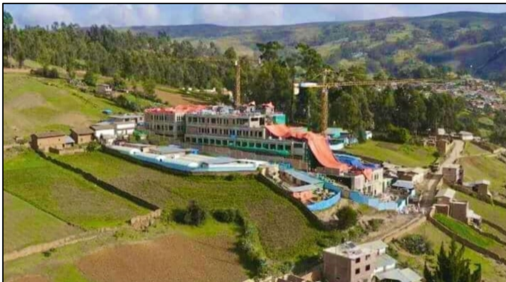
Figura N°9: Proceso de construcción del Hospital de Llata.
