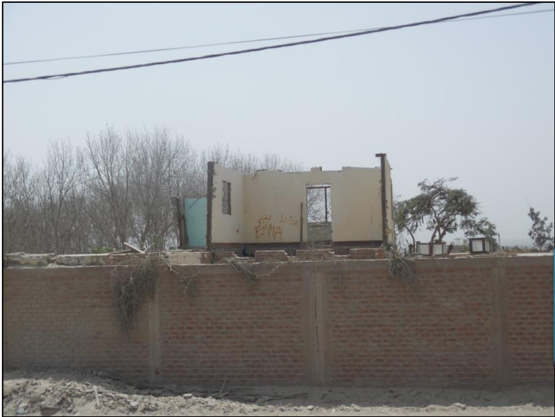
Muro externo reconstruido y zona de residencia La BLANCO
