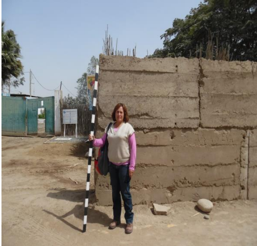
Muro Perimétrico (reconstruido)
