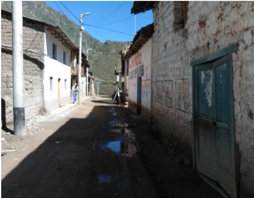
Fotografía 4. Otra vista de la Av. Comercio que muestra el deterioro del afirmado por falta de drenaje durante la temporada de lluvia
