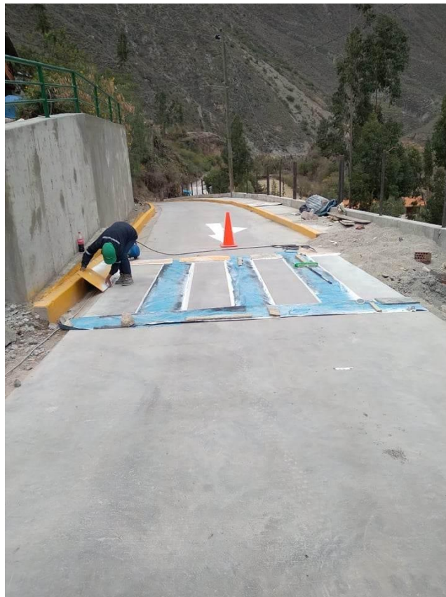
Fotografía 14. Trabajos de Pintura Señales de Tránsito
