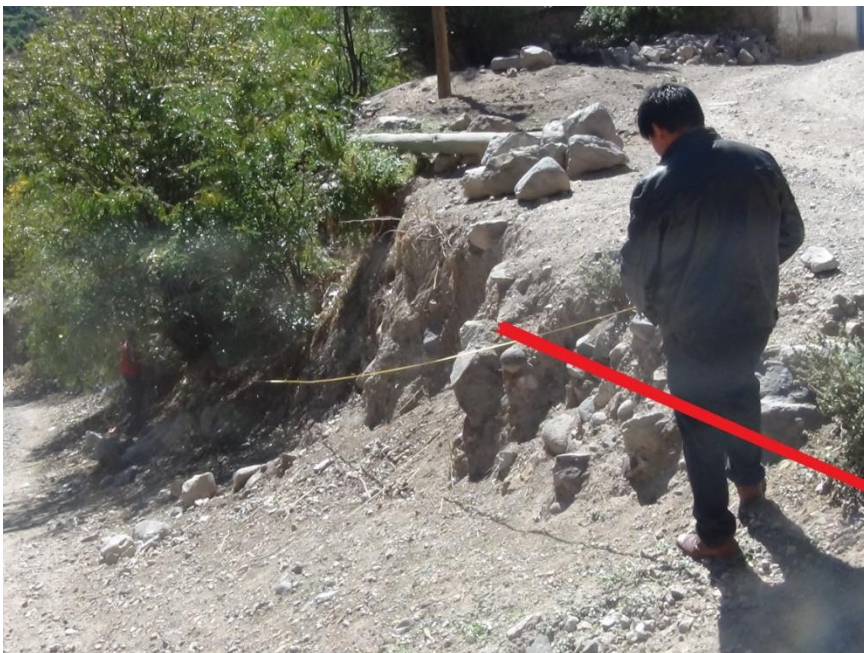
Fotografía 8. Se proyecta muro de contención de 4.0 m entre la Av. Comercio y la entrada al centro poblado de Ampí
