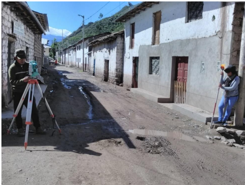
Fotografía 4. Otra vista de la Av. Comercio que muestra el deterioro del afirmado por falta de drenaje durante la temporada de lluvia
