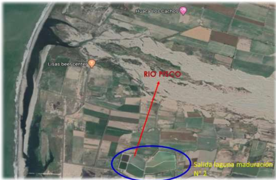
Figura 4. Descarga de efluente PTAR Boca de Rio
