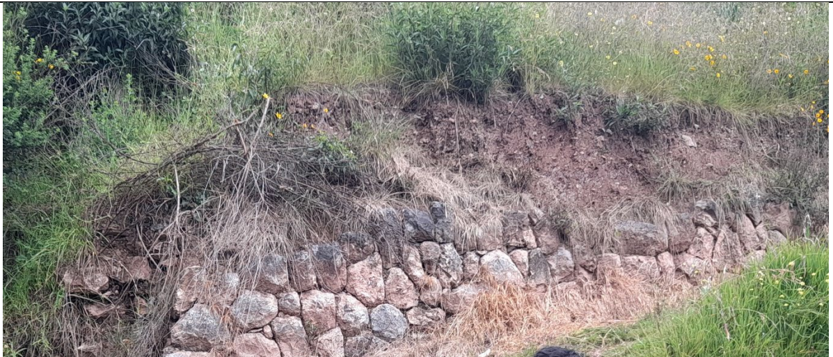
Foto 18: Sección restaurada del paramento del encauzamiento arqueológico del río Saphi. Gessica Cedano; 2022
