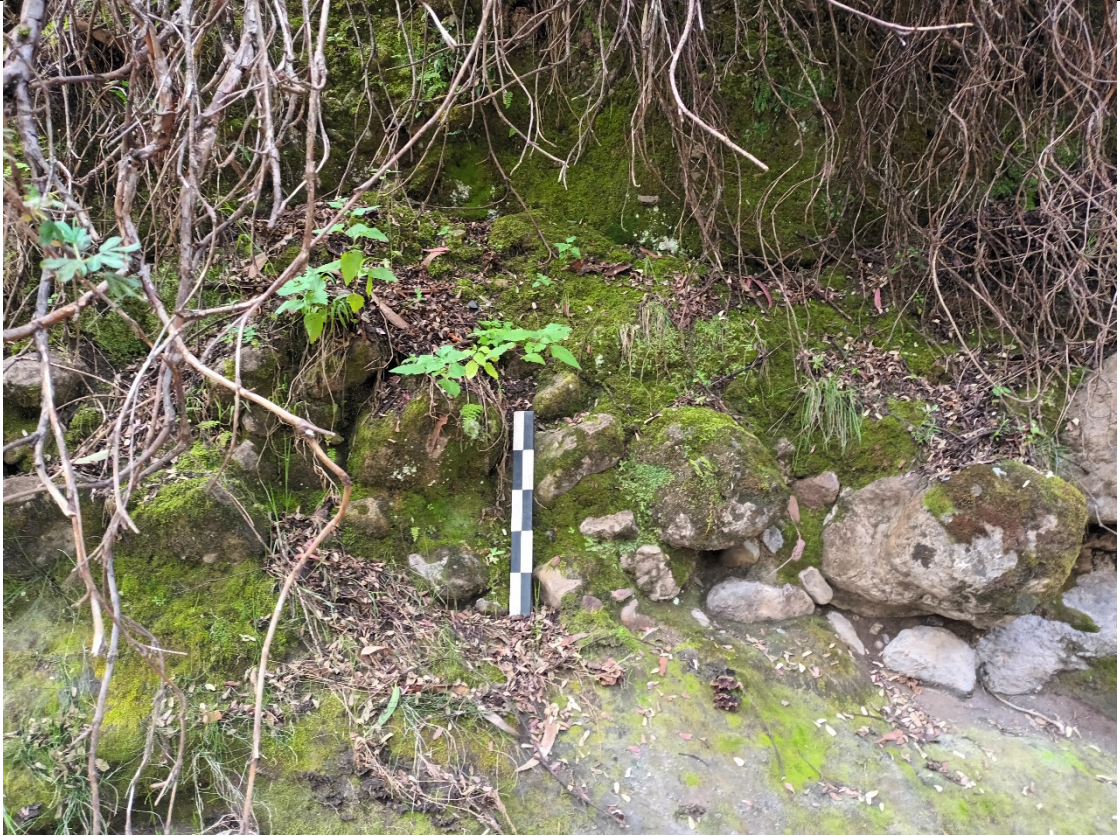
Foto 17: Vista de la sección inferior del paramento del encauzamiento arqueológico, conformado por piedras grandes. Gessica Cedano; 2022
