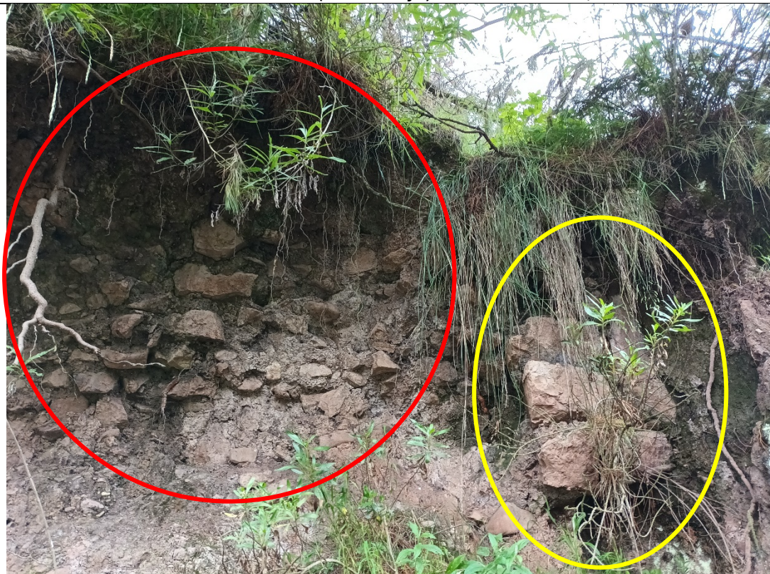
Foto 14: Vista de una sección del paramento el encauce arqueológico (círculo amarillo) y del relleno constructivo (círculo rojo). Gessica Cedano; 2022
