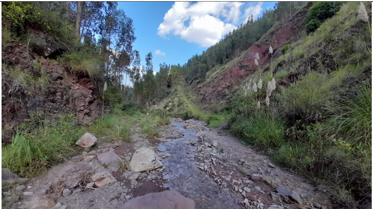
Foto 06: Lecho del río Chacan con un margen estable (de composición rocosa) y un margen inestable (de composición arcillosa). Gessica Cedano; 2022
