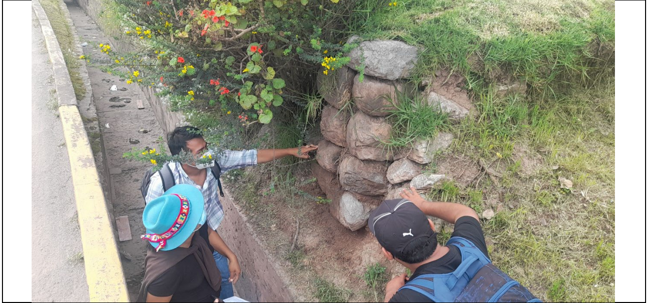
Foto 19: Sección del encauzamiento del río Cachimayo en la misma ciudad del Cusco. Nótese el encauzamiento moderno de cemento en la sección inferior. Gessica Cedano; 2022
